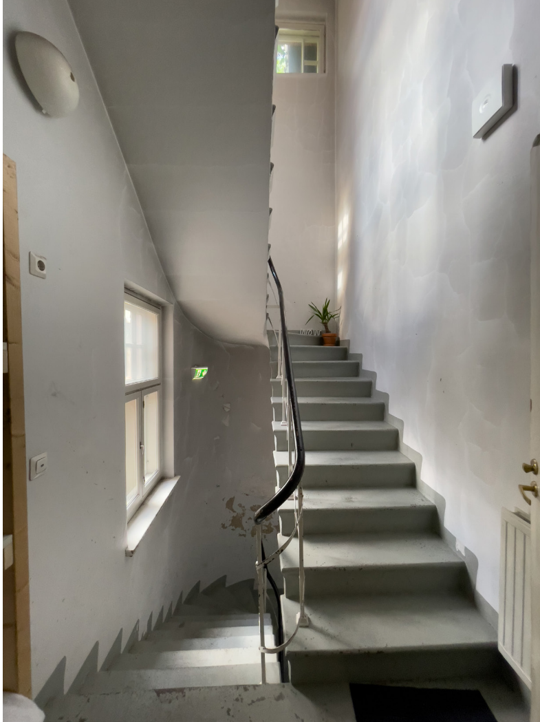
Juhlasalin takana sijaitseva betoninen hätäpoistumisporras.
