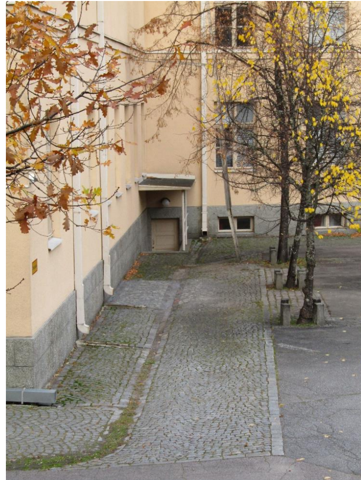
Kuva 28. Rakennuksen vierustan kiviladontoja, jotka saattavat olla peräisin eri aikakausilta. Kiveys on liitetty asfalttipintaan. (kuva A.P.)
