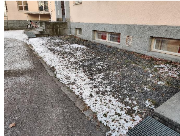
Kuva 31. Sisäpihan porrasyhteyksien välissä on nupukivellä rajattu murskepinta. (kuva T.T.)
