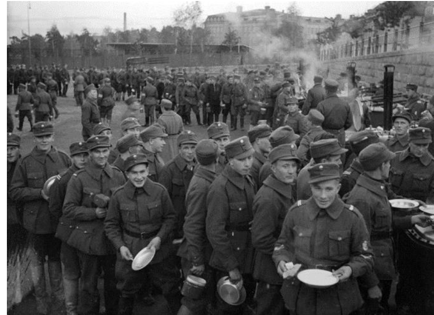
Kuva 11. Kuva koulun pihalta 18.10.1939, jolloin koulurakennus oli otettu reserviläisten majoituspaikaksi. Taustalla näkyvät selvästi pihaa reunustavat luonnonkivitukimuurit sekä tukimuurin päällä sijaitseva suoja-aita. Katupuuistutuksia on jo sekä Lyseokadun että Kisakentänkadun varrella tukimuurin takana. (Tampereen museot, Vapriikin kuva-arkisto, Sulo Markkanen)
