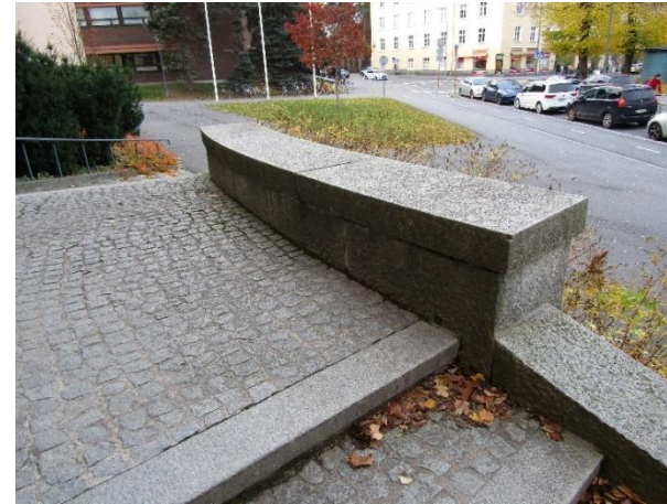
Kuva 35. Pääsisäänkäynnin massiivista portaikkoa ja sisäänkäynnin edustan noppakiveystä lähikuvassa. Myös porrasaskelmien taustat on päällystetty noppakivillä. (kuva A.P.)
