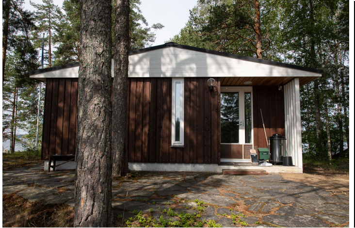
Asuinrakennuksen kaakkoispääty, jossa on vuonna 1991 tehty laajennus.
