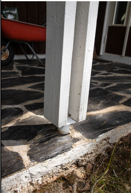
Asuinrakennuksen terassin pilari.
