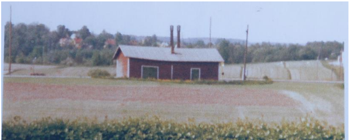
Kuva 38. Takahuhtintien varressa ollut vanha kuivaamo, joka purettiin 1970-luvulla. Kuivaamon takana näkyy Takahuhtintie ja sen takana Kokon 2000-luvun taitteeseen asti avoimena säilynyttä peltoaukeaa. Pellon takana näkyy junaradan takaista Rautapellonmäen asutusta Messukylässä. Irjalankatu jää kuvan oikealle puolelle ja Takahuhtintien varren rintamamiestalon vasemmalle puolelle. Kuvälähde: kohteen omistajien kotialbumi.
