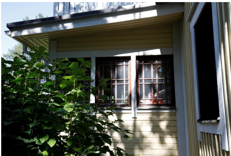
Kuva 19. Vanha päärakennus, detalji: kuisti. Kuistin ikkunat joko ovat alkuperäiset tai korkealaatuinen jäljitelmä. Ruutujako vastaa alkuperäistä.
