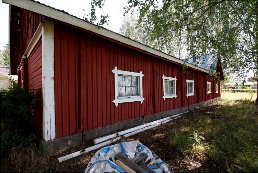
Kuva 22. Navetta. Kadun suunnalla oleva julkisivu on pystylaudoitettu, pihalle jäävät seinät ovat raakaa hirsipintaa. Följarit luovat seinälle klassistisen rytmityksen.
