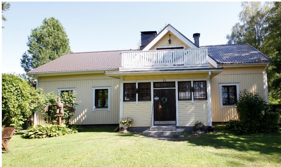
Kuva 21. Päärakennus, julkisivu lounaaseen. Ikkunoiden koristelaudoitus ei vastaa alkuperäistä, muutos on joko tapahtunut peruskorjauksen yhteydessä (1982) tai myöhemmässä dokumentoimattomassa korjauksessa.
