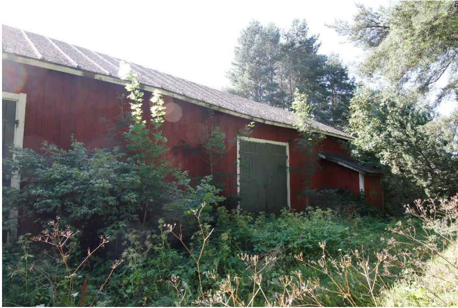
Kuva 31. Entinen puimala, pihan puoleinen julkisivu.
