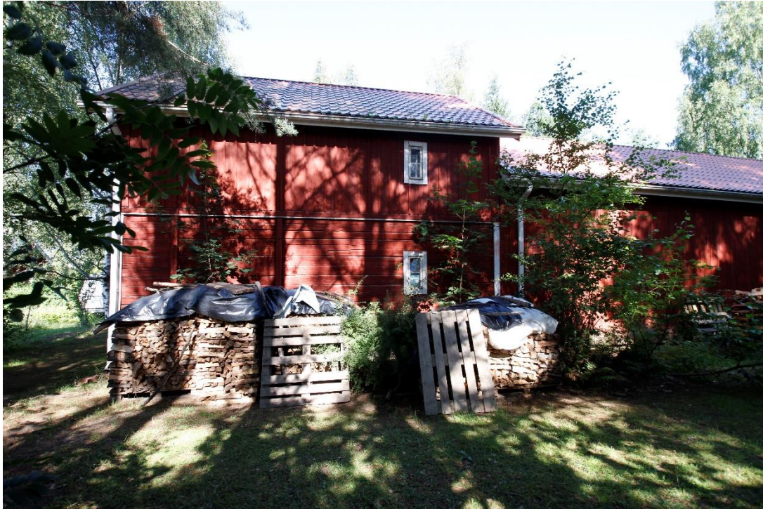
Kuva 27. Aitta / puuvarasto, Kokonkadun puoleinen takajulkisivu.
