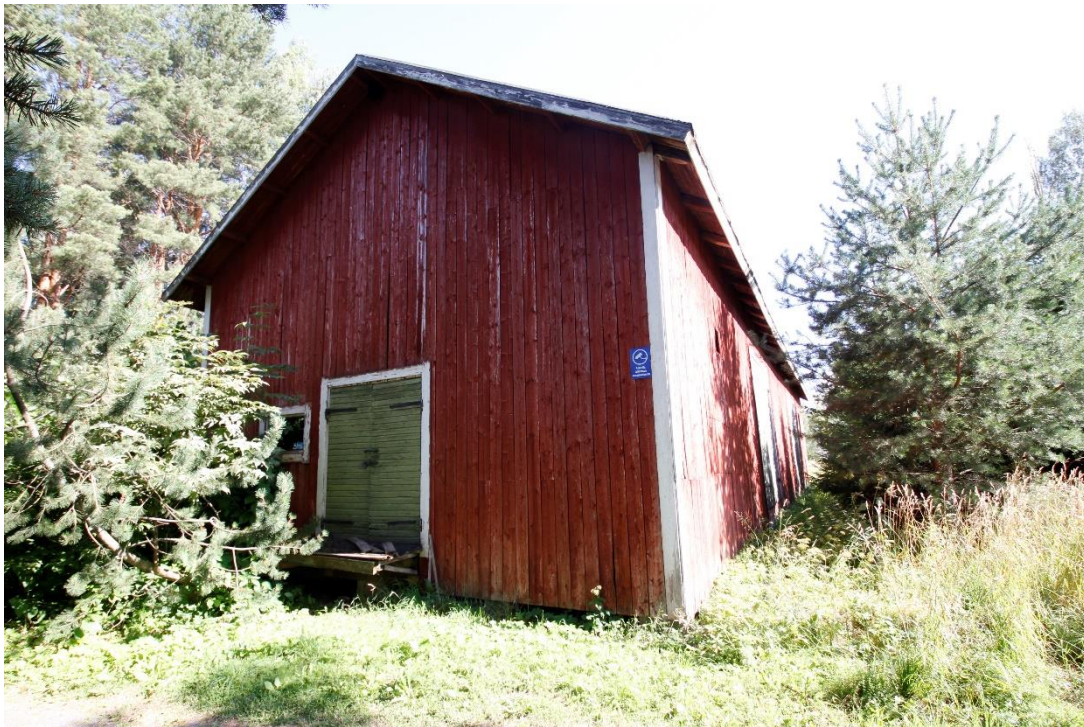
Kuva 32. Entinen puimala, kadun puoleinen julkisivu. Rakennuksen ympäristö on kasvamassa umpeen, eikä rakennus ja sen rooli pihapiirissä hahmotu selkeästi kadulla kulkevalle.
