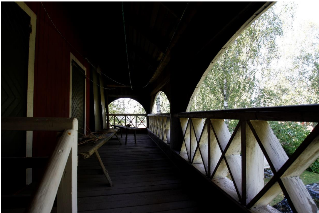
Kuva 28. Aitta / puuvarasto. Toisen kerroksen luhtikäytävä, koristeelliset kaiteet ja arkadi.
