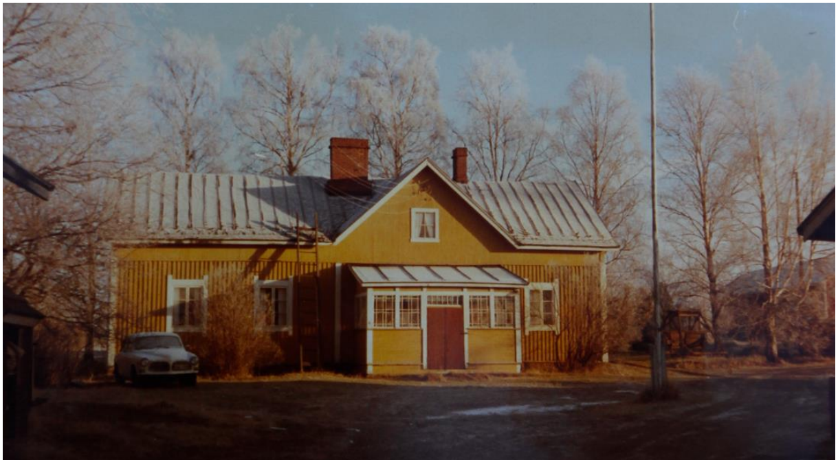
Kuva 36. Ajoittamaton värikuva Kokon päärakennuksesta. Rakennus on kuvassa kartanonkeltaiseksi maalattu. Listoitus ja ikkunoiden puitteet ovat valkoiset, ovi tummanruskea laudoitettu pariovi. Kuistin katolta on poistettu kattolyhty. Päärakennuksen takana kasvaa rivissä kookkaita koivuja. Kuvan vasemmassa laidassa näkyy karjakeittiön kattoa ja oikeassa laidassa navetan kattoa. Navetan takaa näkyy luhtiaitta. Kuvalähde: kohteen omistajien kotialbumi.
