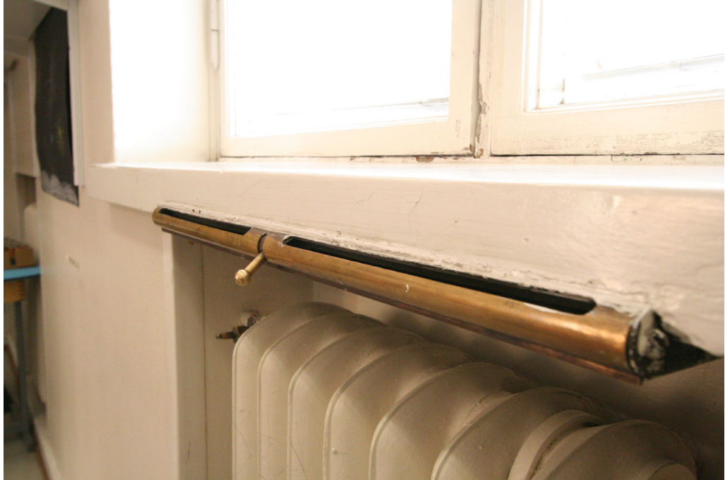
Kuva: Ikkunan tuuletusventtiili
