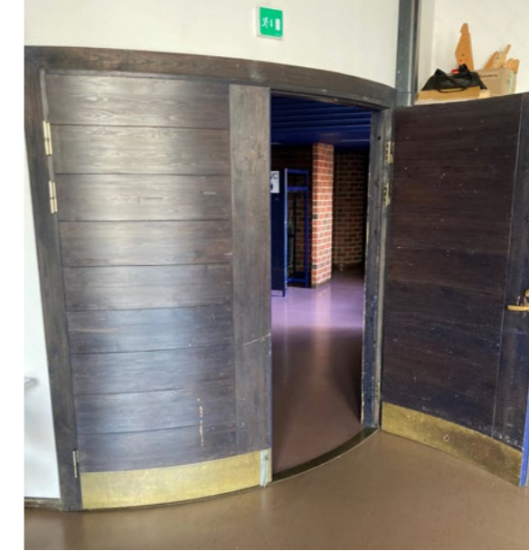
Rakennuksen kaakkoi- ja luoteiskulmissa siaitseviin huoneisiin kuljetaan kaarevien ovien kautta. 'Pääovissa' toistuu messinkidetaliikka, laudoitus ja puun materialiteetti.
