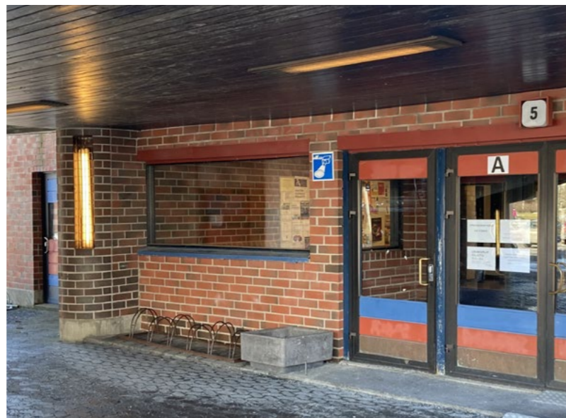
Rakenteisiin integroituja ritilöillä suojattuja valaisimia ja sisäänkäynti A, joka sijaitsee pääsisäänkäynnin alapuolella 1. kerroksessa.
