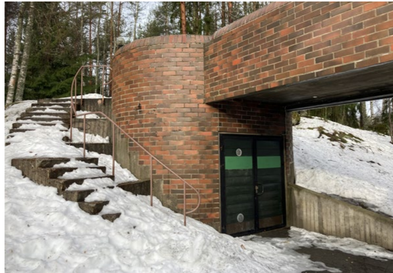
Kirkon toimistotiloihin johtava kulkusilta ja siihen liittyvä varasto.
