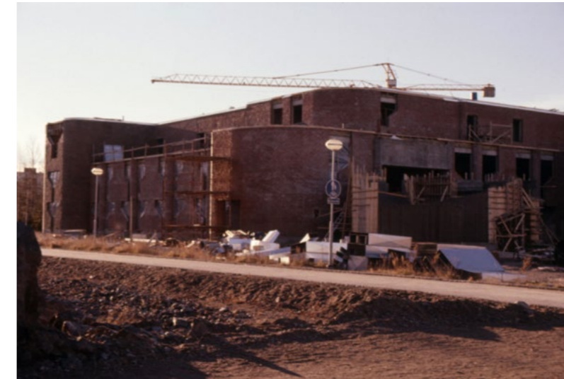
Vapaa-aikakeskus rakenteilla vuonna 1978, kuva pääsisäänkäynniltä. Tampereen Vapriikin Siiri kuva-arkisto
