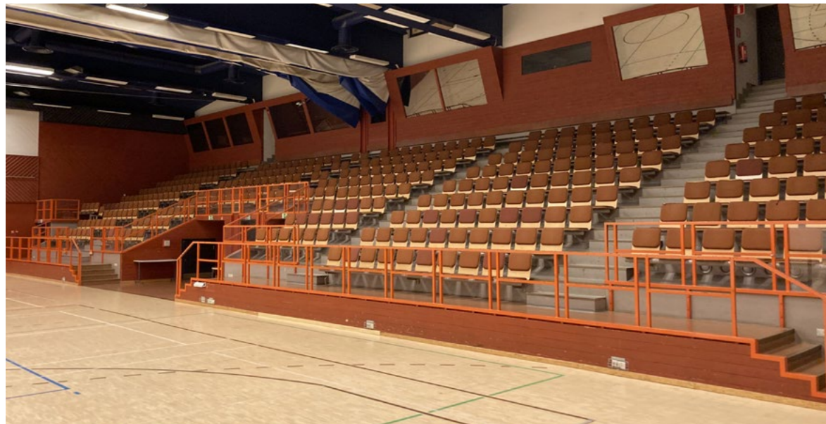
Ison liikuntasalin katsomo. Huomaa vinoseinäiset tilat katsomon takana. Katsomon tuoleja on vaihdettu uusiin tarpeen mukaan, ja taaimmainen rivi on muutettu yksittäisistä tuoleista istuinlauteeksi korvaavien tuolien saamiseksi.
