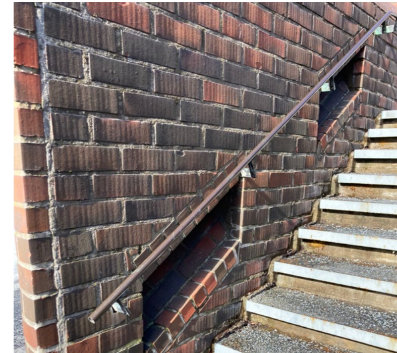
Rakenteisiin integroituja valaisimia kirkkopihalla.
