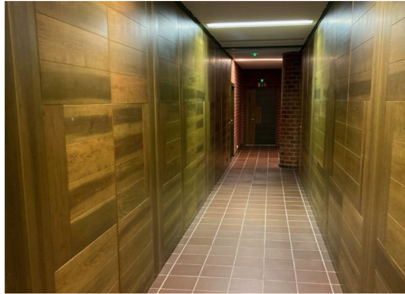
Siirtoseinät aikuistyön tilan ja kirkkosalin välillä muodostavat käytävän.
