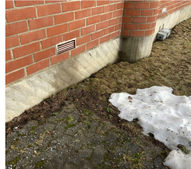
Sokkelissa erottuu tarkoituksella tehty vinon betonilautoituksen kuvio.
