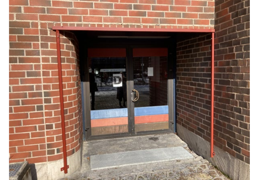
Ahvenisjärven kaakkoispuolen sisäänkäynnin tiilimuurauksen hätäkorjaus.
