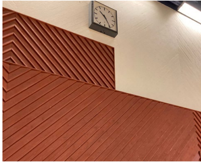
Liikuntasalin tärkeimmät pinnat ovat puuverhoillut seinät, jotka toistavat betonivalumuottien jättämää pintaa.
