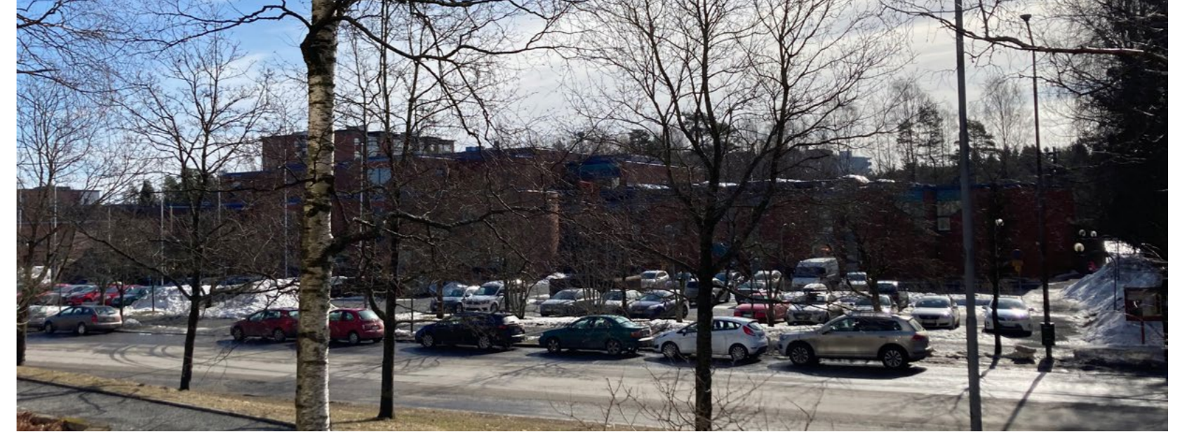
Seurakunta- ja vapaa-aajan keskus hahmottuu suurena koulun kaltaisena julkisena rakennuksena Lindforsinkadun puolelta.
