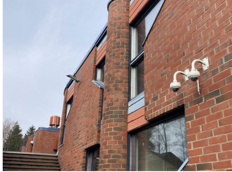
Julkisivuun kiinnitettyjä valaisimia ja valvontakameroita, jotka tulisi maalata ruskeiksi tai punaisiksi, jotta ne eivät hyppäisi julkisivusta niin korostetusti esiin.
