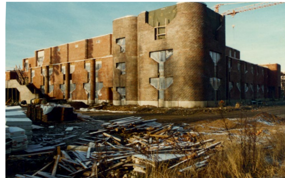
Rakenteilla oleva vapaa-aikakeskus tulevalta Valtaraitilta päin. Tampereen Vapriikin Siiri kuva-arkisto
