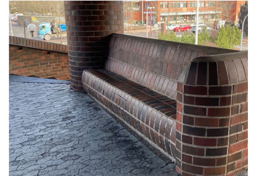
Pääsisäänkäynnin kiinteät tiili-istuimet.
