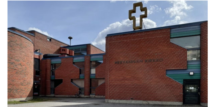
Lindforsinkadun puoleinen seurakuntasalin "taka" julkisivu, jossa jälkiasennettu risti merkitsee kirkkotilojen sijainnin. Risti lisättiin katolle 2000-luvun alussa. Uuden ivk-huoneen yläpuolelle on lisätty tekniikkaa, joka on säilytetty rakennuksen värimaailmaan.
