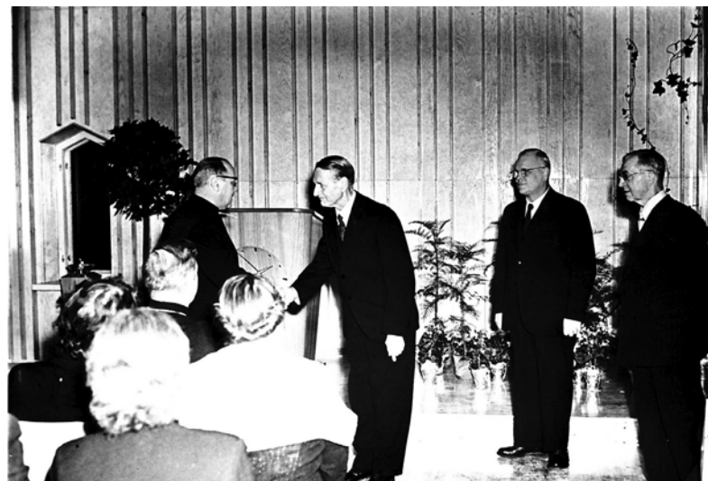
Seurakuntatalo sivurakennuksen asunnon puolelta kuvattuna 1950-luvulla (yllä). Alla kuva seurakuntatalon vihkimistilaisuudesta 19.12.1955. Tampereen ev.lut. seurakuntayhtymän arkisto.
