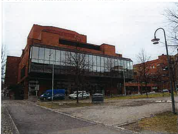
Julkisivu itään, rakennuksen eteläpääty
