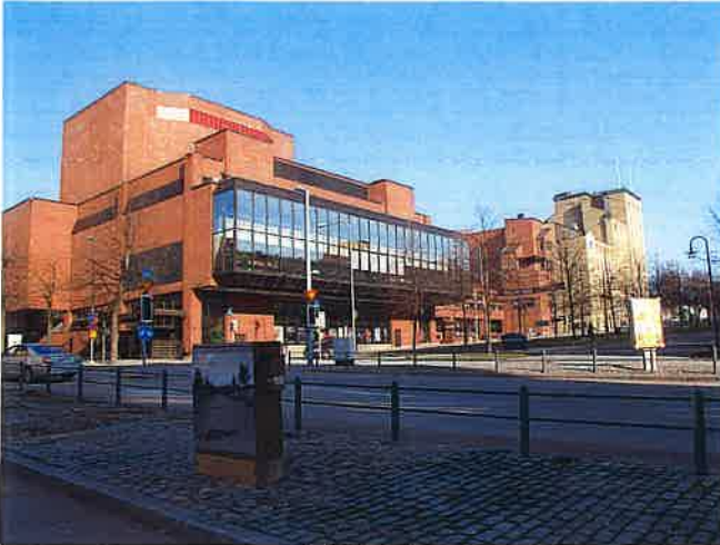
Hämeenpuiston puoleinen julkisivu, kuvattuna etelästä päin. Heli Haavisto 25.04.2012 10:14:44
