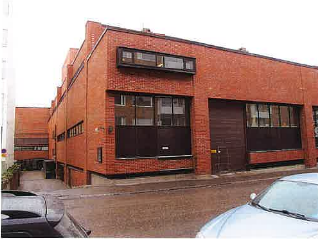
Julkisivu länteen Papinkadun varrella
