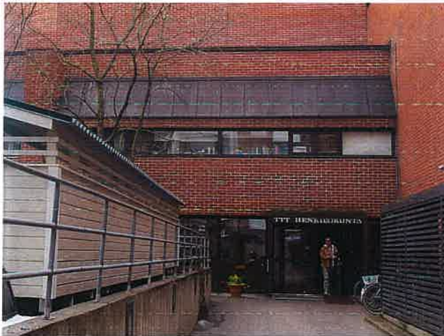
Papinkadun puoleinen sisäänkäynti
