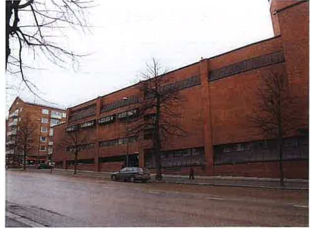
Julkisivu etelään, länsipääty
