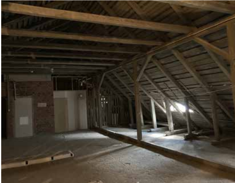
Ullakon muuttaminen asuinkäyttöön olisi mahdollista voimassa olevan asemakaavan puitteissa rakennuksen alkuperäistä henkeä kunnioittaen. (Valokuvat: Neva Arkkitehdit / Jurkka Pöntys 2020.)
