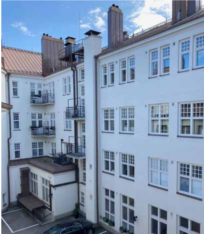
Alla oikealla: Sisäpihan värisävy ennen julkisivun rappauksen maalausta. Valokuva: Pirkanmaan maakuntamuseo). Vasemmalla sisäpihan vuonna 2016 uusittu valkoinen rappaus nykyään. Huomaa myös piippujen pellitykset. Valokuva: Neva Arkkitehdit / Jurkka Pöntys 2020.
