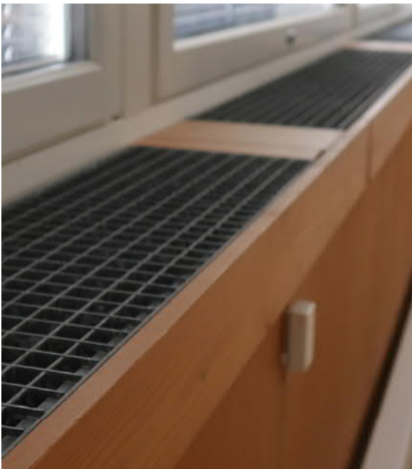
Ervi suunnitteli toimistohuoneiden ikkunoiden alle koteloitun rakenteen, jonka sisään sijoitettiin ilmastointi- ja lämmitysjärjestelmä.
