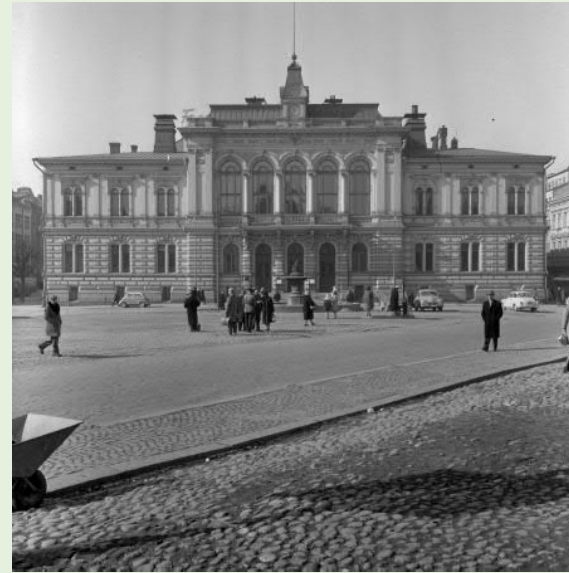
Raatihuoneen restaurointi 1960-luku
