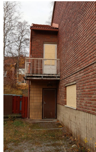
Ilmarinkadun puolen kellariin johtavaa ovea on käytetty luvattomaan kulkuun, mutta se on säilynyt ehjänä.
