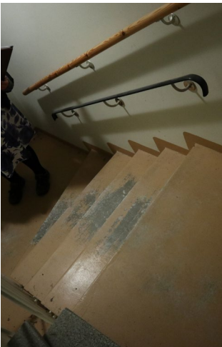
Ilmarinkadun puolen kellarin ja yhdyskäytävään johtava portaikko on pinnaltaan kulunut.
