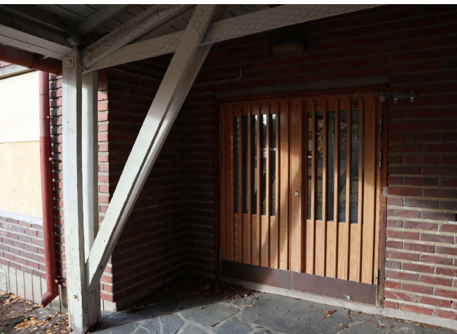
Yhdyskäytäväkatoksessa sijaitseva pihanpuoleinen sisäänkäynti läntiselle Saukonpuiston puolelle.
