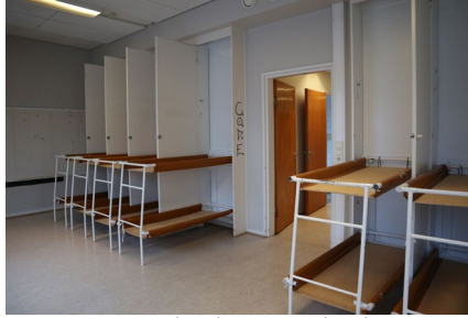
2. Puiston puolen länsipäädyn huone on säilynyt pintoja lukuunottamatta alkuperäisenä. Sängyt ovat paikoillaan, ovet ja ikkunat ovat alkuperäiset, ja seinällä on alkuperäinen hylly.
