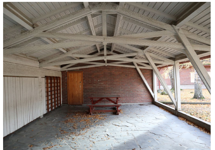
Pihanpuoleinen sisäänkäynti Ilmarinkadunpuolen lastenvaunuvastoon, jonka kautta pääsee sisätiloihin ja rakennuksen toiselle puolelle.
