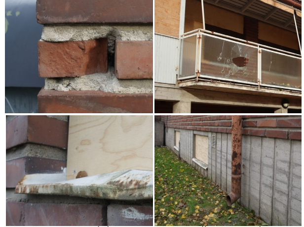
Pieniä vaurioita lukuunottamatta julkisivut vaikuttavat pääosin hyväkuntoisilta.
