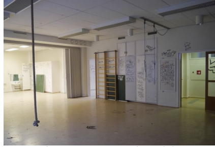
3. Saukonpuiston puolen liikuntasalissa on alkuperäiset ovet, komerot ja puolapuut. Alkuperäinen siirtoseinä on korvattu paljeovilla, mutta tilajako on säilynyt. Pinnat on uusittu ja sotkettu.
