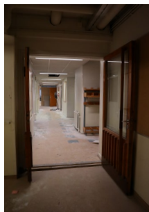
7. Ilmarinkadun 1. kerroksen käytävätilaa on muokattu paljon. Ovet ovat kuitenkin pääosin alkuperäisiä.
