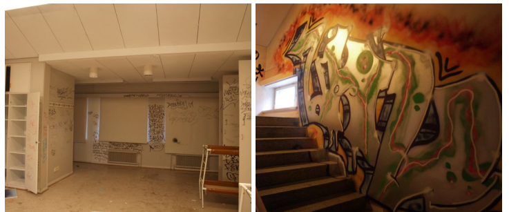
Sotkettuja pintoja läntisen Saukonpuiston puolen 2. kerroksessa.
