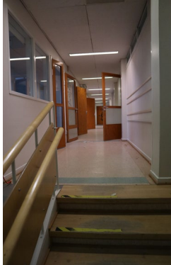
6. Saukonpuiston puolen 1. ja 2. kerroksen käytävissä on säilynyt paljon alkuperäisiä ovia ja alkuperäiset portaat, joiden yhteyteen on lisätty luiska.
