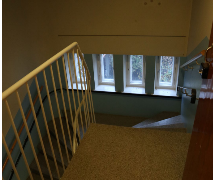
Ilmarinkadun puolen porrashuoneen ikkunat
