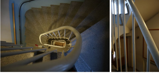
5. Porrashuoneissa on alkuperäiset pinnat. Ilmarinkadun porraskaidetta on korotettu, mutta korotusta ei huomaa ellei erikseen etsi saumojen jälkiä.
