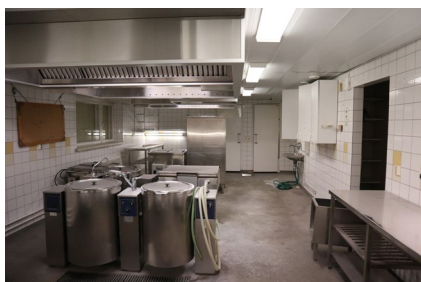
9. Uusittu keittiö puiston puolen kellarissa.
