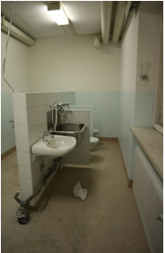
8. Ilmarinkadun 1. kerroksen wc
