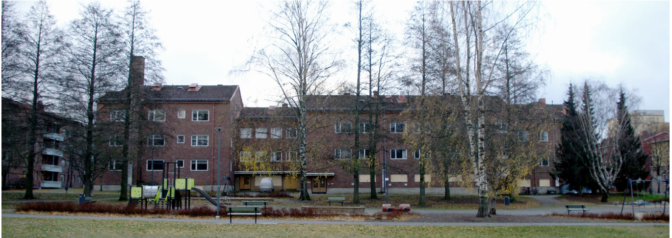
Näkymä pohjoiseen Saukonpuistoon päin
