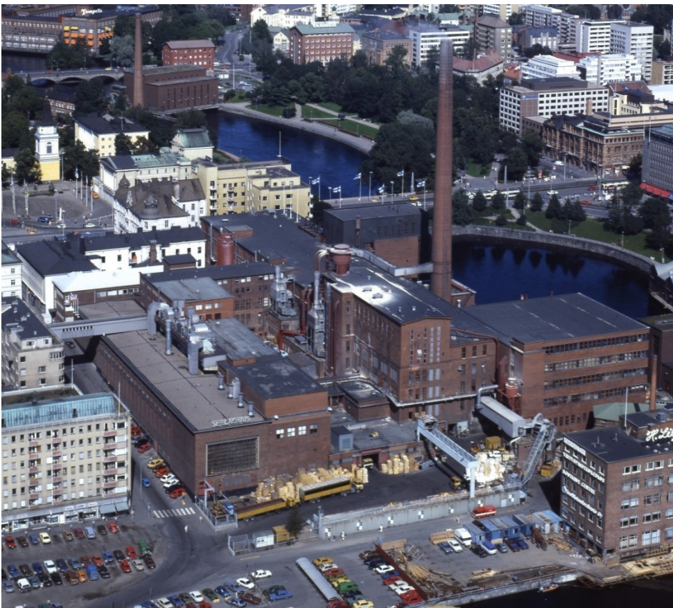
TAKO: on tehdas Scan Foton kuvaamana kesällä 1985. Laukontorin puoleisella julkisivulla ei vielä ole punaisia säiliötorneja. Kuva: Vapriikin kuva-arkisto.
