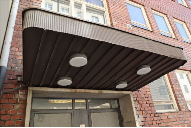
Kuva vasemmalla: Kirkkokadun puoleisen sisäänkäynnin poimukuparilippa, jossa neljä keskenään samanlaista pyöreää valaisinta. Kuva oikealla: Kivijalka on mustaksi maalattua, uritettua betonia.
