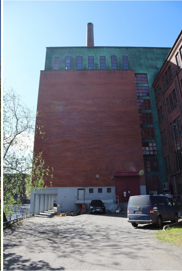
Kattilahuoneen julkisivu koostuu alaosan vaaleanharmaasta betoniosasta, korkeasta punatiiliosasta ja yläosan vihreästä kuparilevystä.
