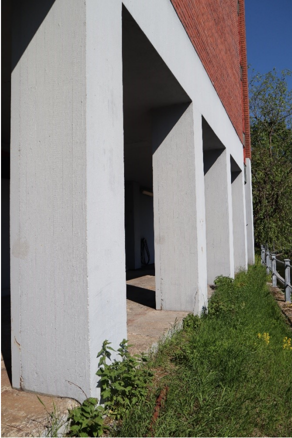
Kattilahuoneen julkisivu koostuu alaosan vaaleanharmaasta betoniosasta, korkeasta punatiiliosasta ja yläosan vihreästä kuparilevystä.
