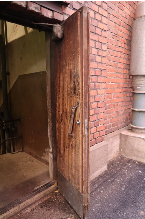
Kuva yläpuolella: Takon tehdasrakennuksien polveilevaa ja mittasuhteiltaan erikokoista rakennusmassaa. Kuva alapuolella: Rakennuksen julkisivut ovat tiiltä. Tässä rakennuksessa, joka sijaitsee kattilahuoneen eteläpuolella, kivijalka on betonia. Ovi on puuovi, mahdollisesti 1950-1960-luvulta.
