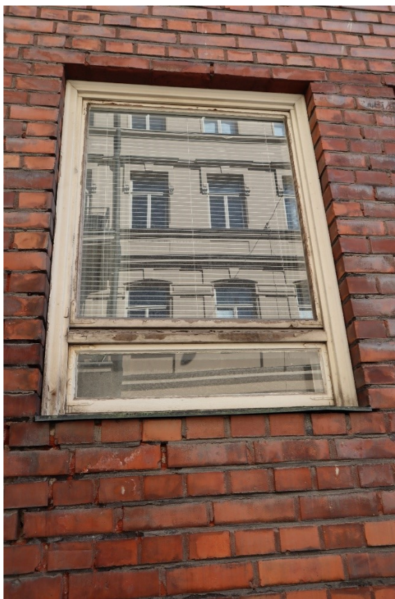
Kuva vasemmalla: Kirkkokadun puoleinen sisäänkäynti poimupelttilipalla ja rappukäytävään aukeavilla korkeilla ikkunoilla. Kuva oikealla: Kaksiruutuinen puikkuna, josta alaosaa toimii tuuletusikkunana.
