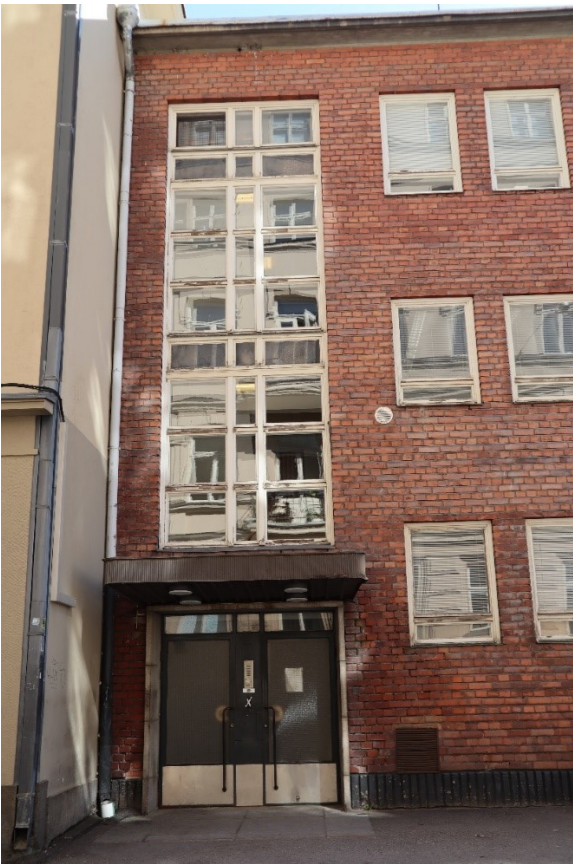
Kuva vasemmalla: Kirkkokadun puoleinen sisäänkäynti poimupelttilipalla ja rappukäytävään aukeavilla korkeilla ikkunoilla. Kuva oikealla: Kaksiruutuinen puikkuna, josta alaosaa toimii tuuletusikkunana.
