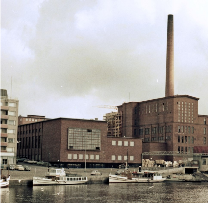
Tehdassali kuvattuna Laukontorilta 21.11.1961. Kuvassa näkyy rakennustelineitä tehdassalin takana. Punaisia tynnyrisäiliöitä ei vielä ole, vaan maisema on punatiilivoittoinen. Myöskään piha-aluetta ei ole korotettu eikä aidattu nykyisen kaltaiseksi. Kuva. E.M.Staf1961/ Vapriikin kuva-arkisto.
