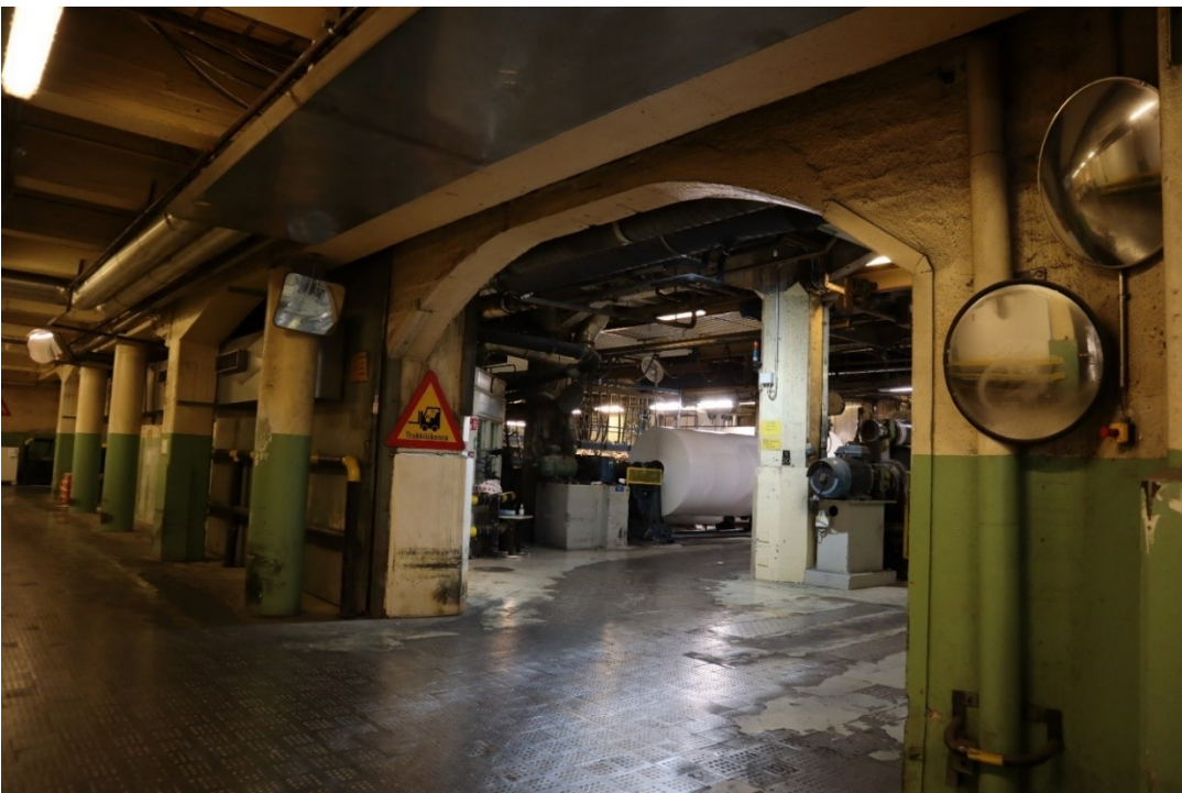
Seinäpinnat ovat joko muottibetonipintaisia tai tiilipintaisia. Sisätiloissa näkyy runkorakenne, joka perustuu betonipilareihin ja -palkkeihin. Sisäkatot ovat ylälaattapalkistolla vahvistettuja.
