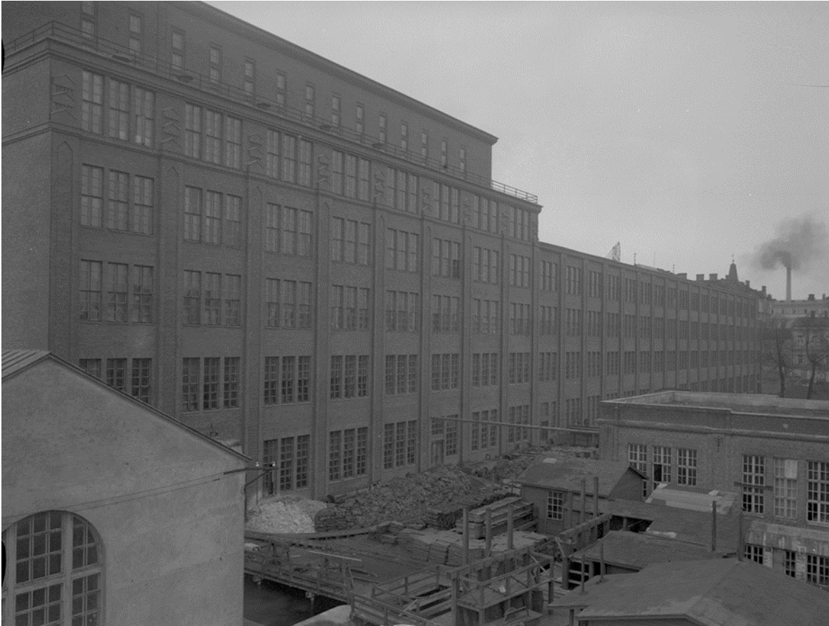
Takon tehdasrakennukset kosken länsirantaan valmistuivat 1930-luvulla. Tässä kuvassa näkymä tehdasalueelle 1.11.1933. Etualalla näkyy vuonna 1923 valmistunut Birger Federleyn suunnittelema tehdasrakennus, jota ei ole vielä korotettu. Kuva: Vapriikin kuva-arkisto.
