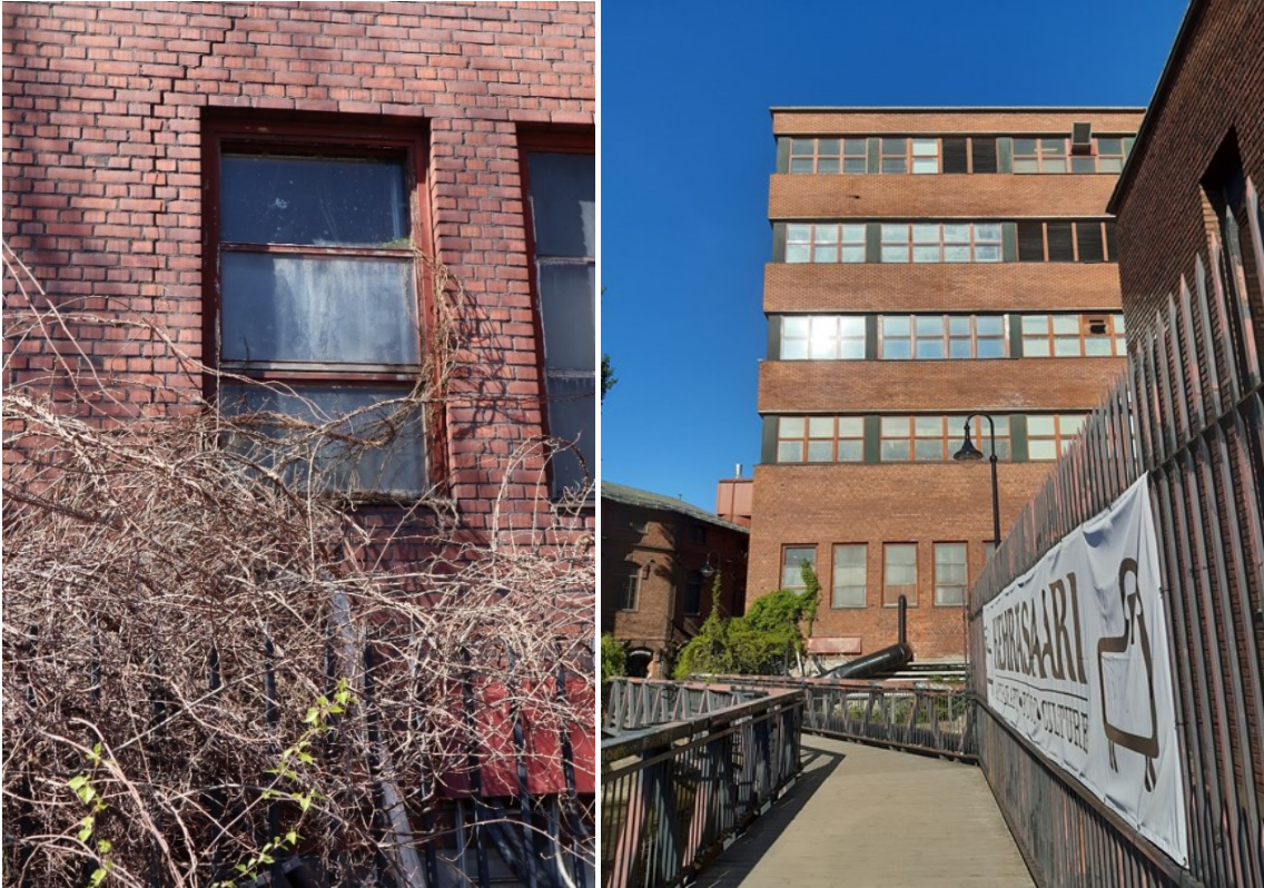
Pulperitalon ikkunat kulkevat julkisivun kanssa tasassa ja erityisesti ylemmissä kerroksissa korostuu ikkunoiden nauhamaisuus. Tässä kuvassa alkuperäiset, kolmiruutuiset puuikkunat. Pulperitalo kuvattuna alavoimalan edessä kulkevalta kävelysillalta. Julkisivut ovat tiiltä, ylempien kerrosten ikkunat kulkevat nauhana. Ikkunarivistöä rytmittää vihreä kupari levyt.
