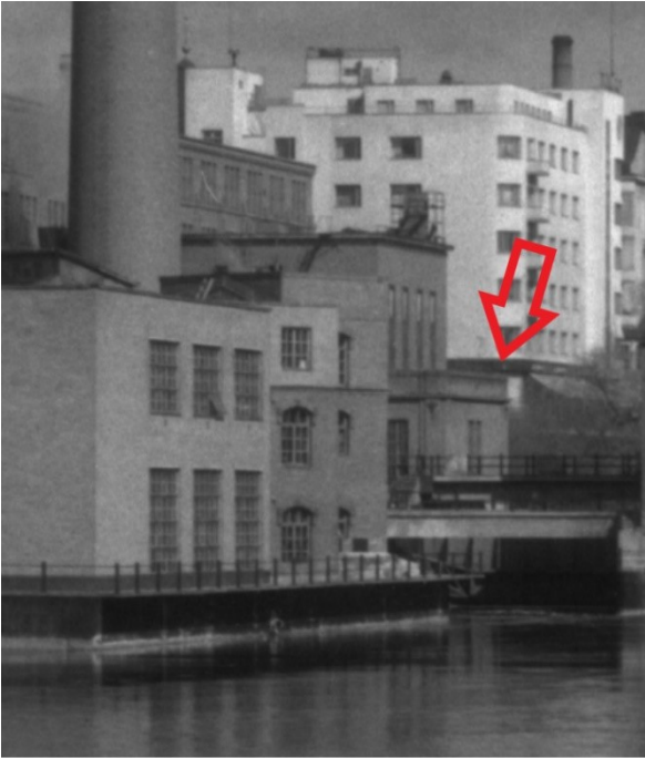
Kuva yläpuolella: Tehdassali W.M. Gestrinin kuvaamana 1940-luvulla. Kuvasta näkee, että rakennus toteutui Birger Federleyn piirustusten mukaisesti 1920-luvulla, mutta julkisivu muuttui jonkin verran Strömmerin suunnittelemien muutosten johdosta. Lähde: Vapriikin kuva-arkisto.
