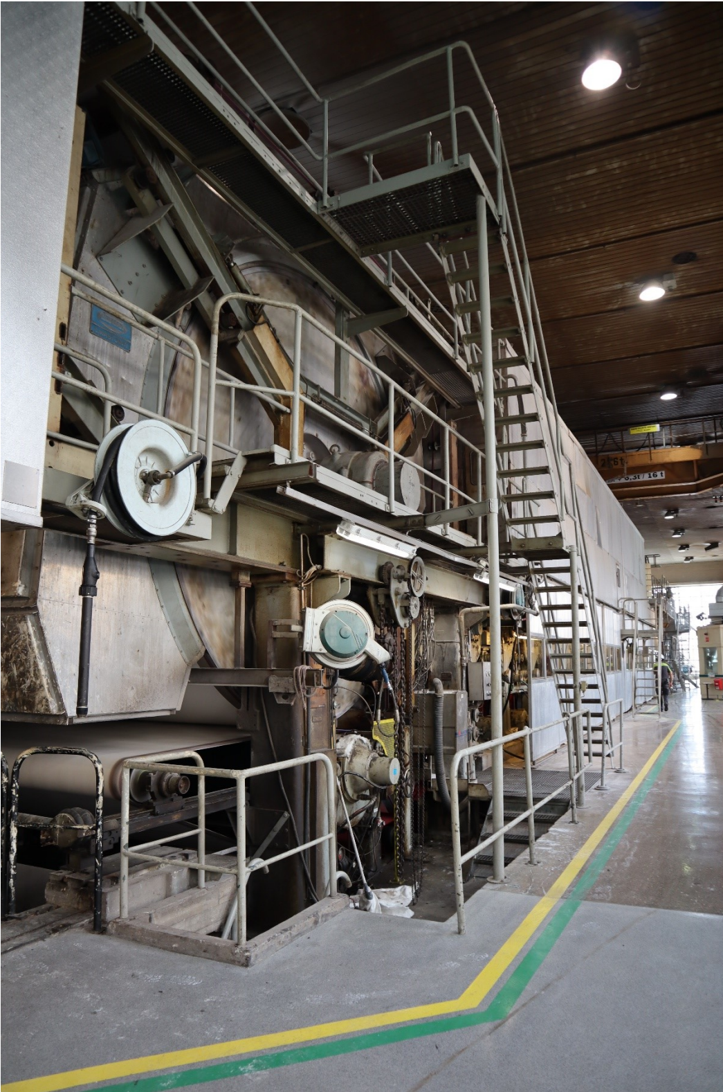
Karttonkone 3 eli KK3 tehdassalissa Kirkkokadun varrella kuvattuna pohjoisesta kohti etelää. Tuotanto tapahtuu kuitenkin etelä-pohjoissuunnassa.
