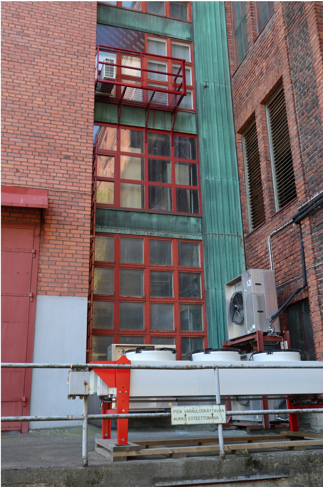
Voimalaitoksen vaihtelevaa julkisivumateriaalia; betonia, punatiiltä ja vihreää kuparilevyä.
