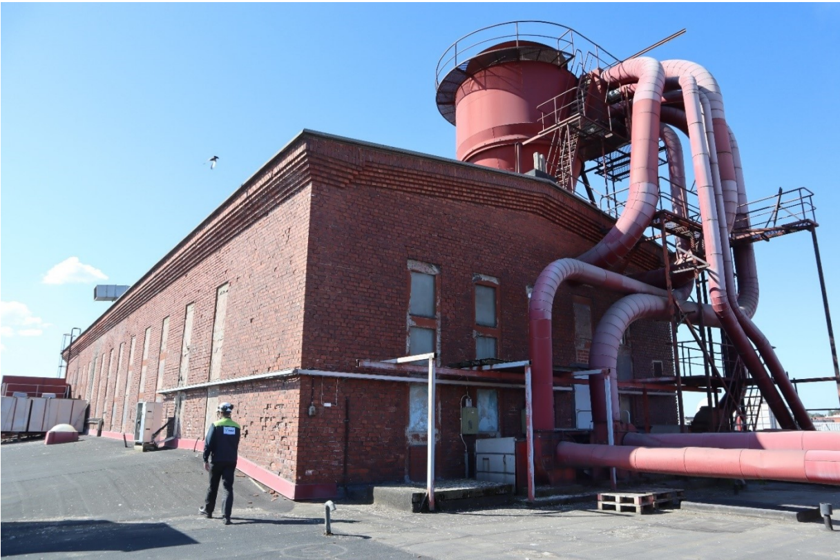
Ylin kerros kuvattuna katolta. Katemateriaalina on huopa.
