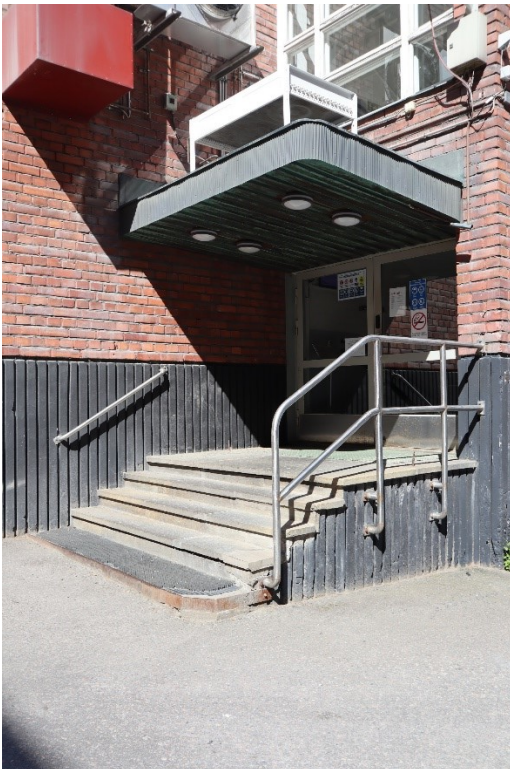
Kuva vasemalla: Yläpihan puoleinen sisäänkäynti, jossa näkyy sisäänkäynnin kuparinen poimupeltilippa. Kuva oikealla: Lähikuva Kirkkokadun puoleisen sisäänkäynnin vetimestä.
