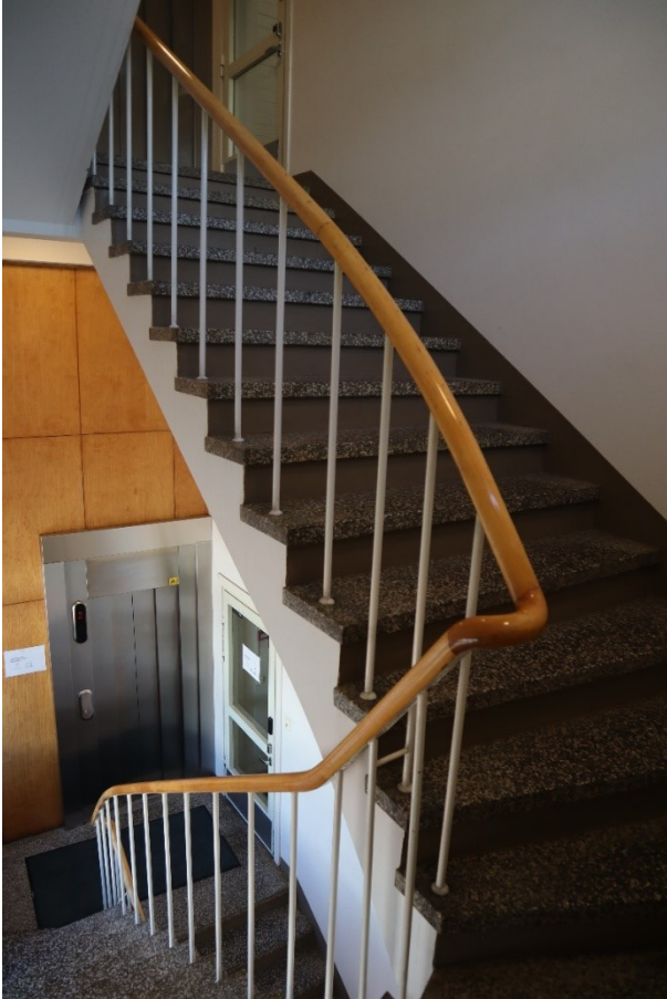
Toimistorakennuksen rappukäytävää, jossa portaissa on betonimosaiikkilattia, kaiteet ovat suoraa, ohutta metalliputkea, käsijohdin on lakattua puuta.
