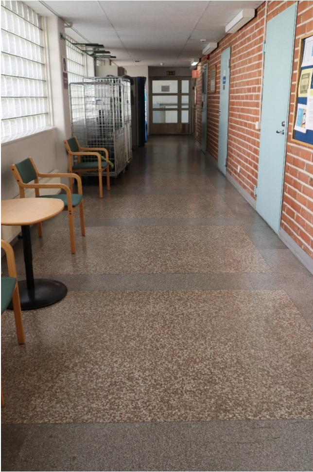
Kuva yläpuolella: Sosiaalirakennuksen 1.kerros, jossa on alkuperäinen betonimosaiikkilattia, lasitiili-ikkunat, seinät ovat rappaamatonta tiiltä. Kuva alapuolella: Sosiaalirakennuksen kolmannen kerroksen edustustilat, joihin tulvii luonnonvaloa kahdesta suunnasta. Rakennus edustaa aikakautensa ihanteita luonnonvalon suhteen.
