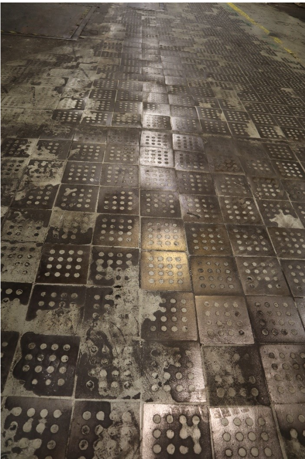
Kuva vasemmalla: lattian päällyste on kulunut ja esiin on tullut metallilevyä. Kuva oikealla: Lattiapinta on betonimosaiikkia.
