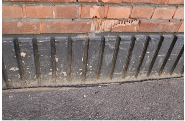
Kuva vasemmalla: Kirkkokadun puoleisen sisäänkäynnin poimukuparilippa, jossa neljä keskenään samanlaista pyöreää valaisinta. Kuva oikealla: Kivijalka on mustaksi maalattua, uritettua betonia.
