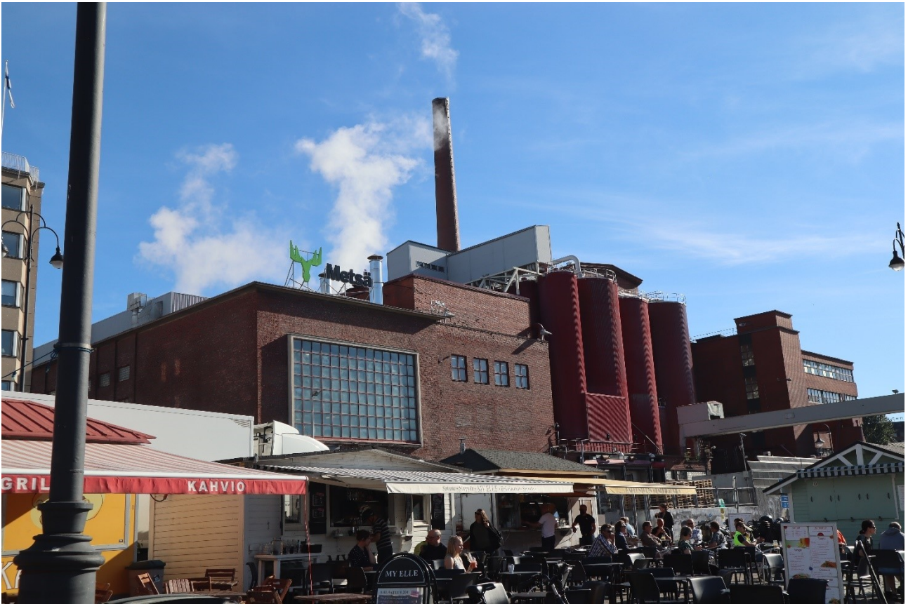
Rakennus kuvattuna Laukontorilta kesäkuussa 2021. Tasakattoinen korotusosa näkyy selkeästi.
