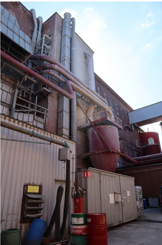
Rakennus kuvattuna sisäpihalta, jossa näkyy erilaisia säiliöitä ja putkia.
