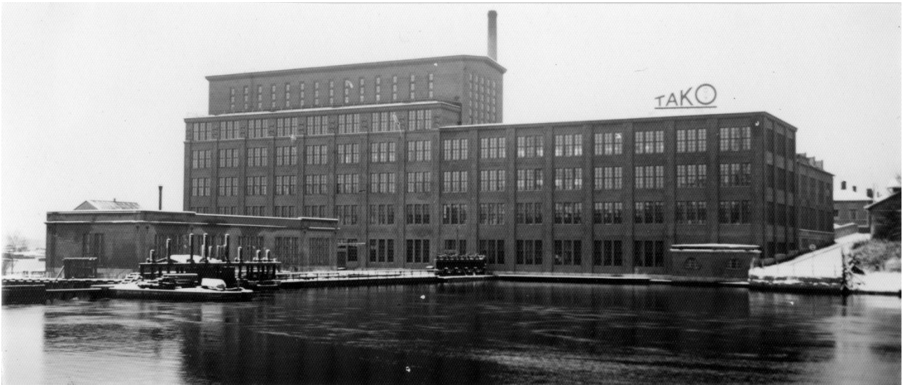
Tehdasrakennus arviolta vuonna 1932-1933, sillä rakennuksen pohjoispäässä on vielä pystyssä vanhasta tehdassalista muistuttumassa jugend-tyylinen matala poikkipääty, joka purettiin myöhemmin. Kuva: Atelier Laurent /Vapriikin kuva-arkisto.
