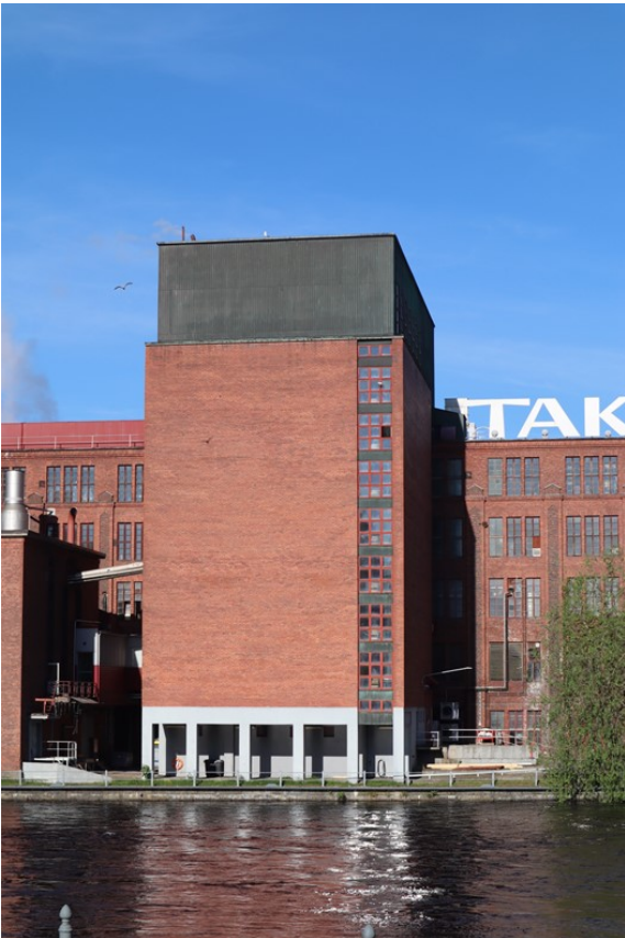
Kattilahuoneen julkisivu koostuu alaosan vaaleanharmaasta betoniosasta, korkeasta punatiiliosasta ja yläosan vihreästä kuparilevystä.
