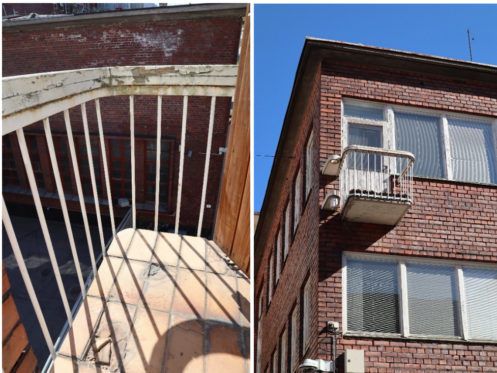
Sosiaalirakennuksen parveke, jonka lattiassa klinkkeritiiltä.
