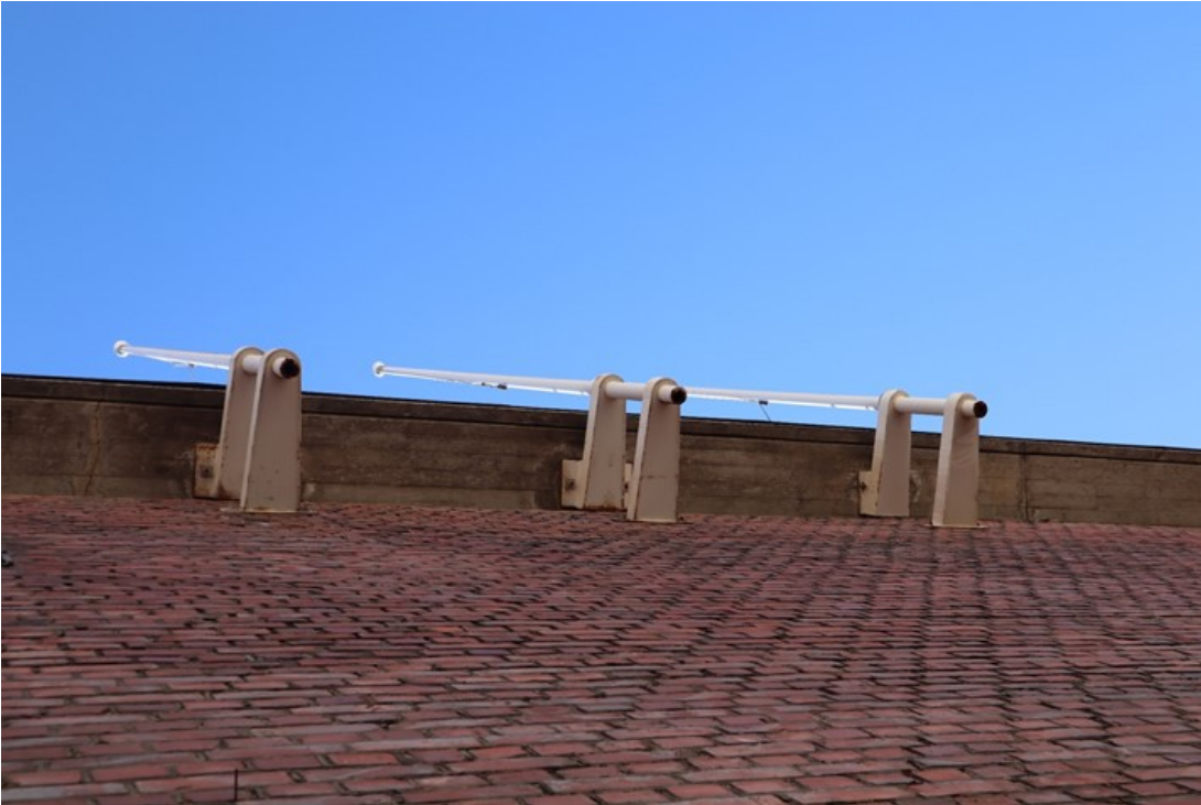
Kirkkokadun tehdassalin betoniräystä, johon on kiinnitetty metalliset lipputangot.
