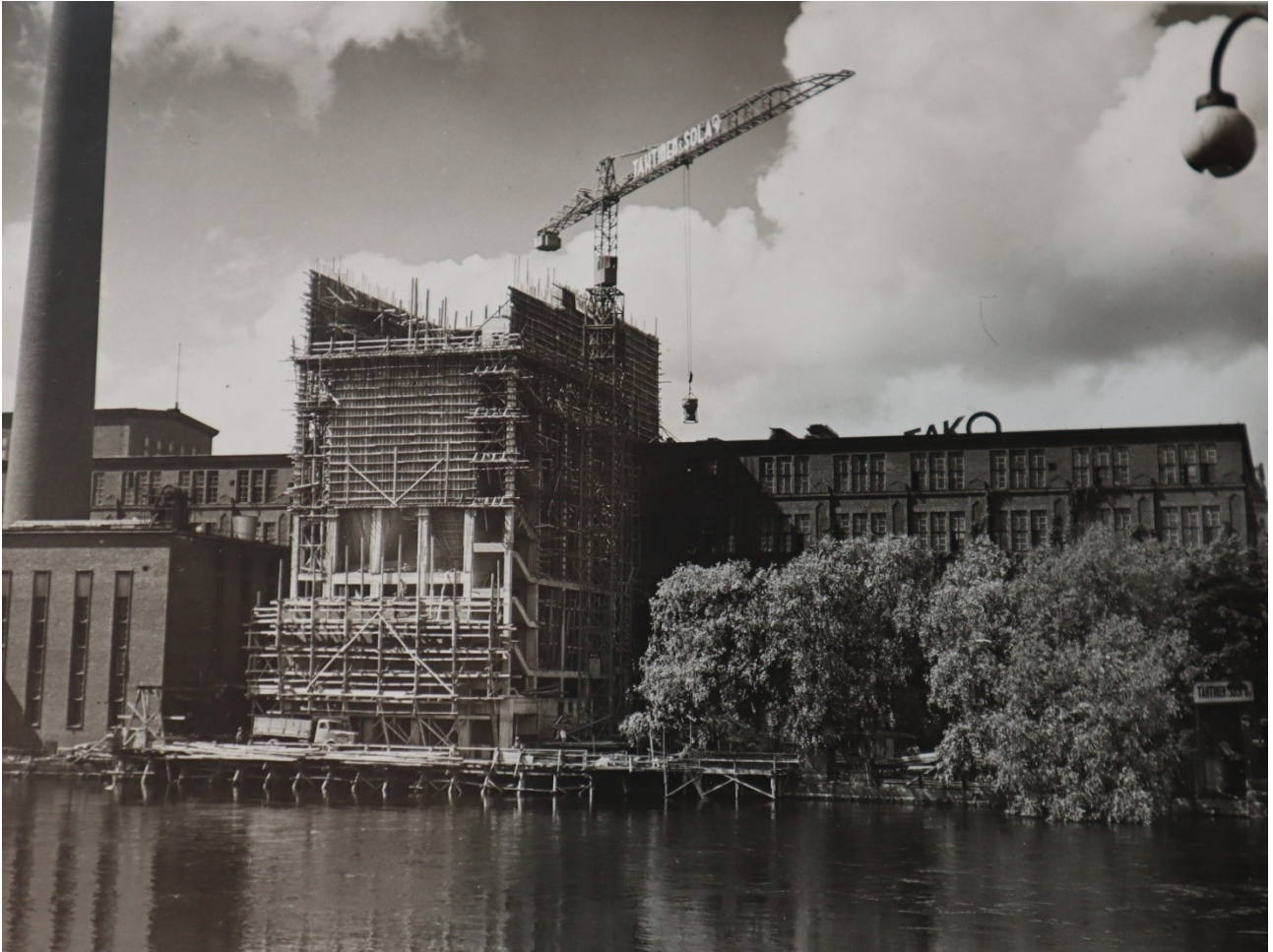
Voimalaitoksen rakennustyöt 1960-1961. Kuva: Gösta Serlachiuksen taidesätiö, Serlachius-museot, kuvakokoelmat.
