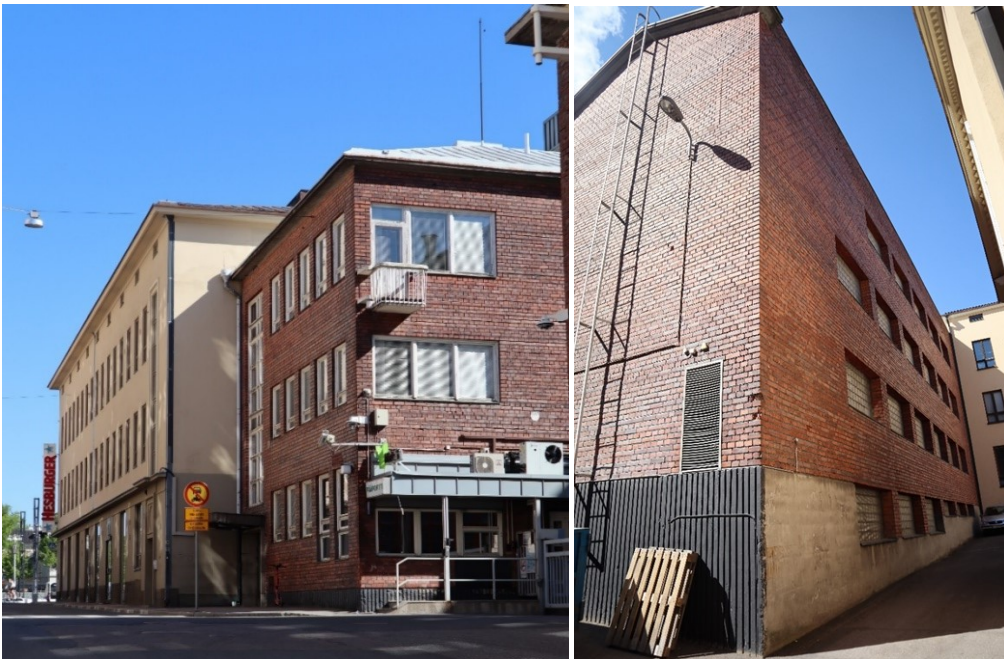
Kuva vasemmalla: sosiaalirakennus kuvattuna Kirkkokadulta kohti Keskustoria. Kuva oikealla: sosiaalirakennus kuvattuna "takaa" eli rakennuksen pohjoispuolelta. Rakennuksen sokkeli on uritettua, mustaksi maalattua betonia. Pohjoispuolen julkisivun sokkeli on maalaamatonta betonia.
