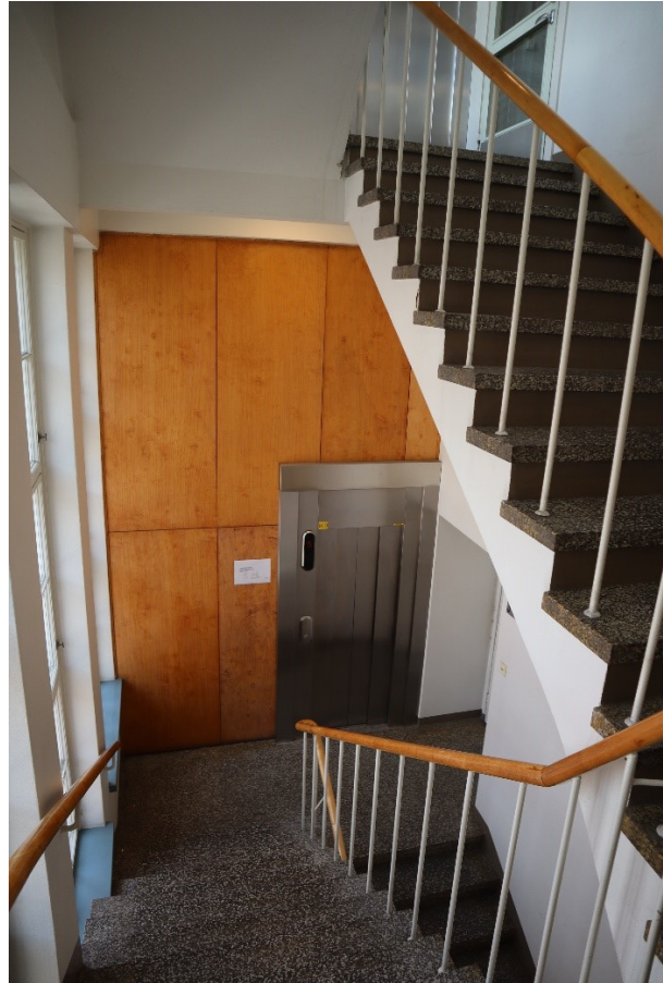
Toimistorakennuksen rappukäytävää, jossa portaissa on betonimosaiikkilattia, kaiteet ovat suoraa, ohutta metalliputkea, käsijohdin on lakattua puuta.
