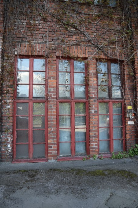
Tehdassaleihin tuo luonnonvaloa korkeat ja kapeat ruutuikkunat, jotka ulottuvat maahan saakka. Puiikkunat lienevät alkuperäiset.
