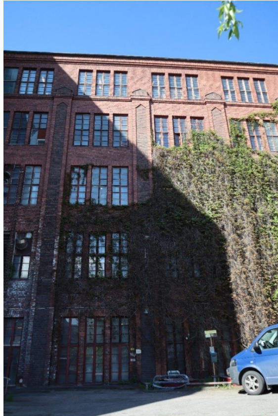
Tehdassaleihin tuo luonnonvaloa korkeat ja kapeat ruutuikkunat, jotka ulottuvat maahan saakka. Puiikkunat lienevät alkuperäiset.
