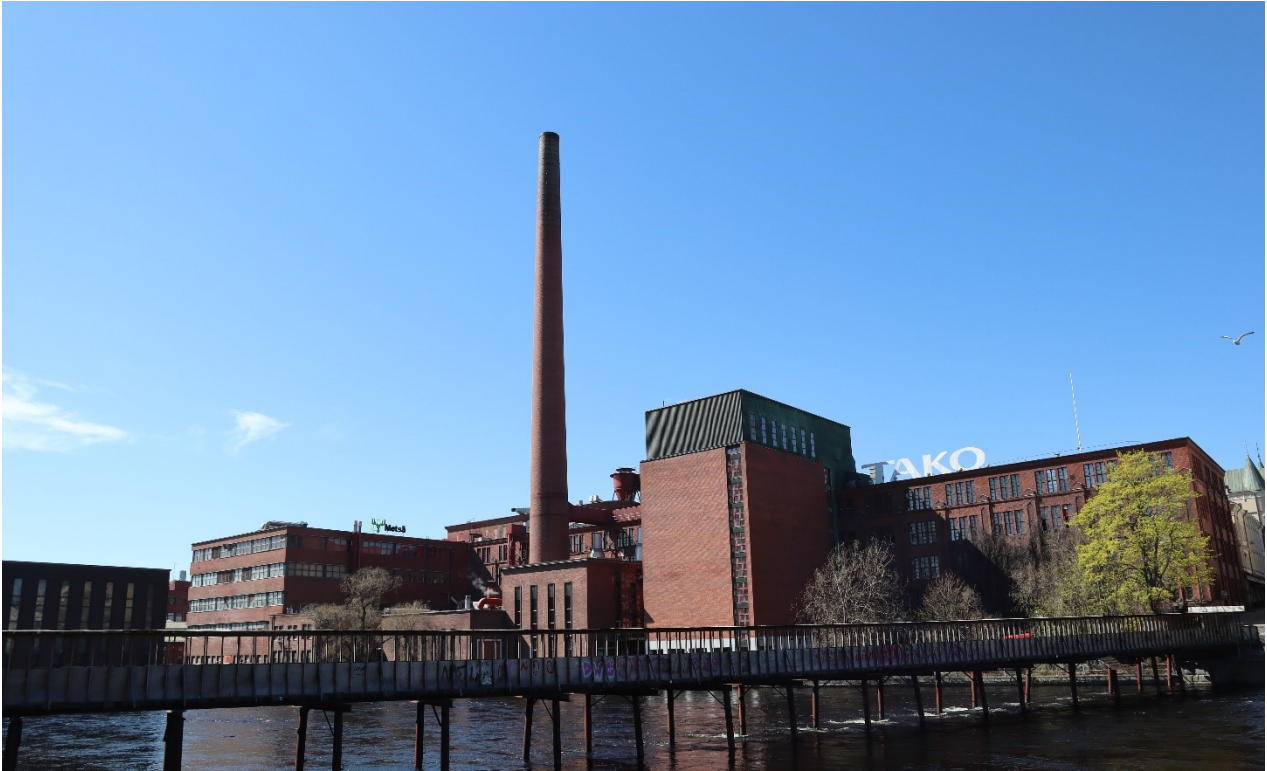
TAKO kuvattuna kesäkuun alussa 2021. Koskimaisemassa näkyvät rakennuskerrostumat 1930-, 1950- ja 1960-luvulta. Ehyttä koskimaisemaa jakoi Tammerkosken sillan peruskorjaukseen liittyvä väliaikainen kävelysilta.
