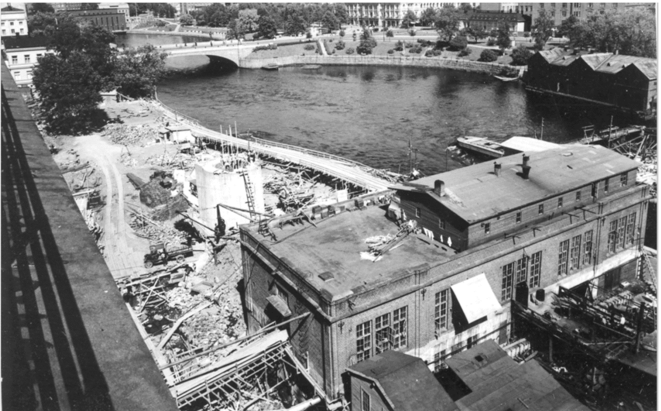
Kuva ylhäällä: Tako kuvattuna kosken itärannalta 1940-1950-luvulla. Kuvaaja: Kanninen. Kuva: Serlachius museon kuva-arkisto. Kuva alhaalla: Takon turbiinisaleja rakennetaan 1930-luvulla. Kuvan edessä olevassa, vuonna 1923 valmistuneessa rakennuksessa oli katolla omalla harjakatolla varustettu korotusosa, joka on myöhemmin purettu. Kuvaaja: Roos. Kuva: Serlachius-museon kuva-arkisto.
