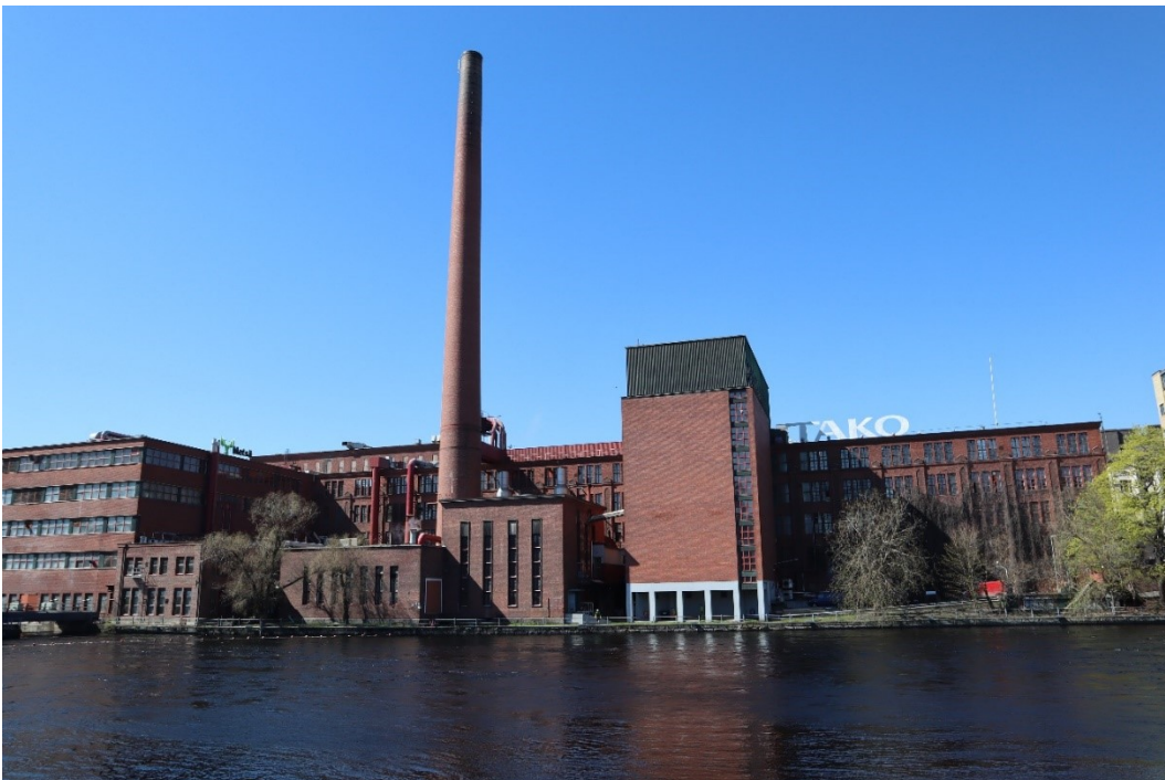
TAKO:n tehdasalue kuvattuna toukokuussa 2021. Kattilahuone sulautuu osaksi tehtaan rakennusmassaa muodostaen kuitenkin oleellisen osan kosken länsirannan maisemaa. Maisemakuva on myös hyvin kuvainnollinen liittyen Takon rakennushistoriaan, sillä maisemassa on W.G. Palmqvistin suunnittelema pitkä tehdassali ja turbiinisalit ja piippu, Bertel Strömmerin laajennus- ja korotusosat matalaan tehdassaliin ja turbiinisaleihin sekä Kautosen suunnittelemat pulpperitalo ja voimalaitos.
