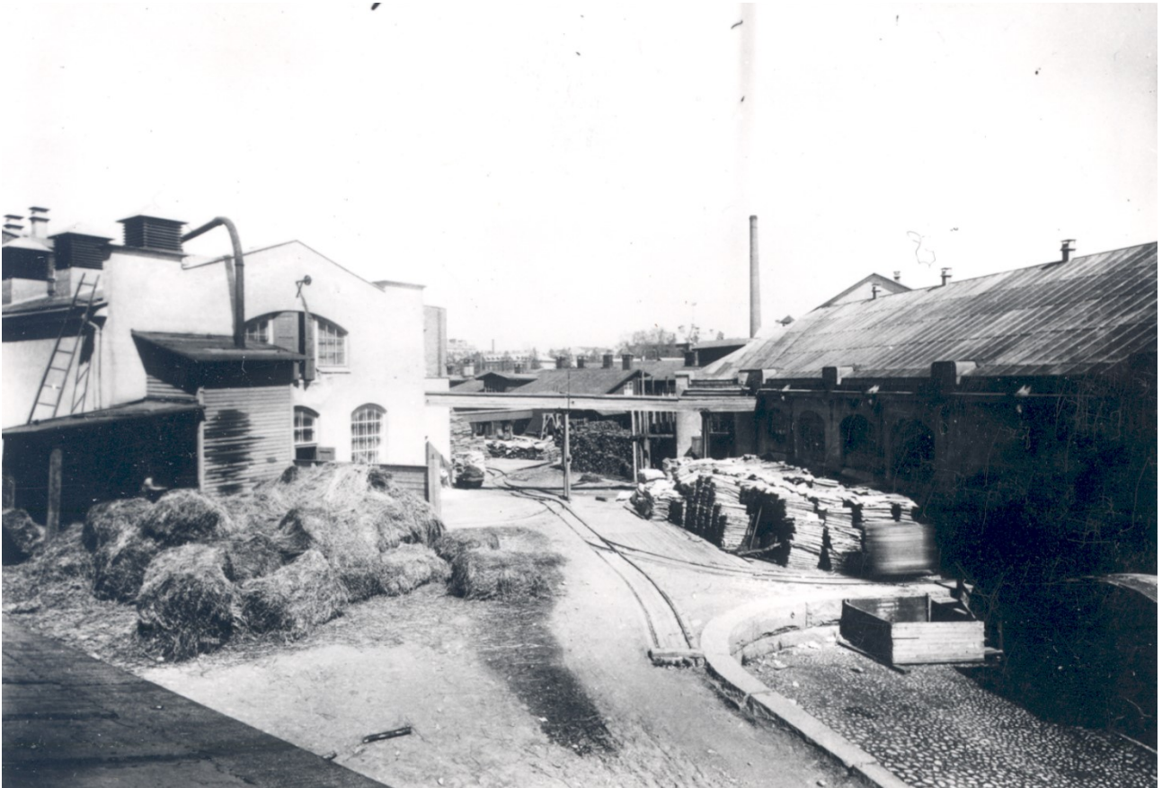
Arkinen kuva tehdasalueelta vuosien 1908-1923 välillä. Rakennukset ovat vielä matalia, osa on tiiltä, osa puuta. Kuvassa on joko olkia paperin työstämiseen tai heinää hevosille. Kuvassa keskellä kulkee rautatie, joka yhdisti rakennukset toisiinsa. Kuva: Staf/ Gösta Serlachiuksen taidesäätiö, Serlachius-museot, kuvakokoelmat.
