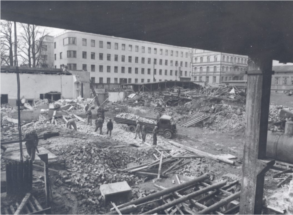
Rakennuksia puretaan tehdasalueella vuonna 1952 uusien rakennuksien tieltä. Kuvassa taustalla näkyy toimistorakennus ja Kirkkokatu, jonka myötäisesti alueelle nousi uusi tehdassali, johon sijoitettiin myöhemmin kartonkikone 3. Kuvaaja: Staf. Kuva: Serlachius-museon kuva-arkisto.
