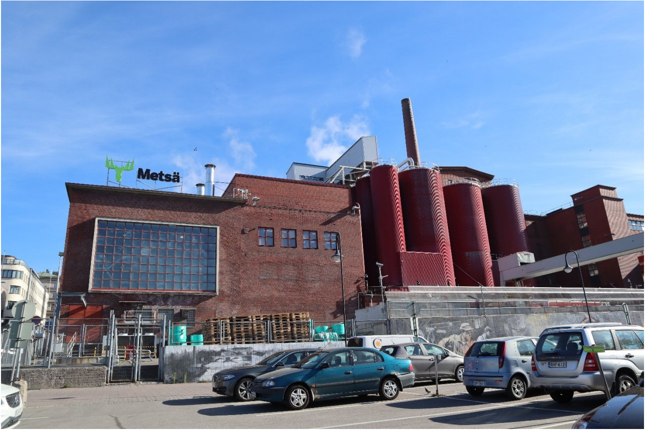
Laukontorin eli etelänpuolelta tehdasaluetta rajaa metallinen, harmaa verkkoaita, joka on mahdollisesti 1980-luvun lopulta, 1990-luvun alusta, jolloin tehdasalue on selvästi muodostunut suljetummaksi alueeksi.
