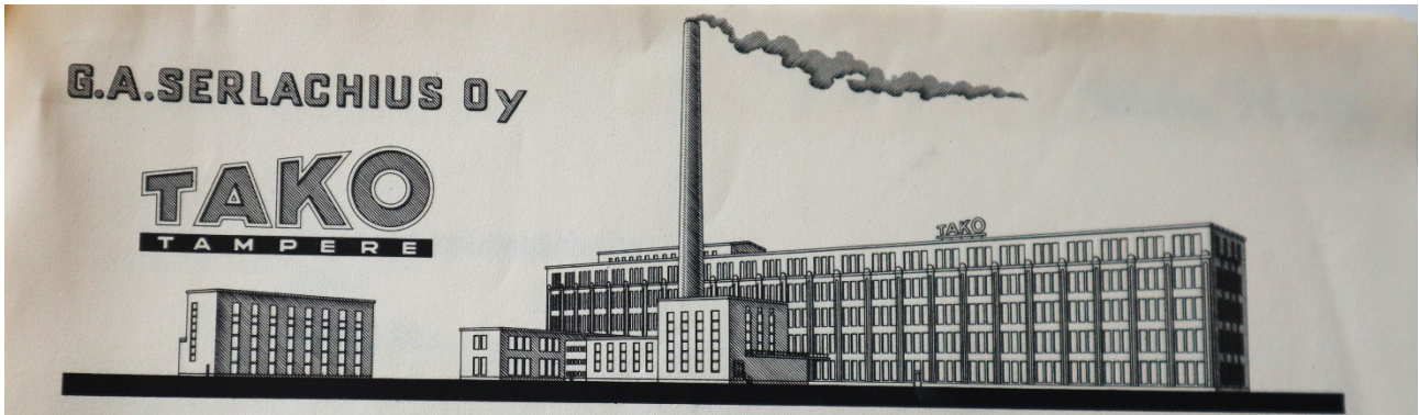
Takon kirjepaperin painokuva vuonna 1955 leimatussa kirjeessä. Kuvassa näkyy kaikki TAKO:lle keskeiset rakennukset alavoimalaa myöten. Lähde: Serlachius-museon arkisto.
