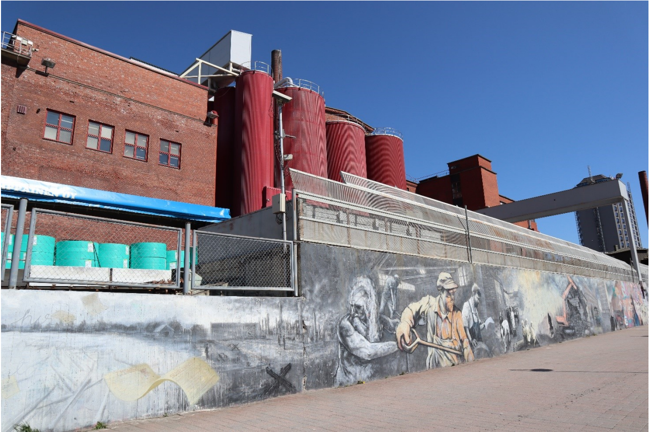
Alarannan aita, joka ei ole umpinainen, vaan avaa näkymän tehdasalueelle. Betonista pihamuuria koristavat tehdastyöstä yleisesti kertovat graffitit.
