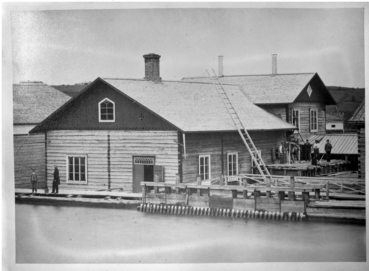
Idestamin puuhiomo kuvattuna 1867, kun laitos oli juuri edeltävänä vuonna aloittanut toimintansa. Hiomon rakennukset olivat puisia ja harjakattoisia, katteena käytettiin pärettä. Rakennukset oli asemoitu kohti koskea eli puuhiomon pääty osoittaisi kohti nykyistä Hämeen siltaa. Puuhiomon vasemmalla puolella oli Brummerin parkkimylly. Kuva: Vapriikin kuva-arkisto.
