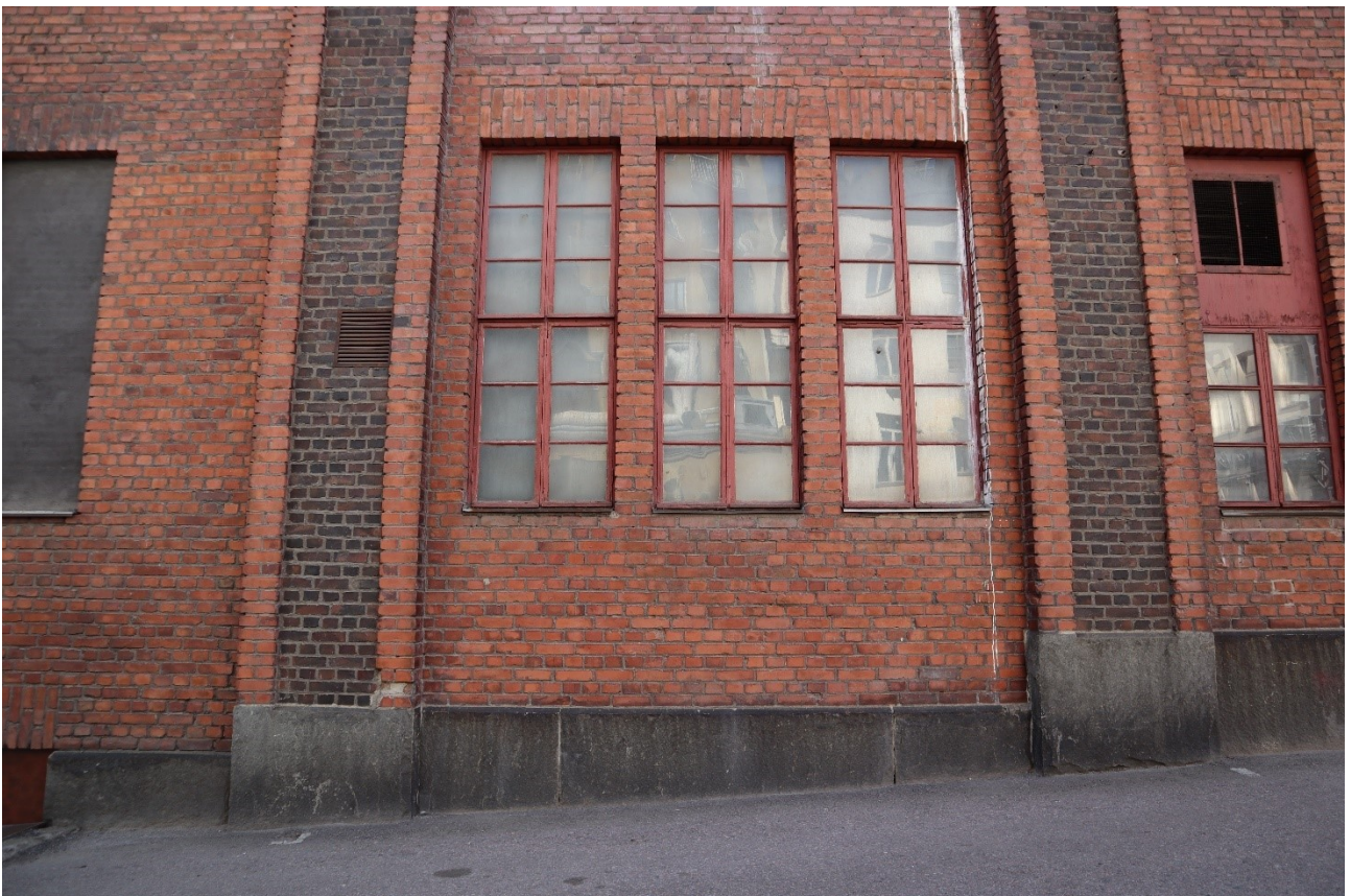
Kuvassa näkyvät pilasterit, joiden tiilipinta on rautapoltettua tiiltä.
