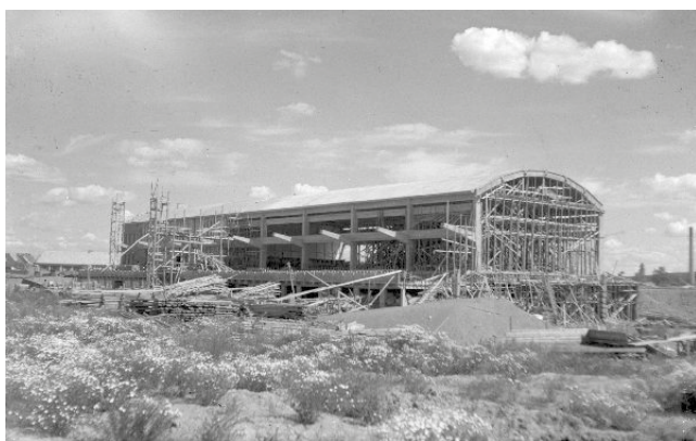
Varastorakennus rakennusvaiheessa ratapihan suunnasta kuvattu vuonna 1946.
