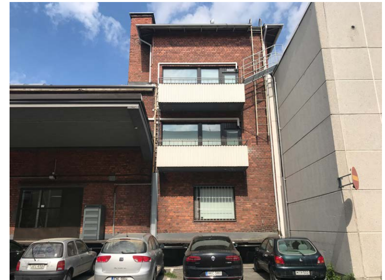
Takan vanhan varastorakennuksen asunto-osa toimii liitoskohtana varaston ja liikerakennuksen välissä.
