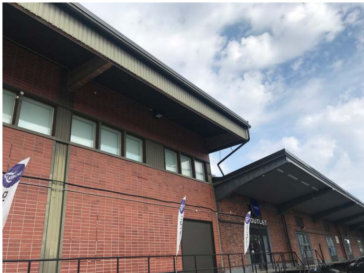
Vuosien 1983 ja 1946 varastorakennusten liittymäkohta. Uudemman osan katto ja runko on rakennettu liimapuutekniikalla. Bertel Strömmerin vanhassa osassa vastaavat rakenteet ovat betonia.
