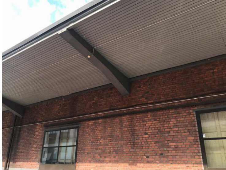
Varastorakennuksen länsijulkisivun yksityiskohta: lippaa kannatteleva betonitukirakenne on alkuperäinen.
