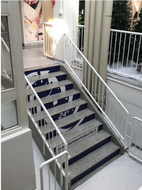
Porraselementti on valettu betonista ja pinnakaiteet ovat maalattua valkosta terästä.
