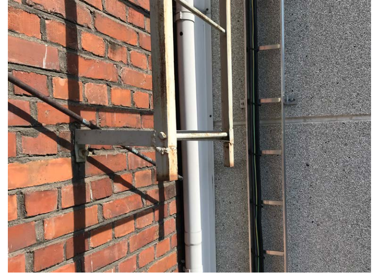
Takon varastorakennuksen vanhan osan ja liikerakennuksen liitoskohta: pesubetoni kohtaa punatiilen.
