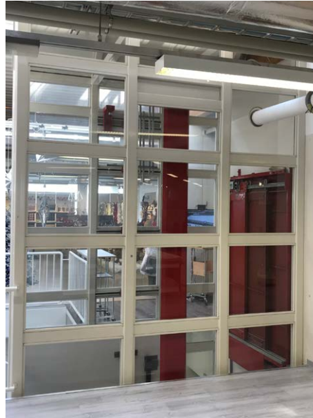
Lasitettu hissikuilu mahdollistaa, että hissi on dynaaminen osa sisätilaa.
