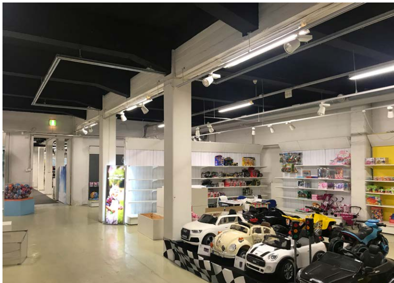
Varaston pohjakerroksen kattopalkeista osa on maalattu mustaksi.
