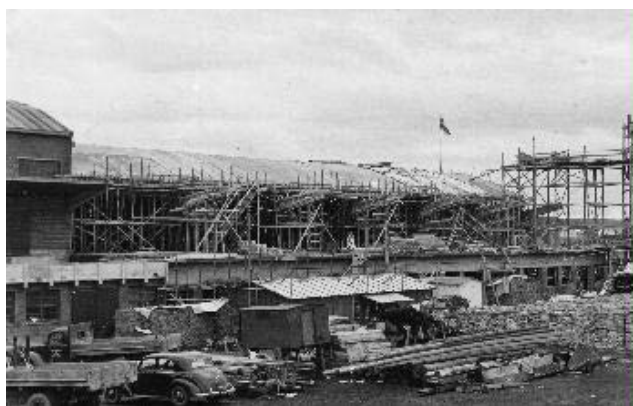
Varaston laajennuksen työmaakuvaa vuodelta 1952.
