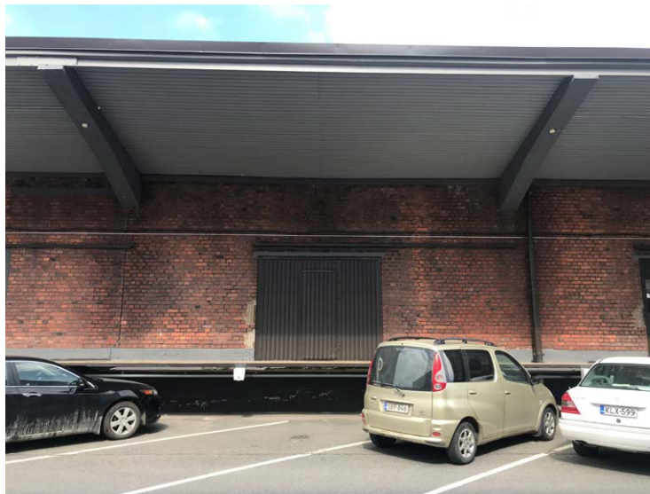
Vanhan osan katoslipan ulokemaisuus antaa vanhan rakennuksen ulkoarkkitehtuurille jännitettä.
