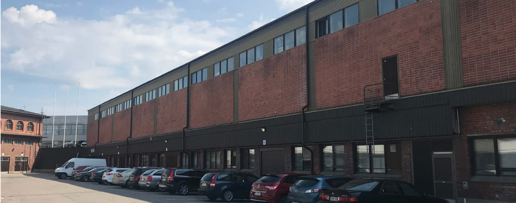
Varastorakennuksen lännen puoleinen julkisivu on saanut ilmeensä vuoden 1983 laajennuksessa. Ensimmäisen kerroksen rakennettiin kaksikerroksinen betonielementeistä tehty uudisosa, joka on päällystetty tiililaatoilla.
