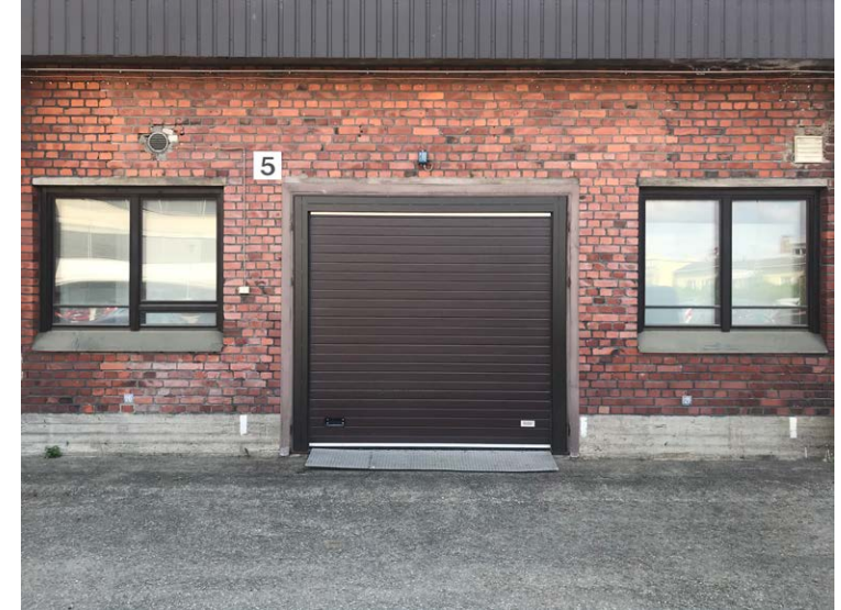
Länsijulkisivun 2000-luvun puolella asennetut uudet liukuovet ovat erottuvat 1940-lukulaisesta julkisivusta.
