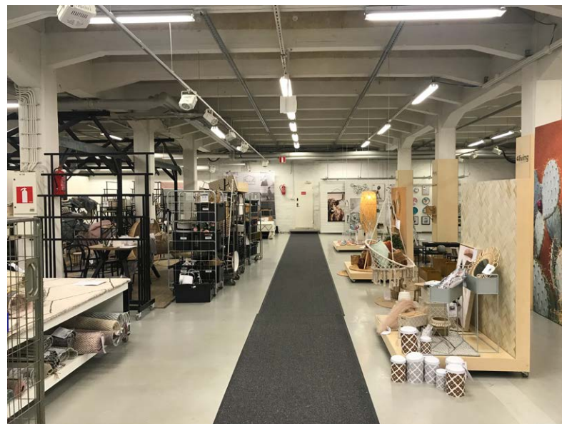
Varaston pohjakerroksen tilaa hallitsee betoninen pilari-palkkijärjestelmä.
