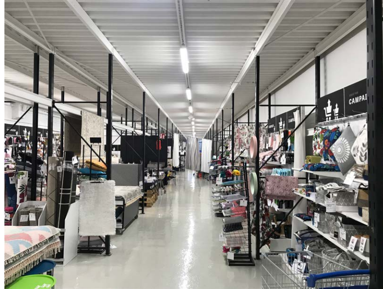
Varaston länsipuolen laajennusosassa myymälän hyllyt ja peltikattorakenne ovat yhtä.
