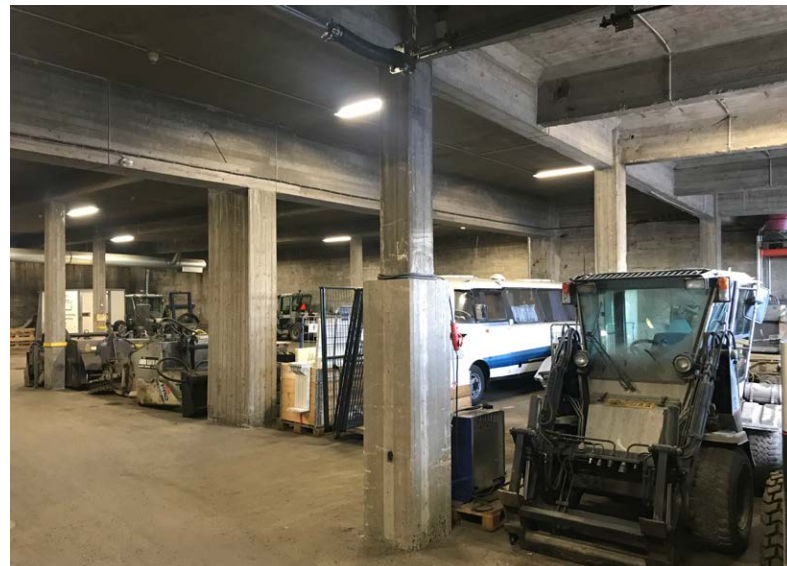
Rakennuksen länsipään pohjakerroksessa säilytetään työkoneita.
