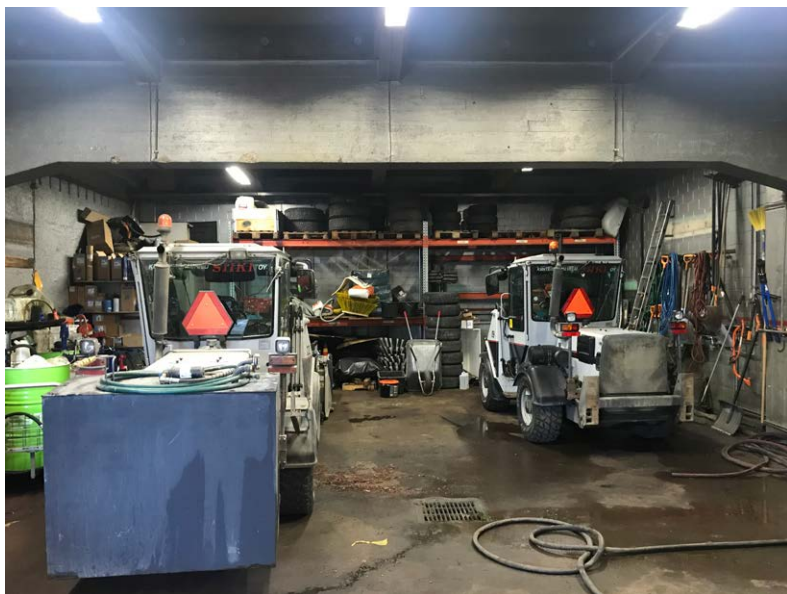
Takon varastorakennuksen pohjakerroksen yksi autotallitila.
