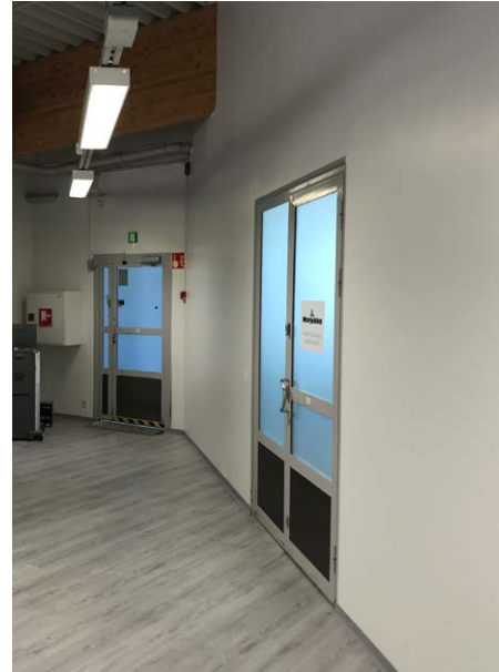
Teräslasiovia liikerakennuksen toisessa kerroksessa.
