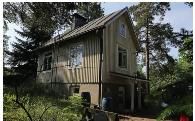
Julkisivu päädyistä (pohjoisesta).
