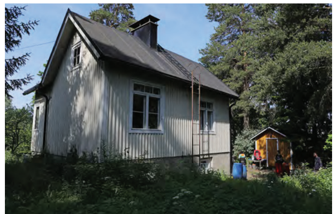
Julkisivu takaa (idästä).
