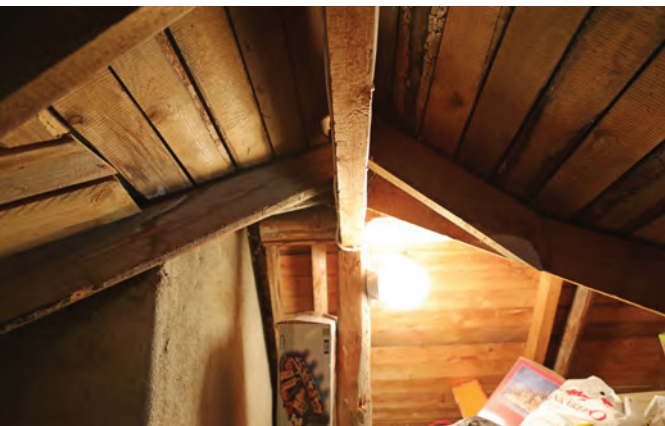
Ullakkoa ja katon rakenteita.
