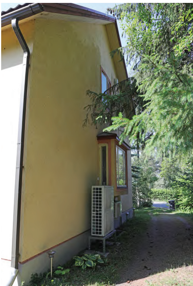
Julkisivu päädyistä. (pohjoisesta)
