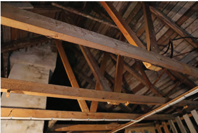
Ullakon kattorakenteita rakentamattomalta puolelta.
