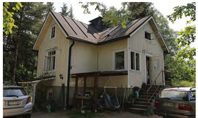
Julkisivu edestä (lännestä).
