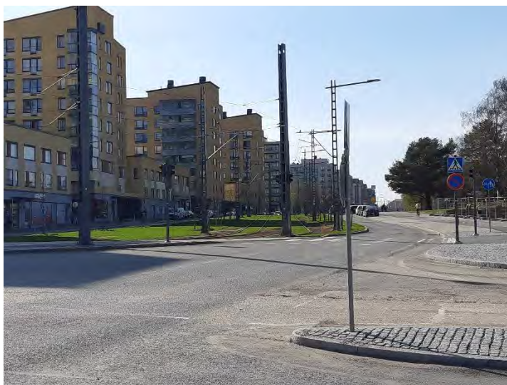
Kuva 8. Sammonkadun eteläreuna on massoitteeltaan tiiviin rytmikäs. Pohjoispuoleiset korttelit ovat väljiä ja piha-alueiden kasvillisuus on osa katutilan viehätystä.
