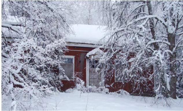
Luoteisjulkisivua puiden katveessa.
