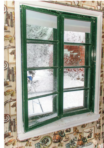
Kamarin ikkunasta näkyy vanhan päärakennuksen seinää.
