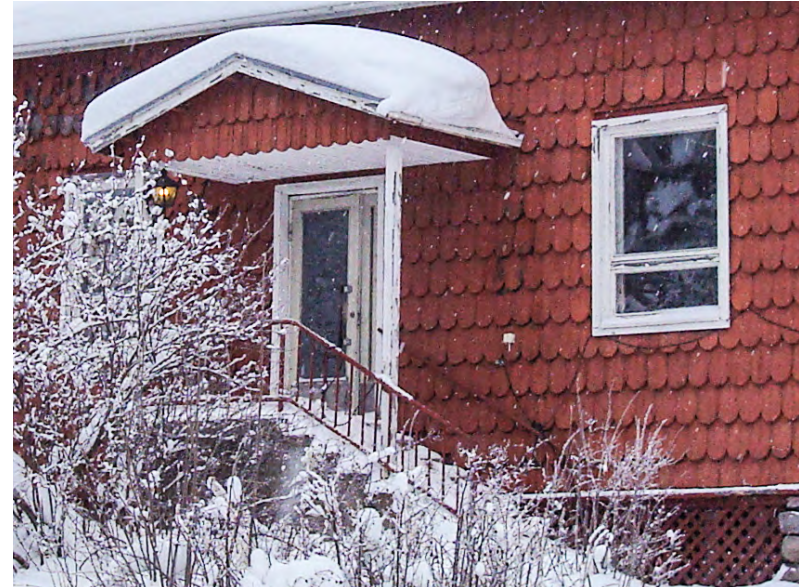
1960-luvun alun uusi sisäänkäynti ja "ajanmukaistettu" ikkuna.
