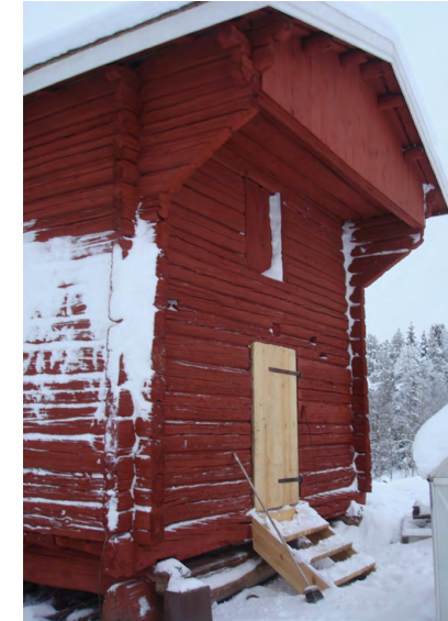
Aitan uusi ovi ja portaat
