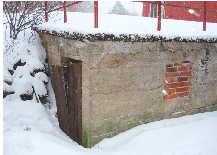
Oikealla: Kellarin rikkiäinen ovi ja umpeen muurattu ikkuna. Vas: sisäseinät ovat tiiltä. Kalkkimaalaus on rapistunut. Katto on betonia.
