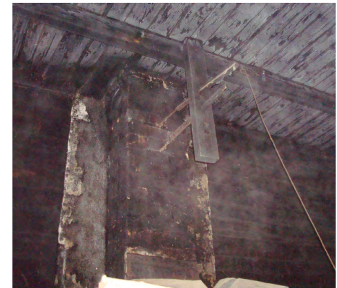
Hormin peltien säätelyjärjestelmä. Puuosissa näkyy kosteusvaurioita.
