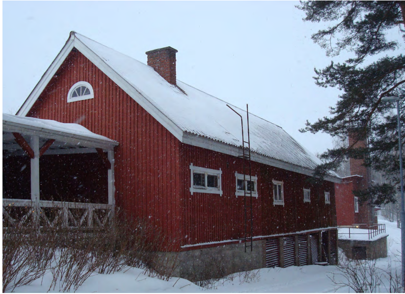
Luoteispäädyssä on saunalaajennus, jonka alueella on umpisokkeli.
