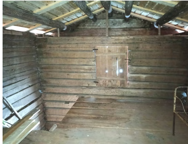
Aitan toinen kerros on tyhjiällä. Kattoa on uusittu.
