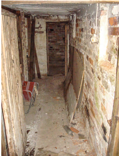
Ylhäällä: Kellari kuvattuna lämpökeskuksen edestä. Taustalla aitta- ja saunarakennus.
