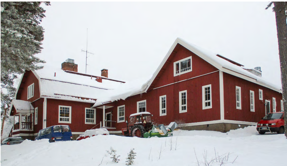
Rakennus kuvattuna lounaasta rannan puolelta näköalapaikan suunnasta. Sisänurkassa sijaitseva sisäänkäynti on alkuperäisellä paikallaan.
