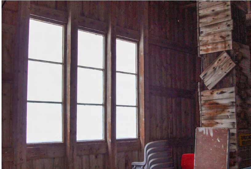
Luoteispään yläkerran ikkuna ja sikalan puurakenteinen hormi.
