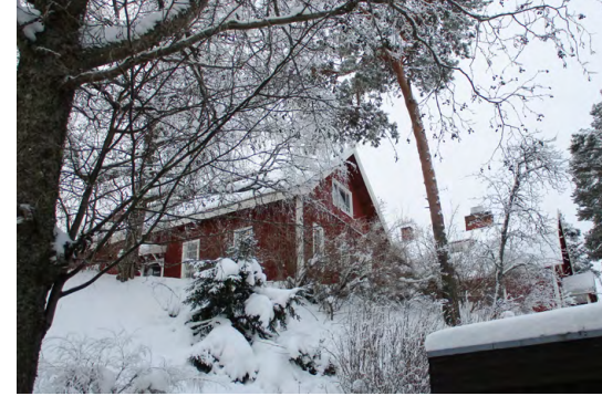
Rakennus kuvattuna saunan edustalta.
