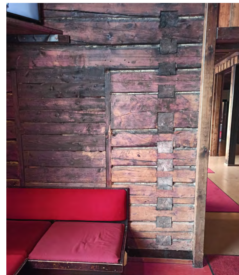
Vanhaan hirsiseinään on tehty täyttöjä v. 1954 kun komeroiden ovet on käännetty avautumaan aulaan päin.
