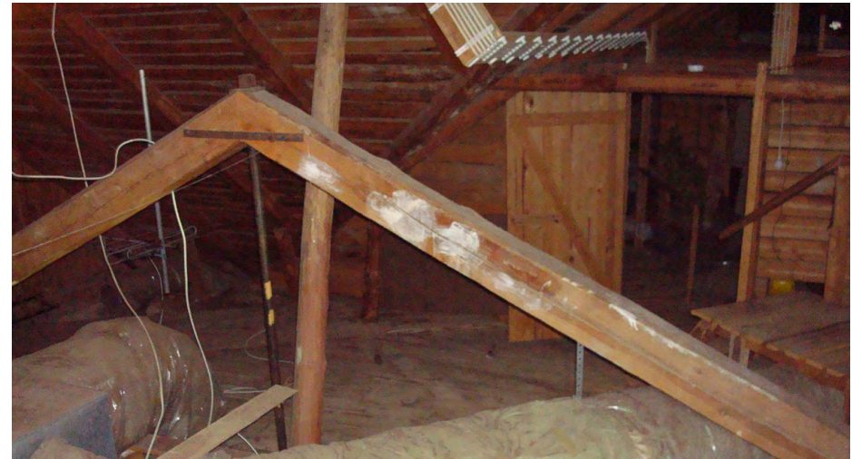
Salin kattoa kannattava ansarakente uullakolla vastaa alkuperäistä v. 1913 laadittua leikkauspiirustusta.
