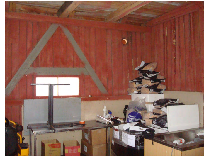
Kaakkoispäädyn tilassa seinät on sisältäkin maalattu punaisiksi.
