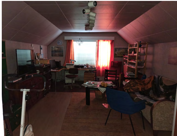
Asuinhuoneissa on taitteinen katto, joka on verhoiltu huokoisella kuitulevyllä.
