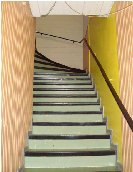
Alkuperäinen portaikko ullakolle ja keittiösiiven asuntoon.
