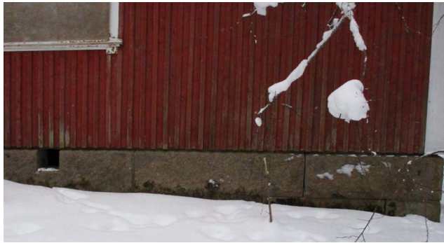
Luonnonkivisokkeli ja rimalaudoitusta.
