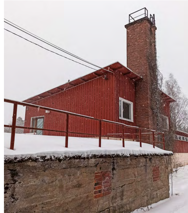
Lämpökeskus luoteesta, etualalla kellari.
