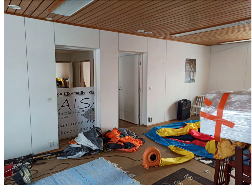
Lounaispäädyn huoneiden väliseinä on purettu. Tilaan on jäänyt kaksi ovea.
