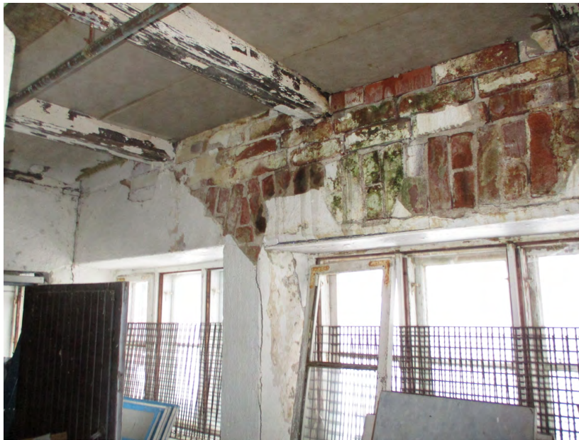
Lounaan puoleista ulkoseinää rakennuksen keskivaiheilta.
