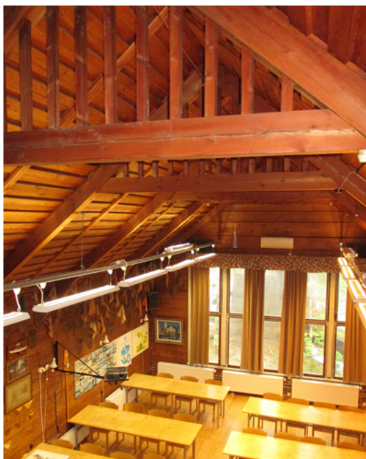
Sali ja salin kattorakenteita kuvattuna toisen kerroksen parvelta. Loisteputkivalaisinkiskot kulkevat salin päästä päähän.
