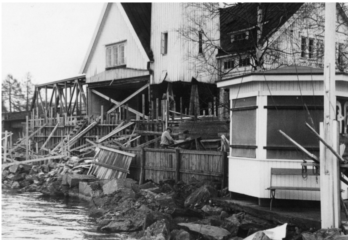
Paviljongin laajennus- ja laiturien rakennustöitä Pajasaarella vuonna 1961. Pohjoisseinältä on purettu v.1937 rakennettu kaareva terassilaajennus ja tornin 1. kerros. Toisessa kerroksessa on vielä vanhaa pystypanelointia ja moniruutuiset ikkunat. Oikealla "Mutteri" eli tuomarikoppi. Kuvaaja: Lasse Syren, Lähde: VKA.
