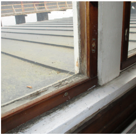
Alkuperäiset kaksiruutuiset ikkunat olivat vaihtuneet yksiruutuisiksi, kuva syyskuulta 2020.
