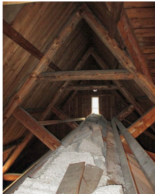
Yläpohjarakenteita salin kohdalta. Perällä eteläpäädyn kaksiruutuinen ikkuna. Vasemmalta kuultaa valoa katon itälappeen ikkunasta.
