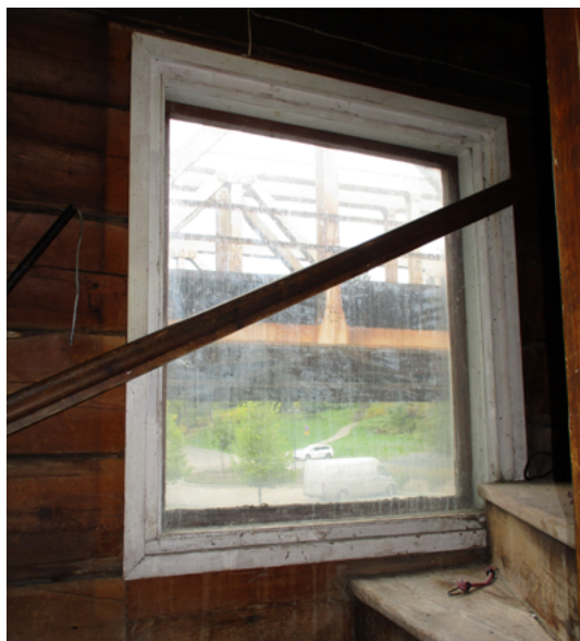
Yllä: Porrashuoneen ikkuna on vaihtunut yksiruutuiseksi aiemman neliruutuisen sijaan.
