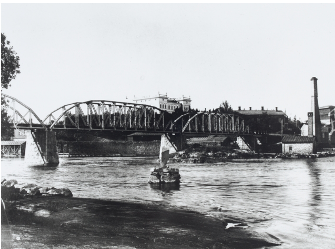
Koskenniskaa ennen paviljongin rakentamista. Saarella on vielä pajarakennus, joka on siirretty saaren pohjoisosaan rautatien rakenteiden tieltä. Rautatien ristikot ovat vielä kaarevat. Taustalla Näsilinnä. Lähde: Museoviraston kuvakokoelma, Kustannus Oy Otavan kuvakokoelma.
