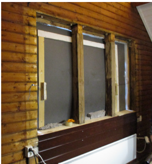
Kuukautta myöhemmin ikkunaseinää oli jo alettu remontoida ja ikkunat irrotettu paikoiltaan.
