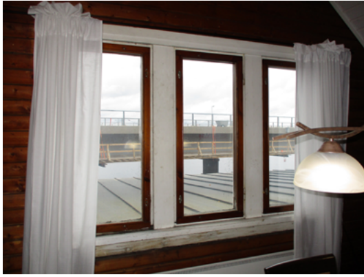
Alkuperäiset kaksiruutuiset ikkunat olivat vaihtuneet yksiruutuisiksi, kuva syyskuulta 2020.
