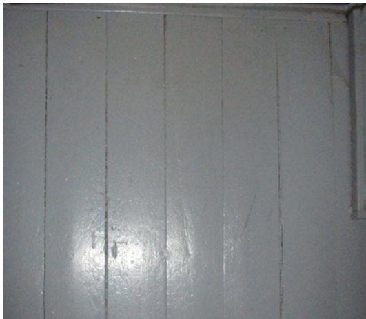
Lattialaudoitus on maalattu.
