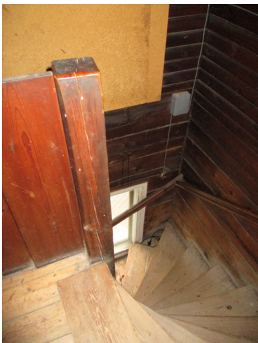
Portaikko toisen kerroksen tasanteelta kuvattuna.
