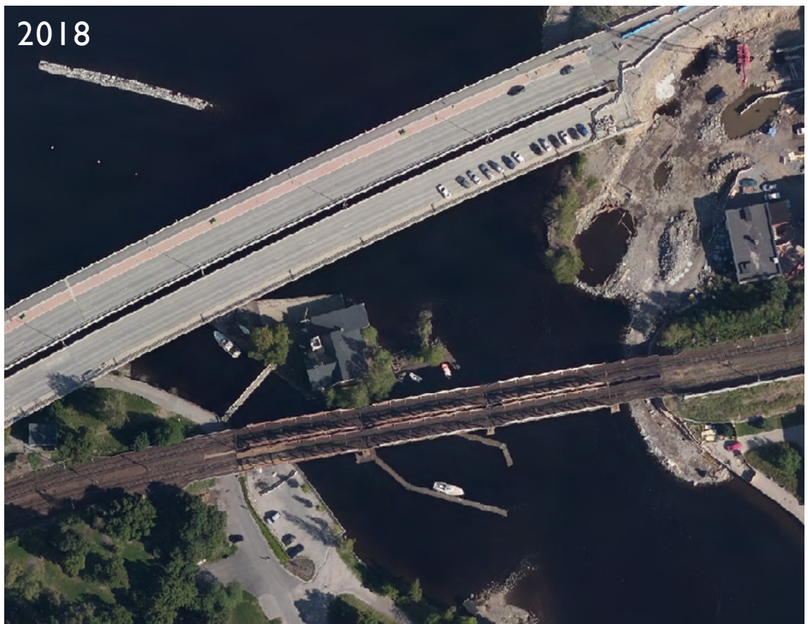
Ilmakuva vuodelta 2018. Pajasaari on nykyisessä asussaan, ja Ranta-Tampellaa rakennetaan. Liikenne Näsinsilloilla on katkaistu. Eteläisellä sillalla on työmaan autoja parkkeerattuna. Pohjoinen silta on kevyen liikenteen käytössä.
