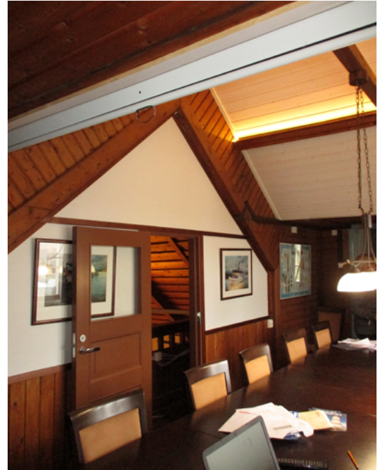
Avoin yhteys saliin on katkaistu ovi- aukkoon rakennetulla väliseinällä.
