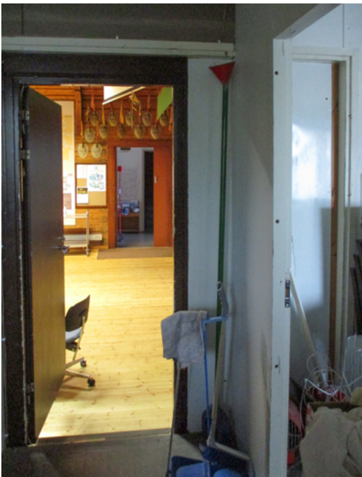
Jälkikäteen oleskelutilaan lisätty väliseinä osuu salin oviaukkoon.
