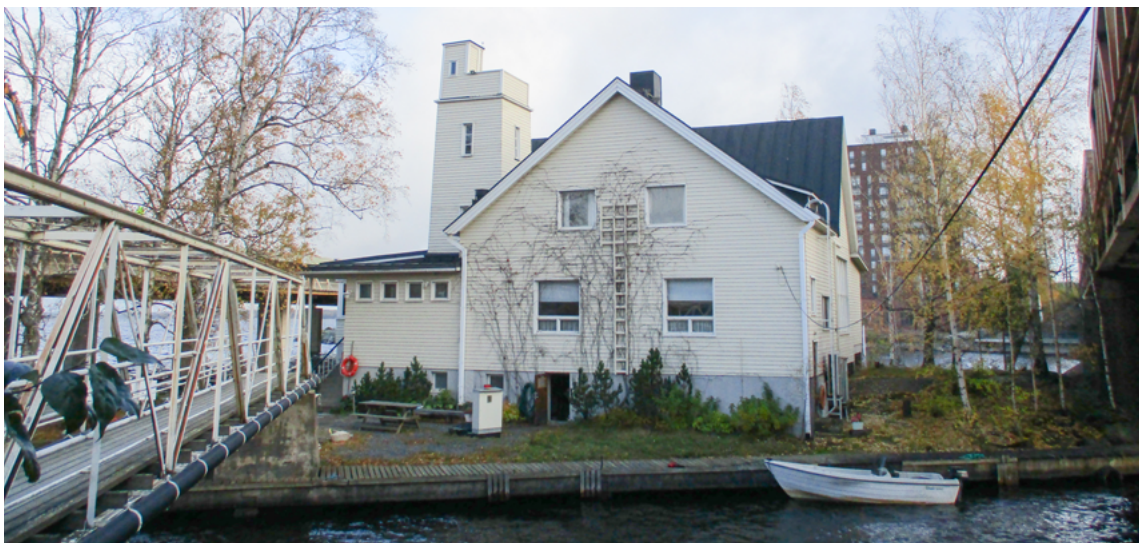
Paviljonki Tammerkosken länsirannalta katsoen. Vasemmalla kävelysillan rakenteita, oikealla rautatiesilta.
