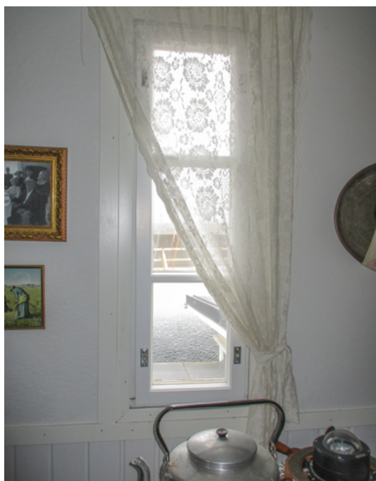
Pohjoisseinän ikkuna on säilynyt kolmiruutuisena.
