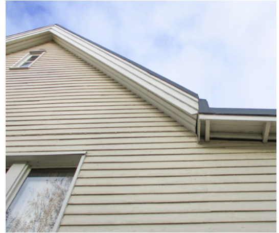
Räystäsrakenteita vanhan (vas.) ja uuden osan rajalla.
