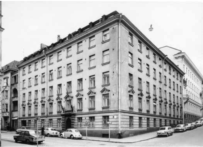
Maanmittaushallituksen vuonna 1926 valmistunut virastotalo Kirkkokatu 3:ssa 1960-luvun vaihteessa. Rakennuksen arkkitehtuuria arvosteltiin aikoinaan liian tavanomaiseksi – se muistutti suuresti aikakauden asuinrakentamista. Virastotalon pohjakerroksessa oli Maanmittaushallituksen karttapaino ja kerroksissa mm. suuria piirustussaleja. KA RakH
