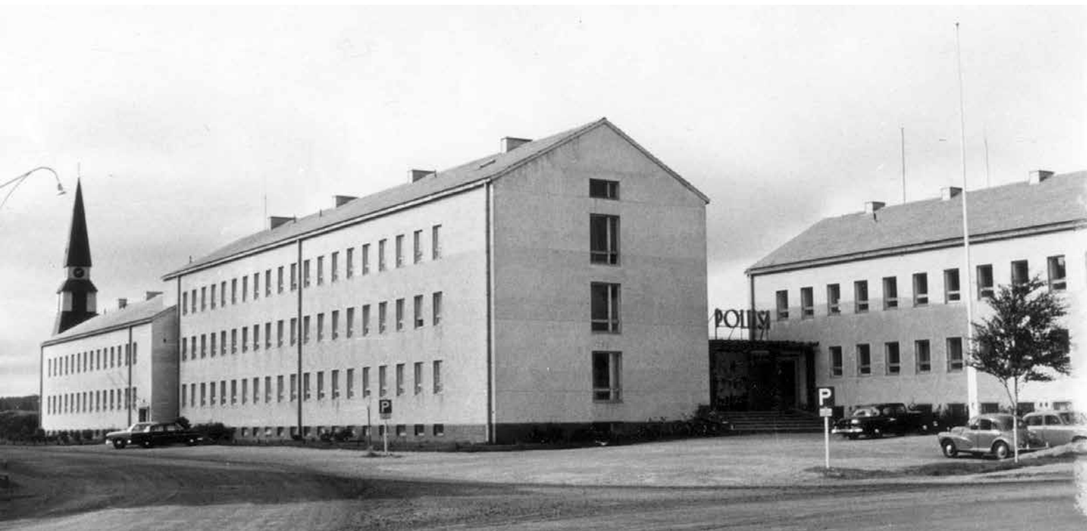
Rovaniemelle Lapin lääninhallitustalon naapuriin 1940-luvun lopussa valmistunut valtion virastotalo. KA RakH
