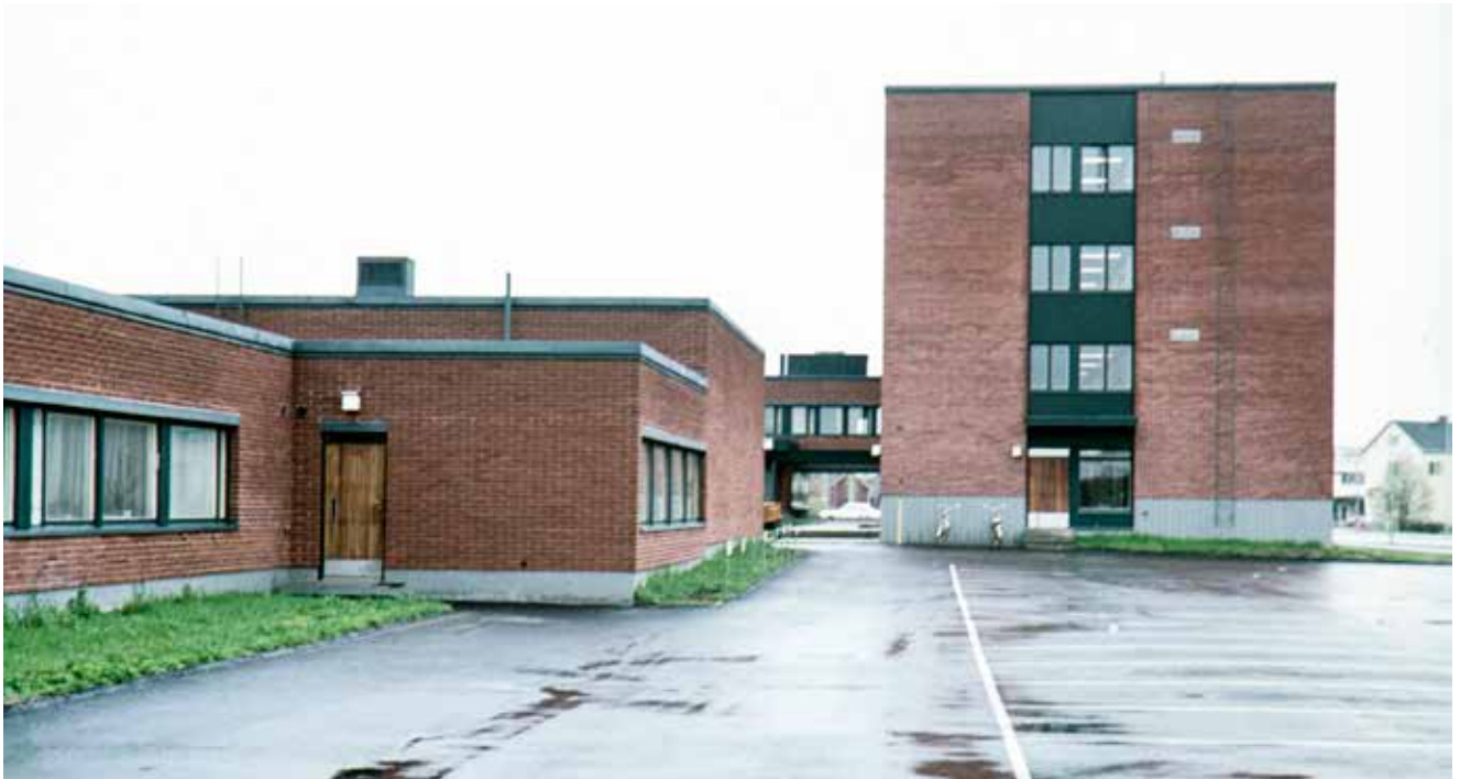
Ylivieskan vuonna 1970 valmistunut ja vuoteen 1978 mennessä laajennettu virastotalo. MV/Härö
