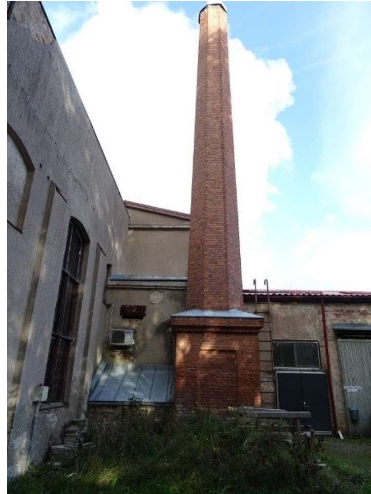
Yllä entisen puuhiomon piippu, oikealla voimalan patorakennelmaa ja pengerrystä. Sen alla vanha maantiensilta
