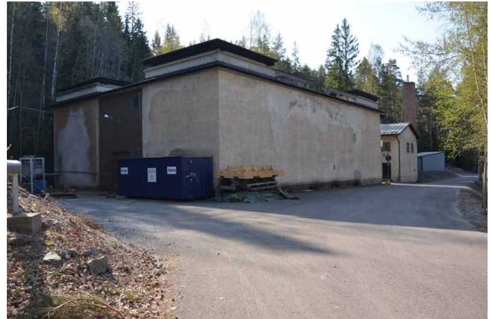
Koekäyttölaitos on kuutiomainen, rapattu rakennus. Rakennuksen takana näkyy sen erillinen toimisto- ja lämpökeskus.
