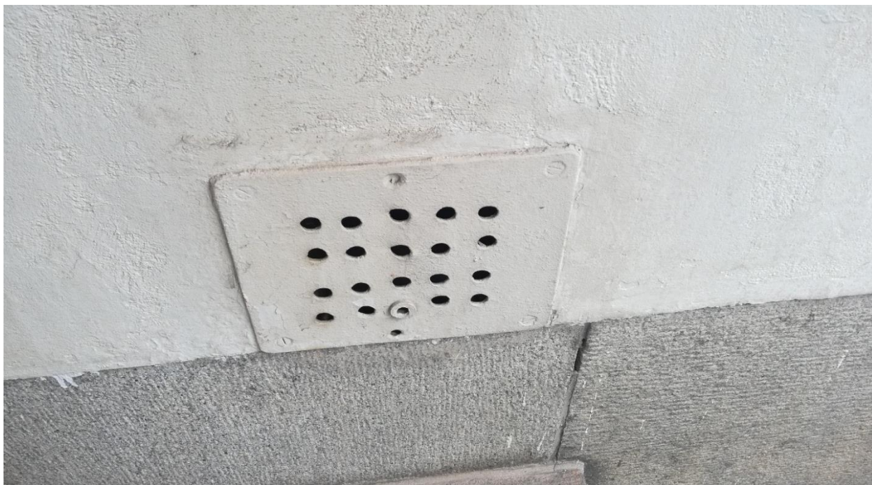
Kuva. Yksityiskohtia julkisivussa, ilmanvaihtoritilä sisäänkäyntisyvennyksen sivuseinässä.
