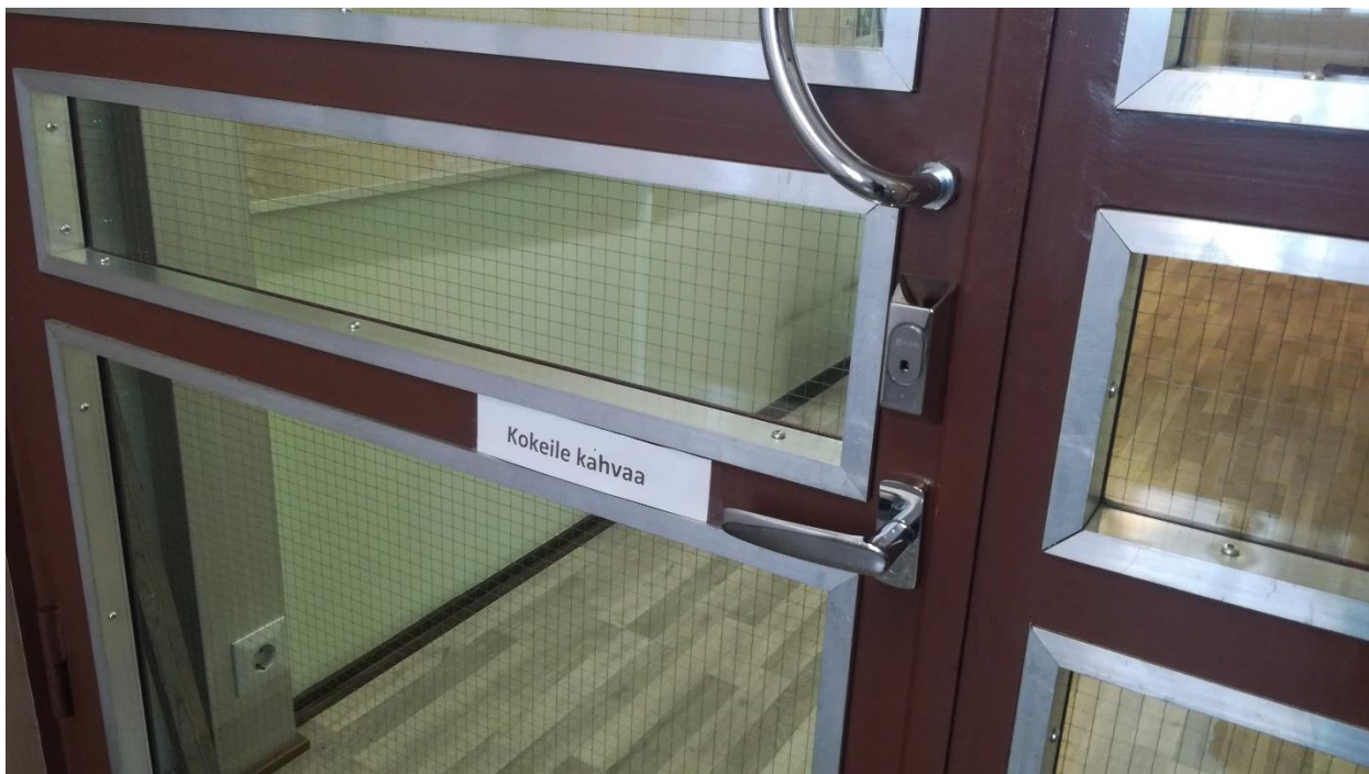
Kuva. Rakennuksen väliovet ovat tyypillisiä 1980-luvun lasimetalliovia, joiden lasiosat onrautalankaverkolla vahvistetut.
