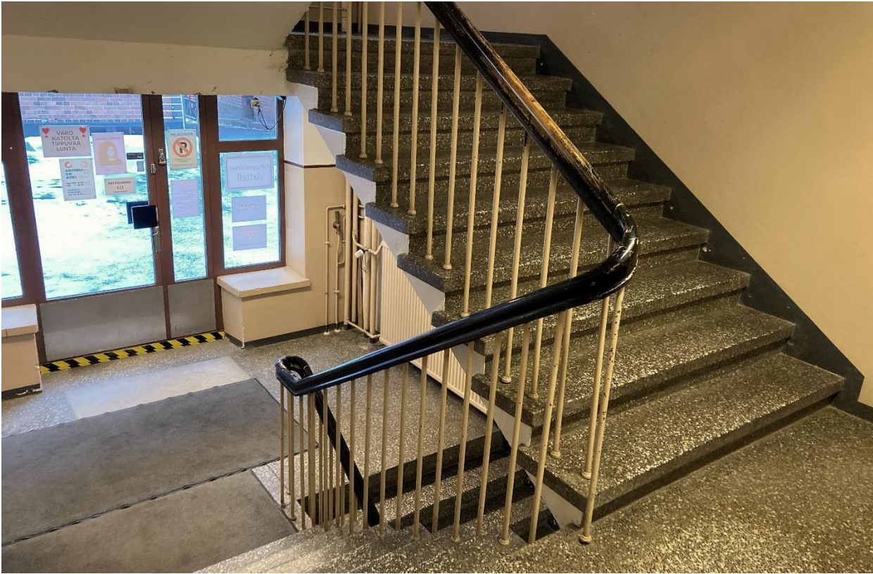
Kuva. Rakennuksen pääporrashuone sijaitsee rakennuksen pohjoisreunalla, autotalliin vieressä ja sinne on sisäänkäynti sisäpihalta.
