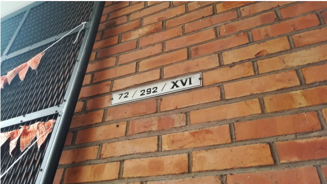
Kuva. Kiinteistötunnuskytti: tontti 72, kortteli 292, kaupunginosa 14. rakennuksen tiilijulkisivulla.
