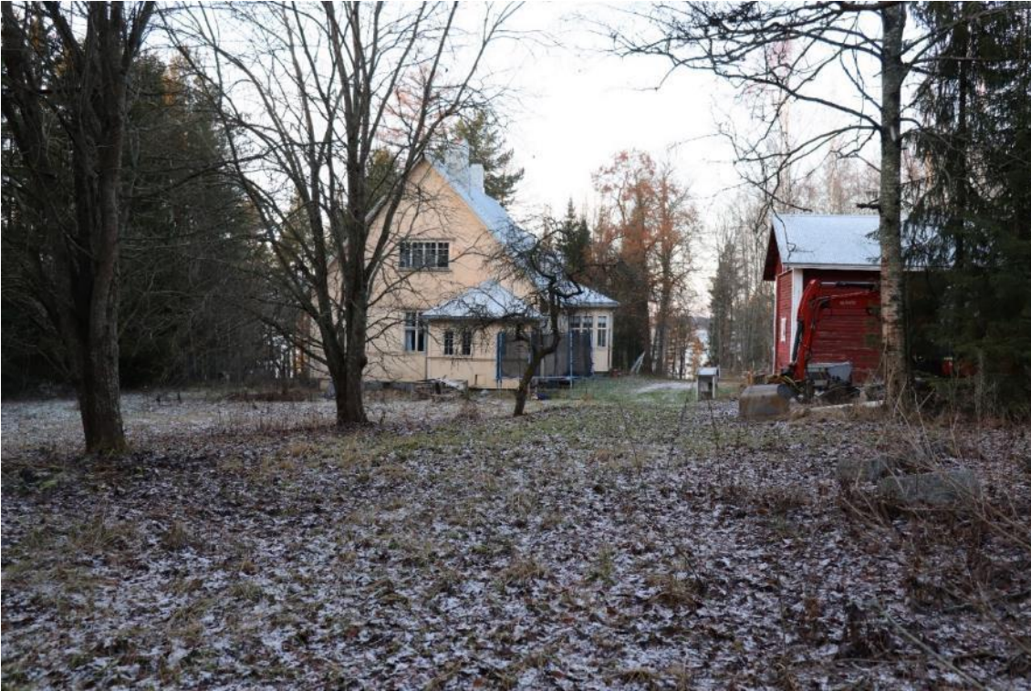
Kuva 42. Kukkasmaan talo. Kuvattu etelästä.
