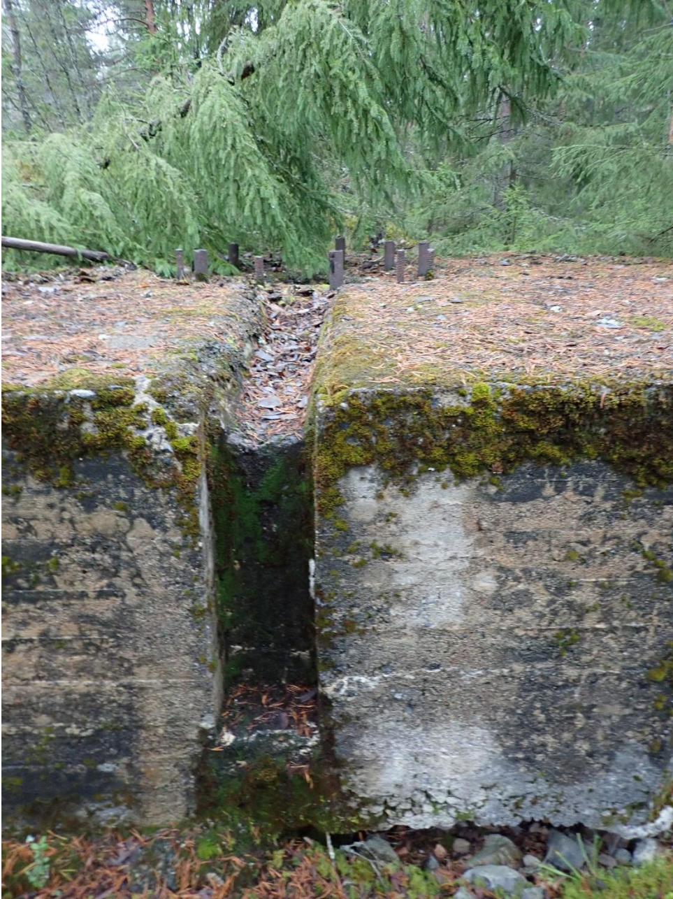
Kuva 5. Yksityiskohta jalustan 3 betonirakenteesta.
