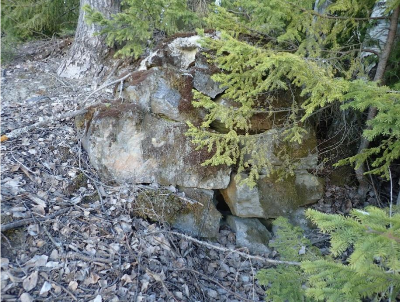
Kuva 12. Kaupin kivirakenne 2 huhtikuussa 2020. Kuvattu etelästä. Kivirakennetta on kuvattu sanallisesti aiemmin tekstissä.
