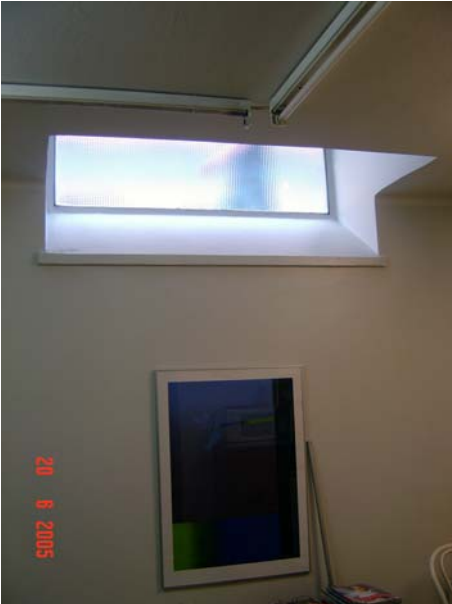
Hildenin liikehuoneiston kellarin valoaukko Näsilinnankadulle.
