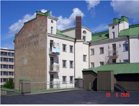
Pihajulkisivu kuvattuna rakennus 2:n katolta.
