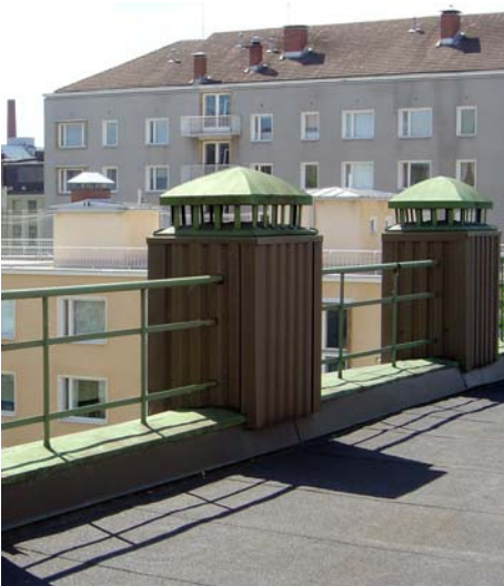
Ulkoseinien pystykanavat kuvattuna katolta.
