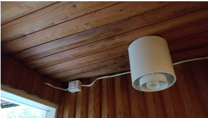
Korjattu panelointi vuodon kohdalla
