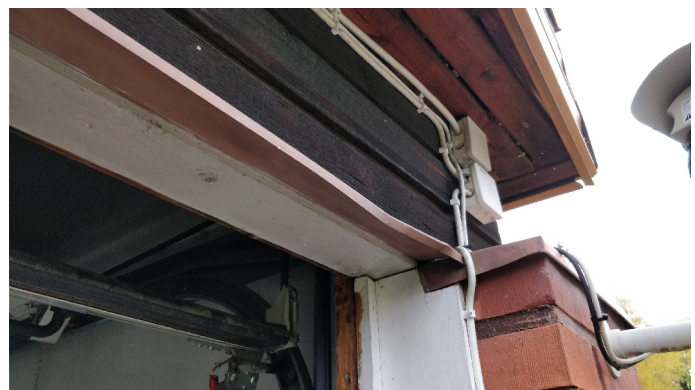
Autotallin ja julkisivun liittymä
