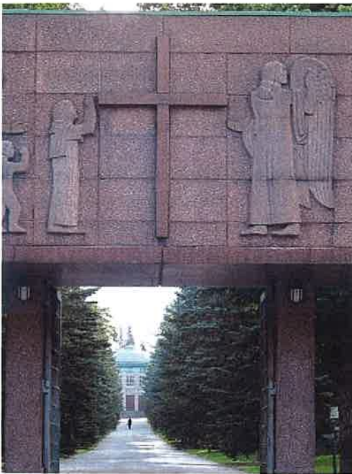
Kappeli pääportilta alkavan pääkäytävän päätteenä.
