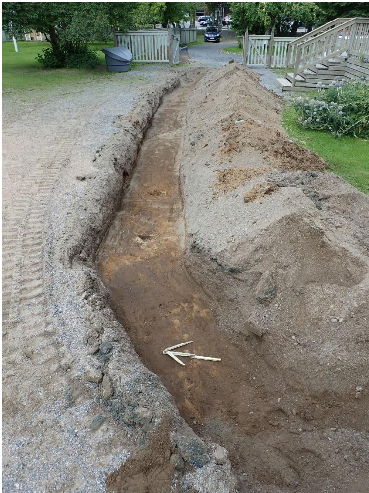
Kuva 5. Koekuoppa 2 (Koeoja) kaivettiin Mikkolan talon eteläpuolelle. Kuvassa täyttömaa poistettu.
