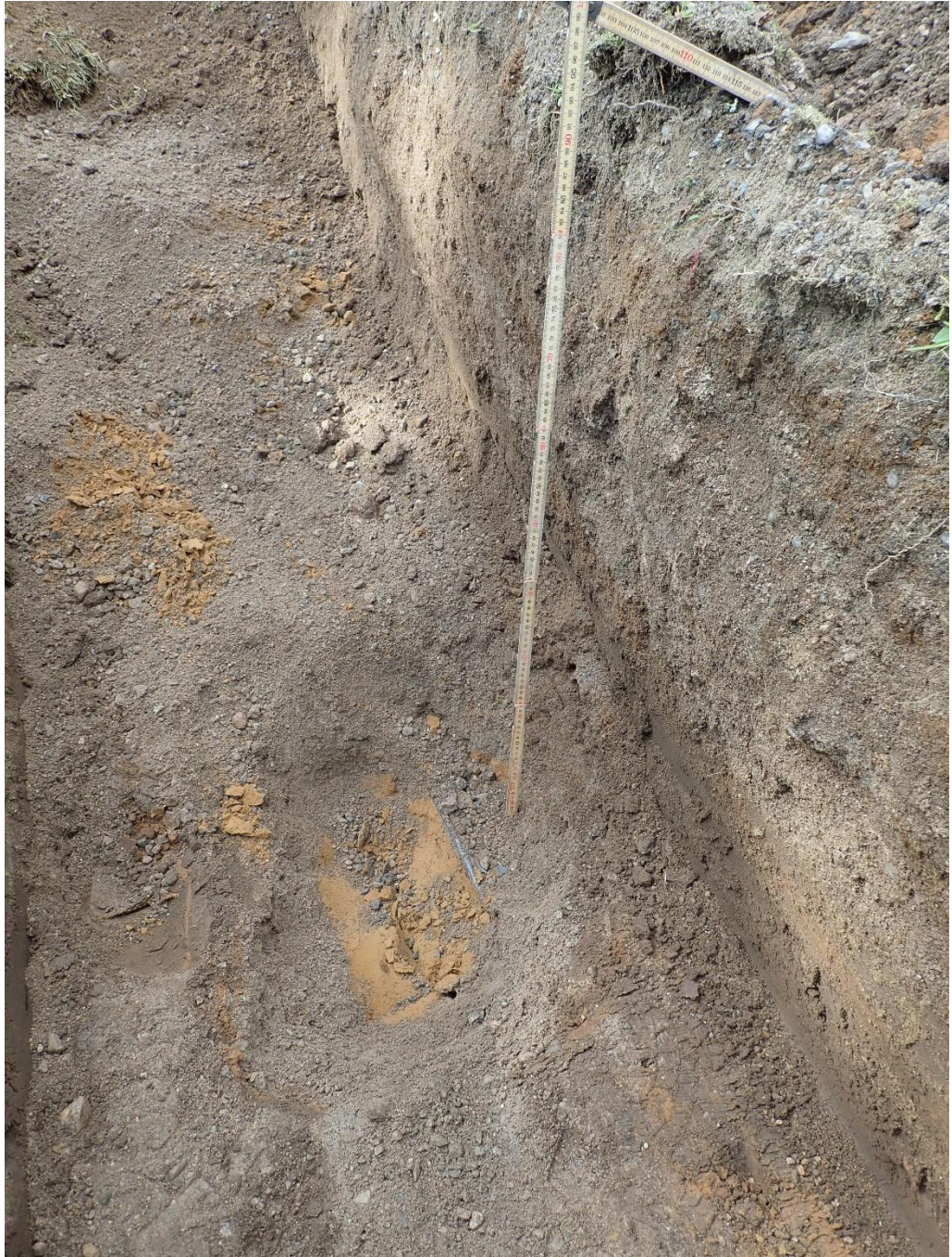
Kuva 12. Mikkolan päärakennuksen itäpuolella maakerrokset olivat voimakkaasti sekoittuneet noin metrin syvyyteen.
