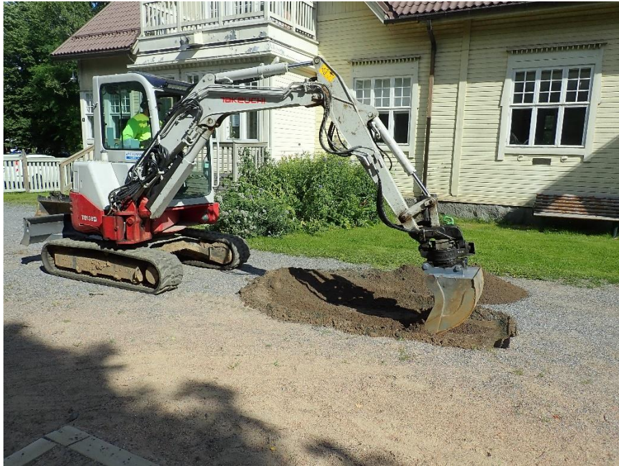
Kuva 2. Koekuoppien kohdalta poistettiin koneellisesti 1900-luvun aikana syntyneet täyttö- ja tasauskerrokset. Koejaa 2 kaivetaan Mikkolan talon eteläpuolelle.
