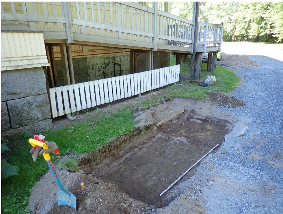
Kuva 19. Koekuoppa 7, pintamaa poistettu.
