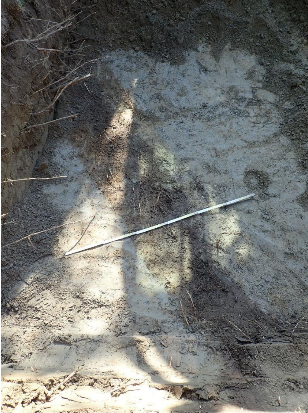
Kuva 4. Kuopan 1 poikki kulki aikaisempi kaivanto, joka pohjalta paljastui betonikouru 150 cm syvyydestä.
