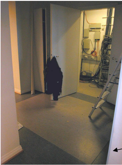
131 Käytävä, takana tekninen tila 129
