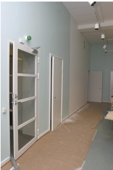
Palo-ovi portaikkoon huoneesta 109
