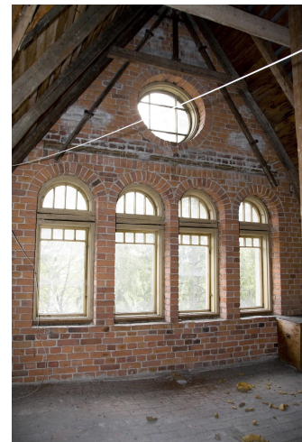
Itäinen varastotila, ikkunat itään
