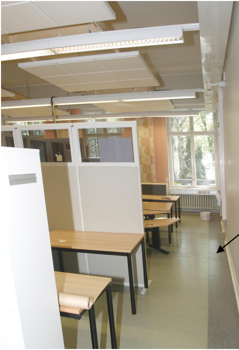
128 Yleiskuva, ikkunat itään
