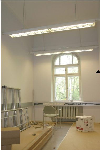
105 Ikkuna länteen, yleiskuva
