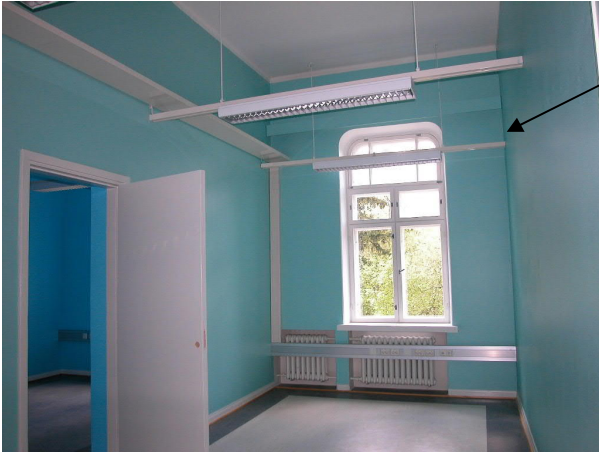
204 Ikkuna länteen, ovi huoneeseen 203
