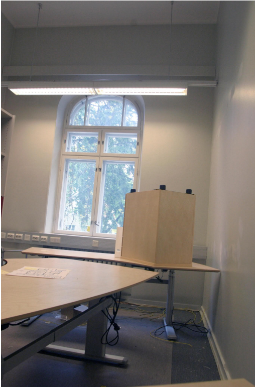
121 Ikkuna itään, yleiskuva
