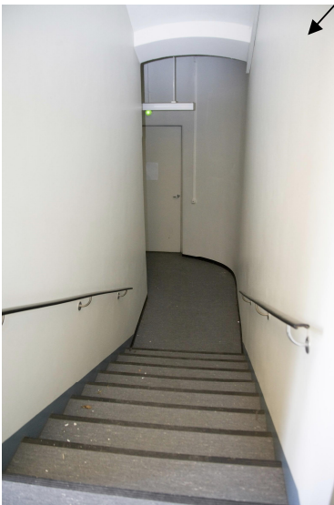
101 Portaikko 1. kerroksesta alas, takaovi
