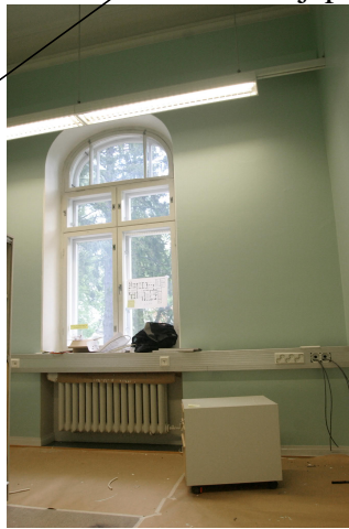
117 Ikkuna itään, yleiskuva
