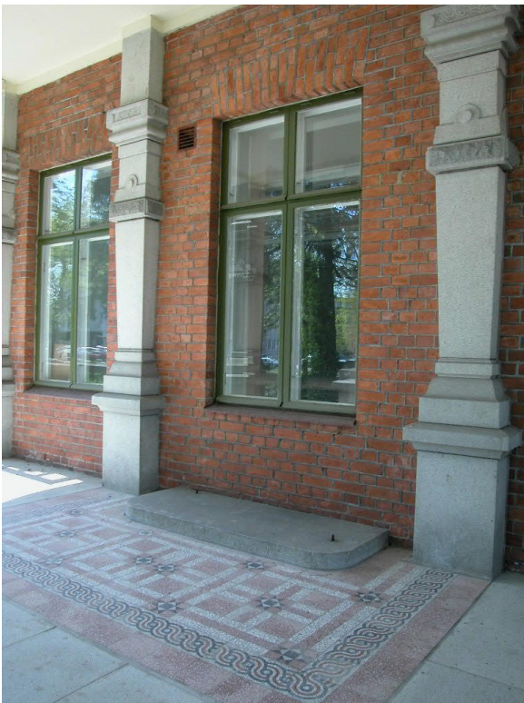
Terassin koristelatoitusta, alkuperäinen pääoven paikka.
