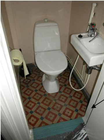
119 WC, vanha lattiaaatoitus
