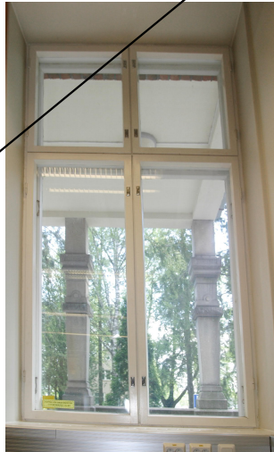
128 Uusi ikkuna itään.
