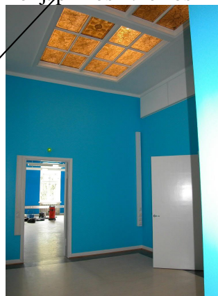
209 Käytävä pohjoisesta etelään
