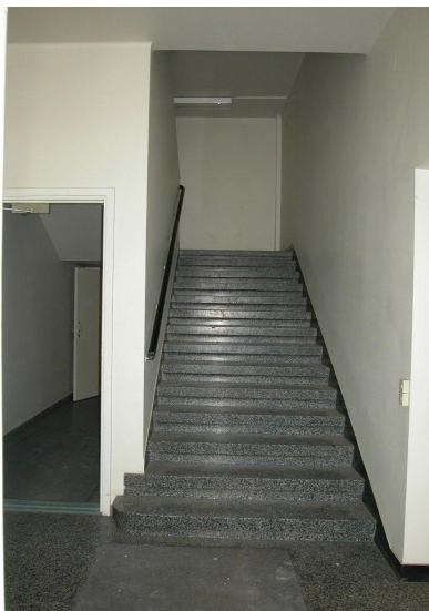
Portaikko eteisestä 127 toiseen kerrokseen
