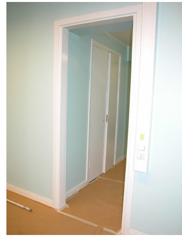
116 käytävä, ovet komeroon 114 ja 115
