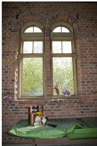
Tornihuone, ikkunat etelään
