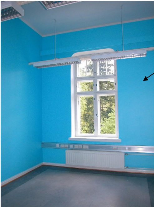
203 Ikkuna länteen, yleiskuva
