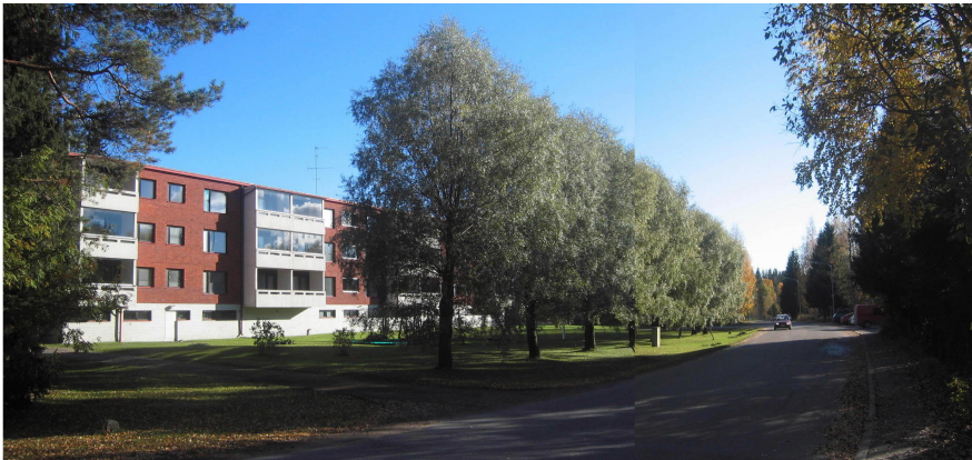
Kuva 64. Kerrostalorakentamista Kaarikadulla, kohde 4. Syksy 2004.
