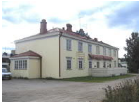
Kuva 38. Ravintola Isabella, entinen Vankka. Rakennus on hyvässä kunnossa. Radan itäpuolella on maanpintaa on nostettu alkuperäisestä. Rakennusten kivijalat eivät ole enää näkyvissä ja ja sisäänkäyntien porrastanteet ovat hävinneet.
