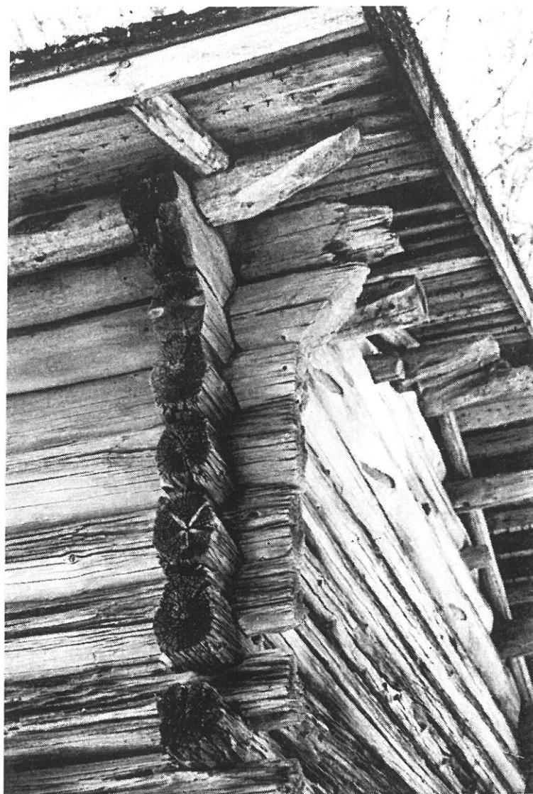
Seinän ulkopuolella katonrajassa viistoksi veistetty siihirsi. Seinähirren päät selvästi kuusikulmaisia.
