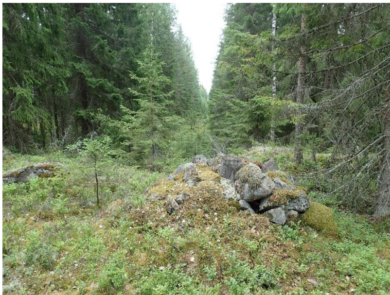
Kuva 1. Vuoteen 1974 mennessä puretun sähkölinjan perustus. Keskellä kivikasaa on puupaalun jäännös.
