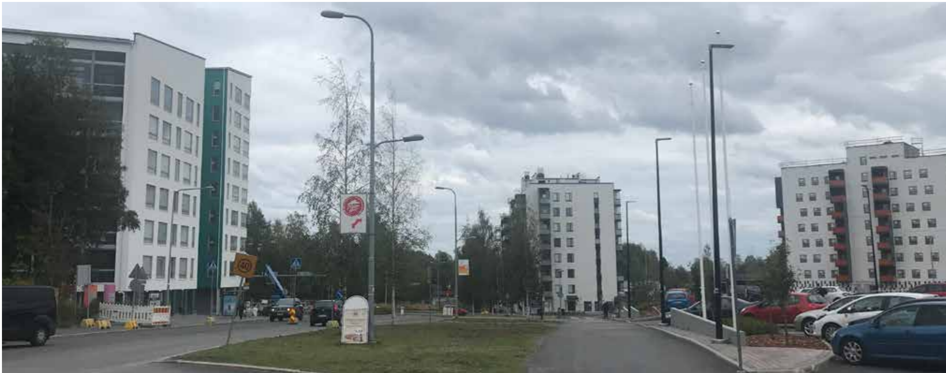
Yllä: Yleisnäkymää kohti etelää ja uutta kiertoliittymää Tesoman valtatieltä. Vasemmalla T2H:n uudisrakennus, oikealla NCC:n Tesoman Seisake, Veturi ja Resiina, jotka ovat Tesoman uutta kerrostumaa.
