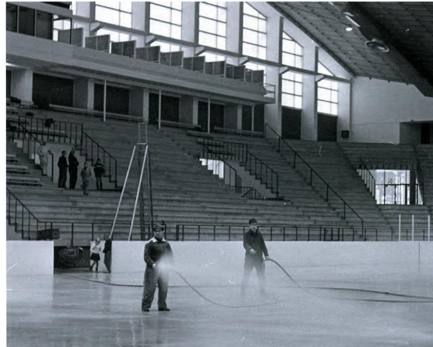
Jäähallin jää tehdään neljässä eri vaiheessa. Kuvallähde: Leinonen, 2015.
