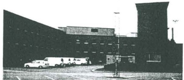
Muuntaja oikealla korkea rakennus, korjaamo sen edessä. Vasemmassa reunassa ja taustalla uusi toimistorakennus.
