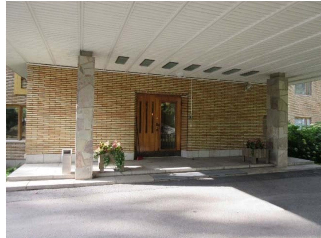
Kuva 109 – Pääsisäänkäyntikatoksen betonipilarit on vuorattu liuskekivin. Liuskekiviä oli käytetty jo 1940-luvulta lähtien paljon rakennusten julkisivuissa ja etenkin pääsisäänkäyntien yhteydessä.
