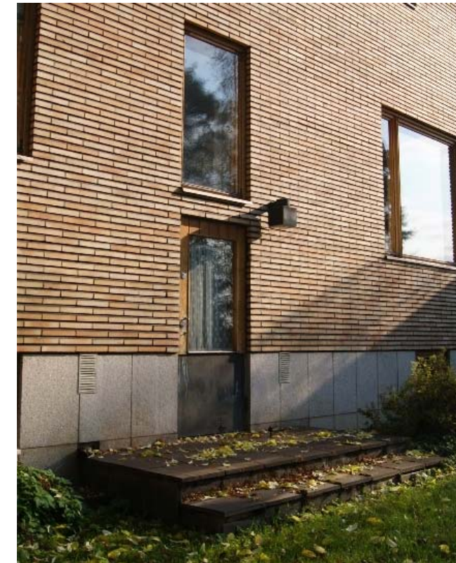
Kuva 105 – Keittiöportaan ulko-ovi. Oven edustan porsas tasoineen on tehty liuskekivilaatoista.
