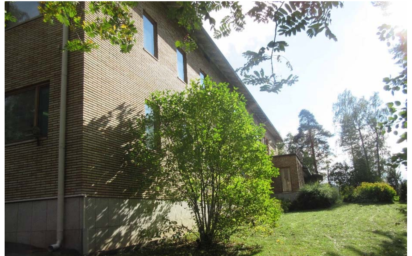
Kuva 55 – Valkeakoskelle toteutettu Waldenin virka-asunto, nykyinen vieraskerho – julkisivua länteen.
