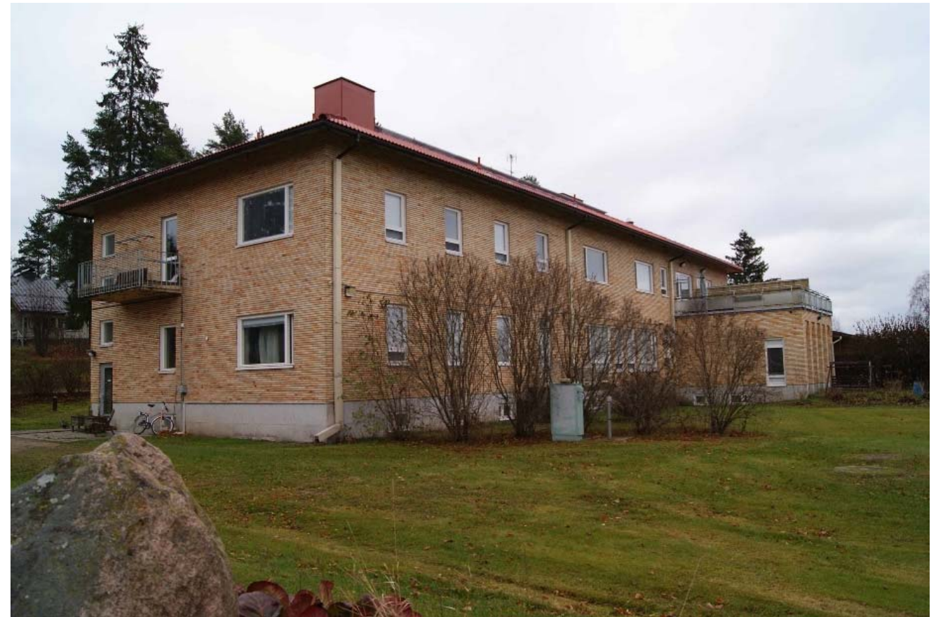
Kuva 54 – Myllykoskelle suunnitellun Waldenin virka-asunto, nykyinen pienkerrostalo – julkisivua länteen.
