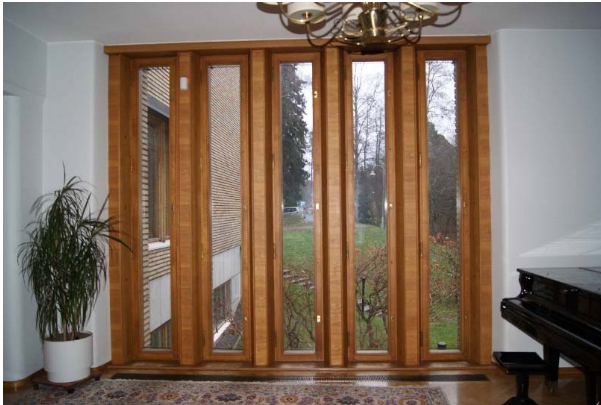
Kuva 235 – Olohuoneen korkeat kapeat ikkunat – tammikarmit, tammipuitteet, messinkihelat – joiden edustalla on useat vieraat toivotettu tervetulleiksi Antinkärkeen. Ikkunat ovat alkuperäisessä asussaan – myös ikkuna ja tukirakenteineen. Ikkunan edustalla lattiassa olevat lämpimän ilman virtausritilät. Kuva on vuodelta 2014.
