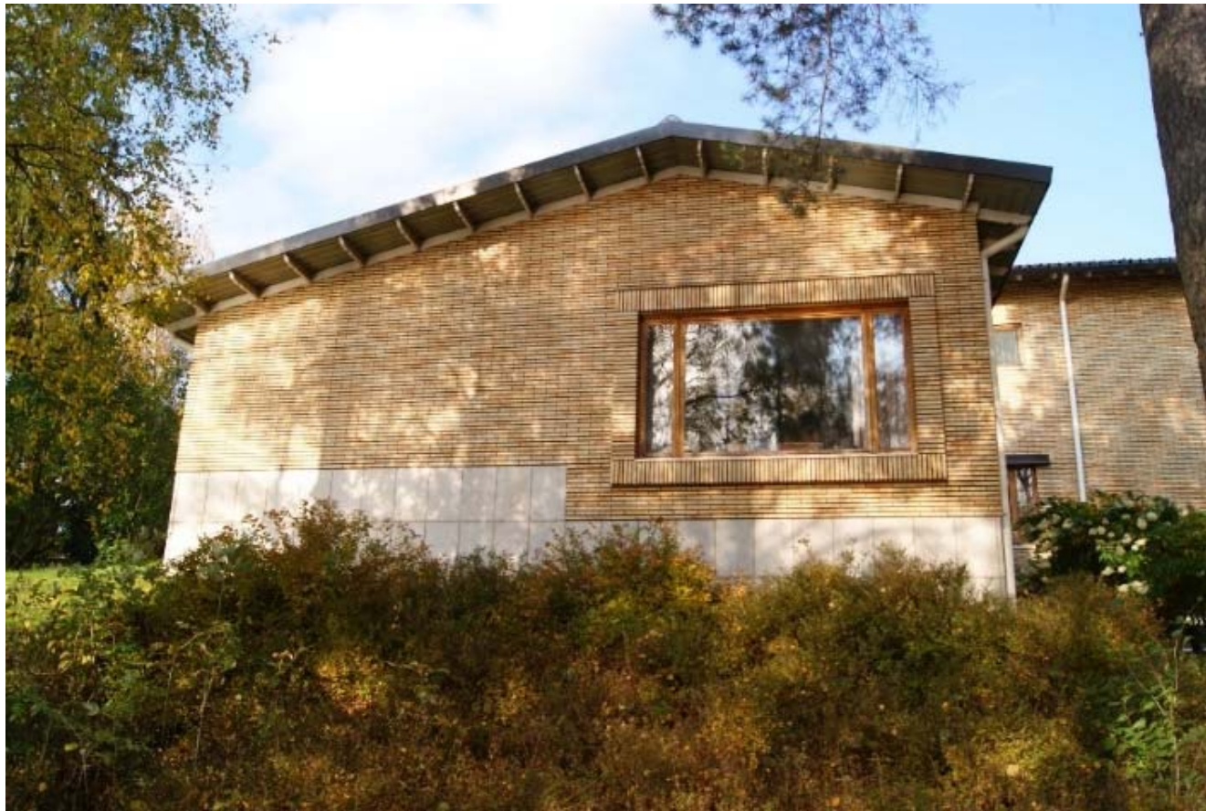
Kuva 111 – Klinkkeritiilin muurattua ikkunan kehysosa.
