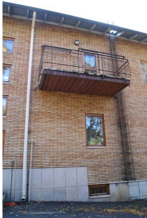
Kuva 119 – Porrashuoneesta pääsee pohjoispuolen tuuletus-/puisteluparvekkeelle. Parveke on teräskaiteinen (kaiteen osat ovat muotoiltu ohuista teräspinoista) ja parvekelaatta on teräsbetonirakenteinen. Parvekkeen alapuolelle on tehty muotilla profiilikuvio, joka on maalattu. Parvekkeen lattiapinta on sileä betonivalu, joka on maalattu.
