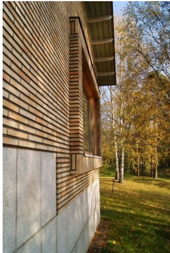
Kuva 112 – Klinkkeritiilin muurattua ikkunan kehysosan yksityiskohta.
