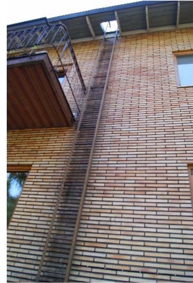
Kuva 129 – Teräsrakenteiset talotikkaat ovat ilmeisesti alkuperäiset. Rästääseen on tehty miehenmentäväaukko vesikatolle pääsyn helpottamiseksi.
