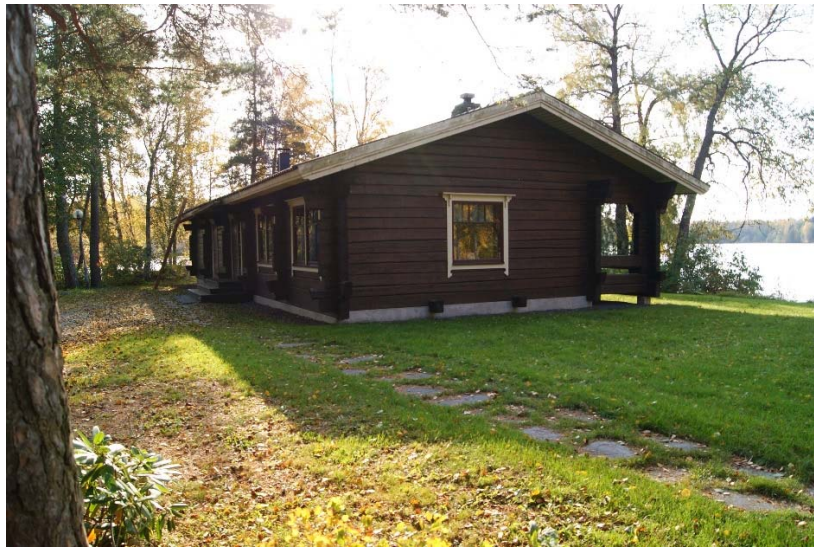
Kuva 29 – Nykyisen saunan julkisivu päärakennukselle päin.
