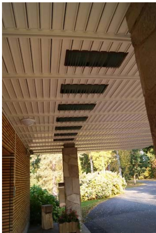
Kuva 116 – Pääsisäänkäynnin katoksen alapuoli on paneloitu.
