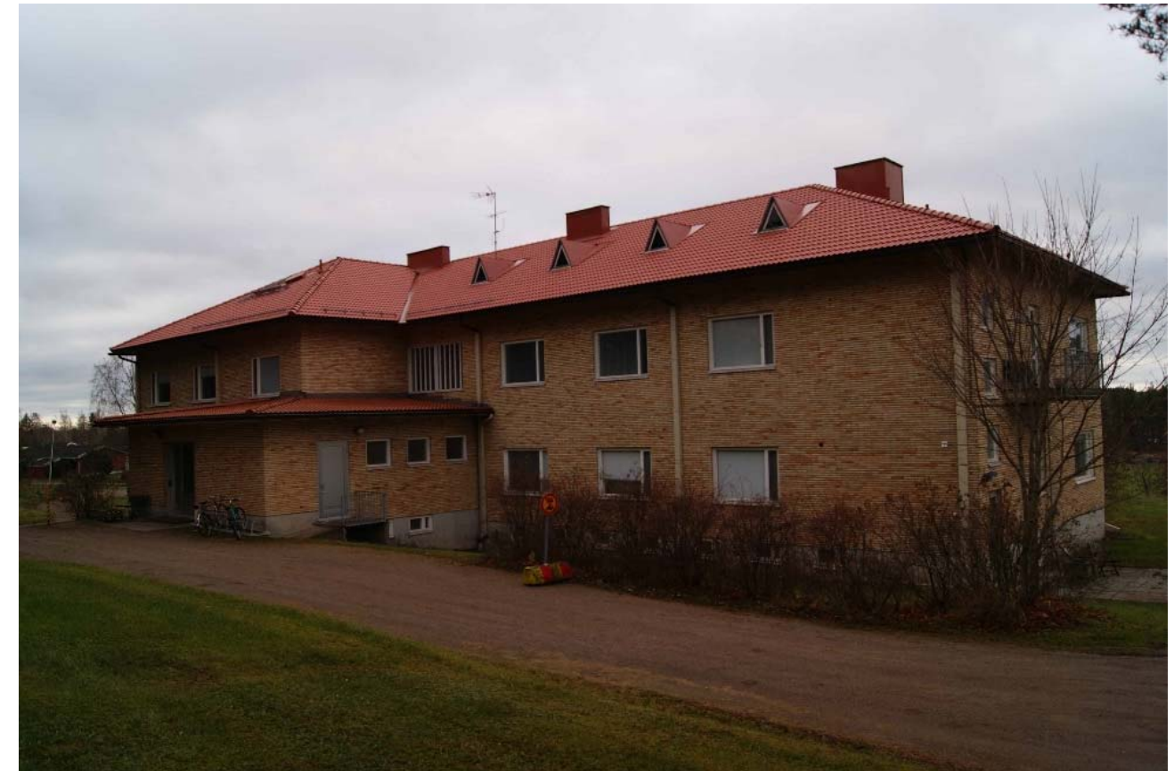
Kuva 50 – Myllykoskelle suunnitellun Waldenin virka-asunto, nykyinen pienkerrostalo – julkisivua itään.
