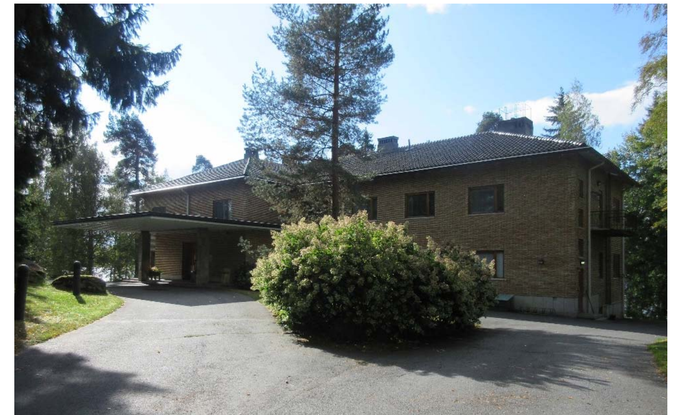
Kuva 51 – Valkeakoskelle toteutettu Waldenin virka-asunto, nykyinen vieraskerho – julkisivua itään.
