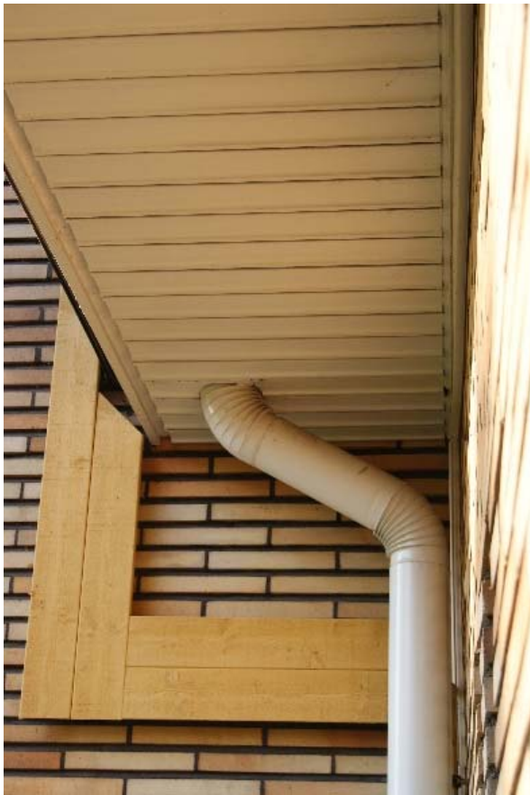
Kuva 115 – Pääsisäänkäynnin katoksen sivuräystäät ovat paneloitu/koteloitu, syöksytorven läpiviennit on tehty paneeliin.
