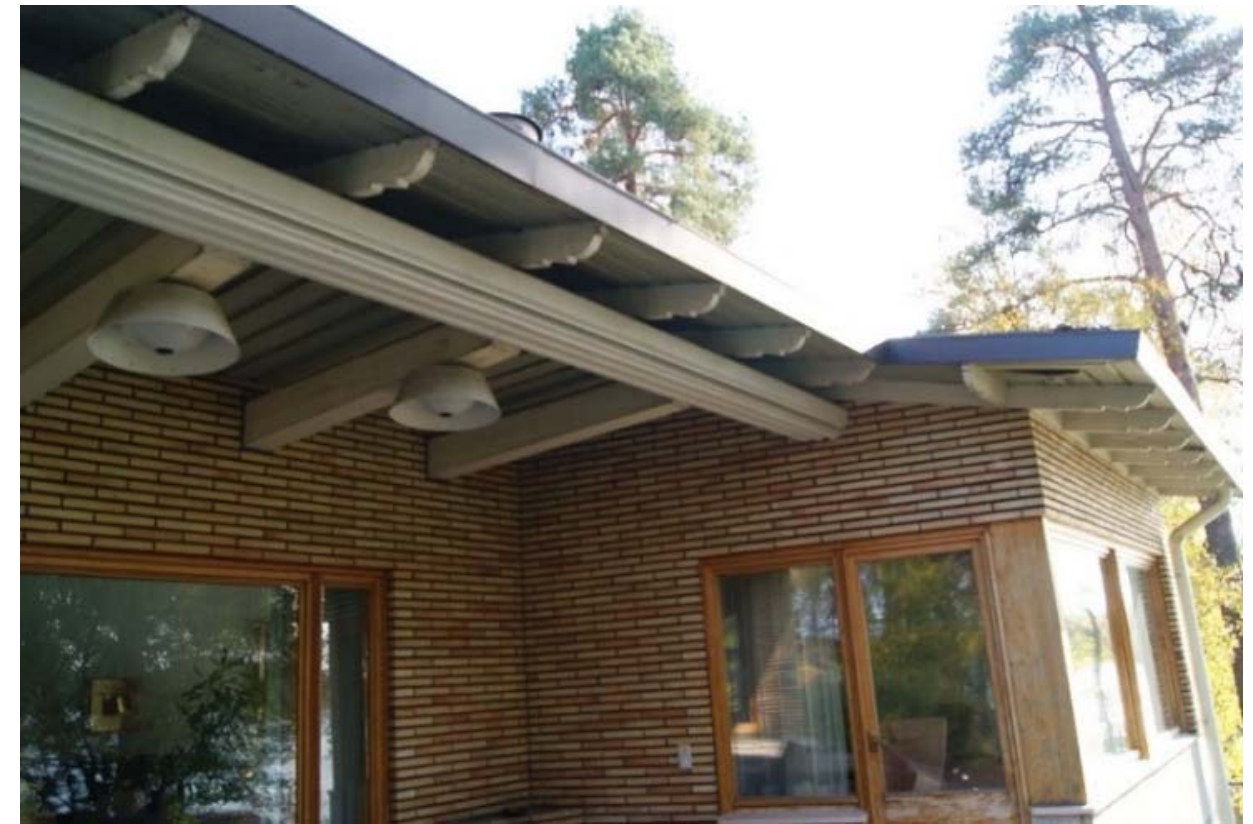
Kuva 113 – Läntisen puolen katoksen räystääs on avoräystääs ja katokseen liittyy markiisikotelo, kuvan lamppujen edessä oleva kotelorakenne. Markiisi ei ole ollut käytössä muistitiedon mukaan ainakaan vuoden 2004 jälkeen, voi olla että markiisia ei ole käytetty Juuso Waldenin lähdön jälkeen.
