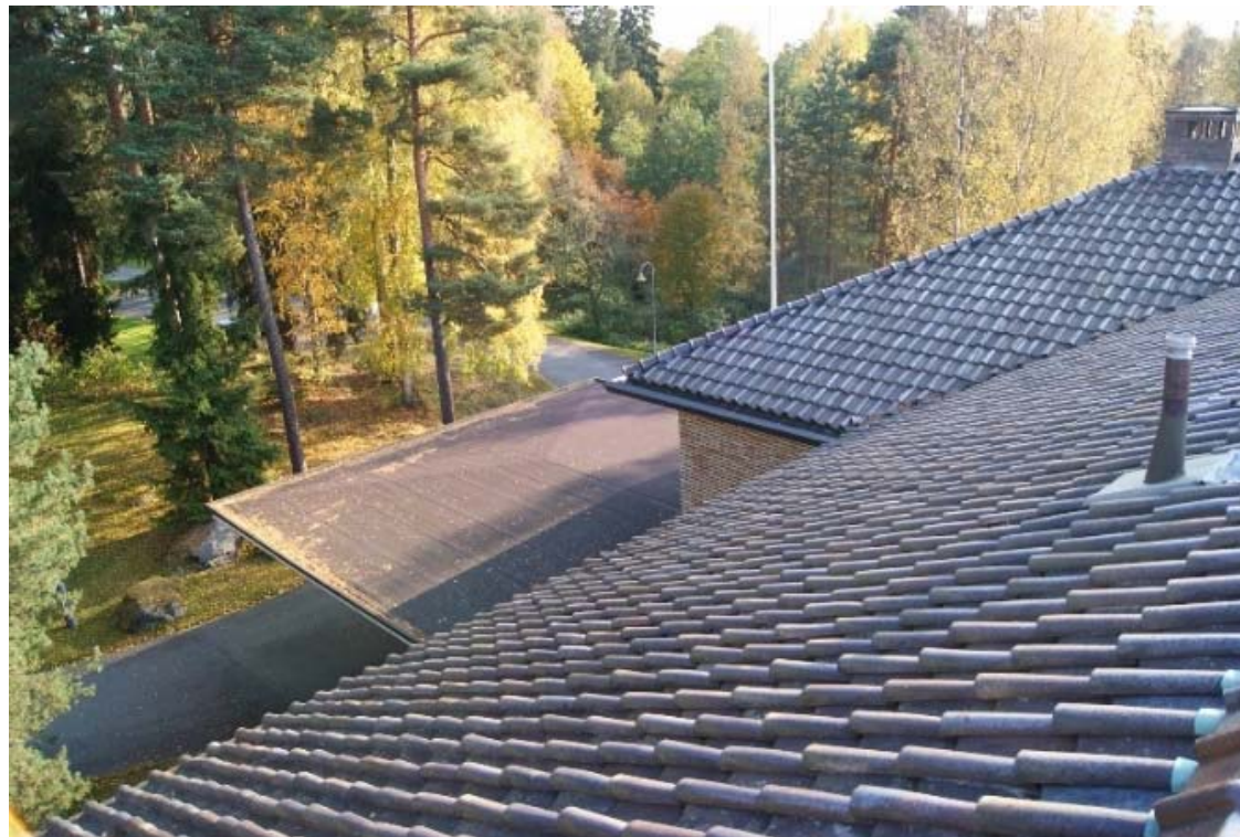
Kuva 124 – Vesikattonäkymä sisääntulokatokseen päin.
