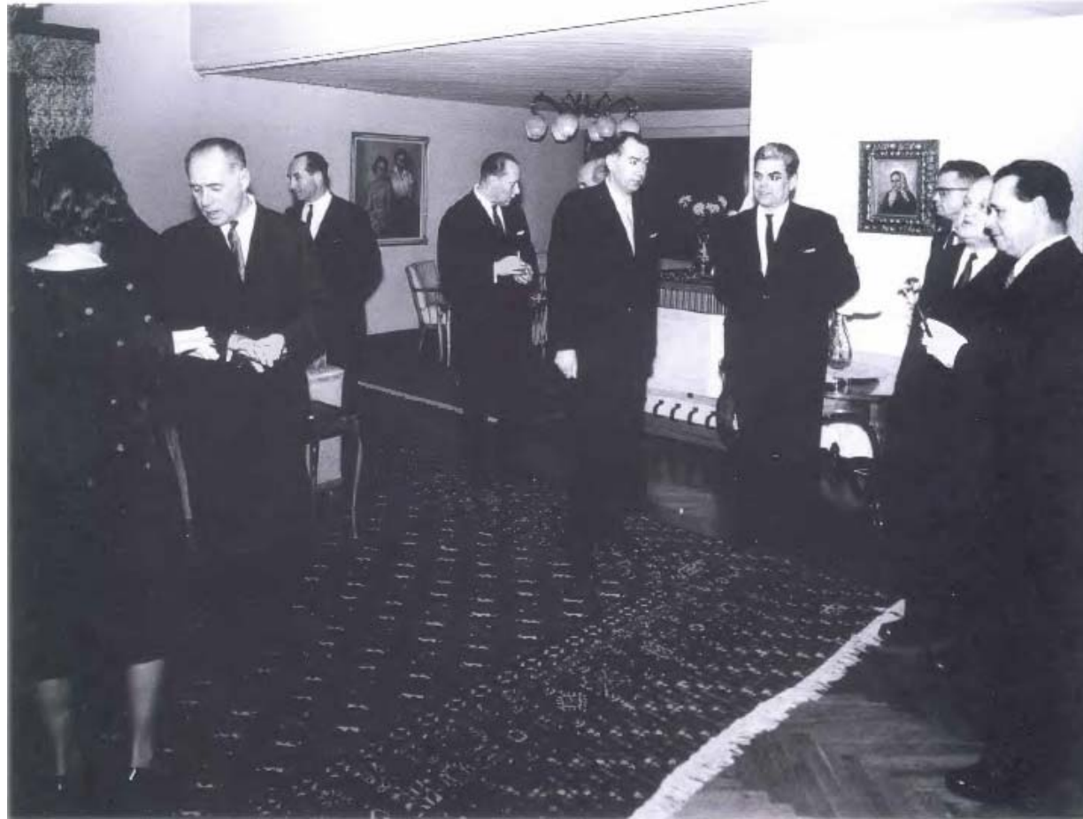
Kuva 230 – Kuva on ulkomaankauppaministeri Nikolai Patolitshev vierailun ajalta. Olohuoneen alaslaskettukatto on vaalea. Taustalla katossa näkyy Paavo Tynellin suunnittelema valaisin. Kuva on vuodelta 1962, UPM-Kymmene Oyj, Valkeakosken keskusarkisto.
