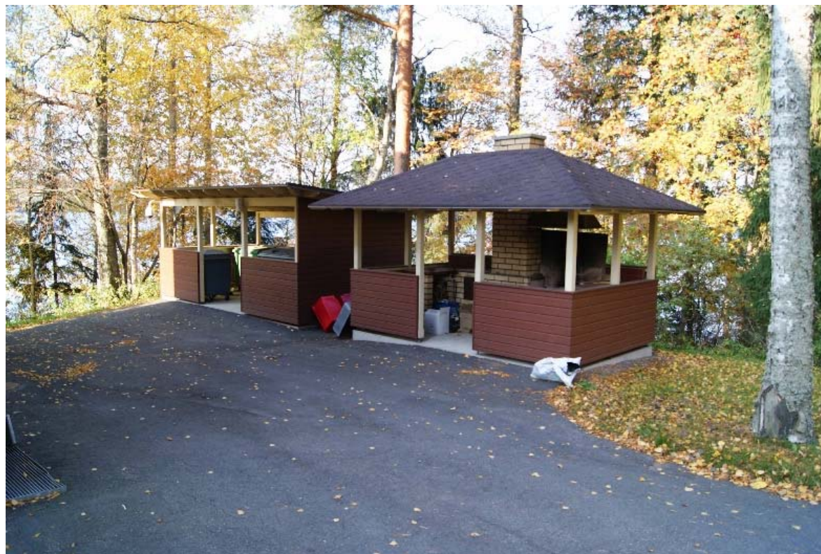
Kuva 18 – Keittiöhuoltokäynnin läheisyydessä (pohjoispuolella päärakennusta) sijaitsevat jäte- ja grillikatos, jotka saivat rakennusluvan 3.9.2001.
