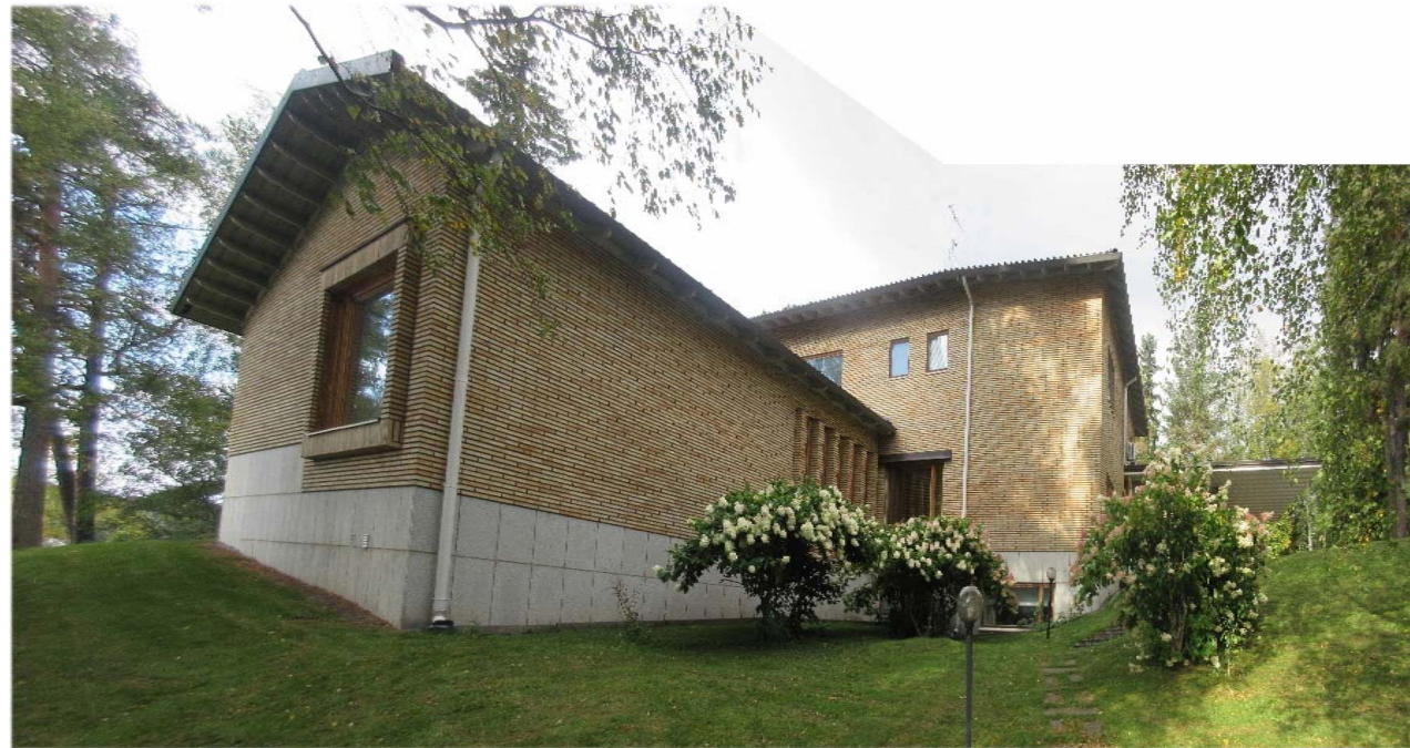
Kuva 57 – Valkeakoskelle toteutettu Waldenin virka-asunto, nykyinen vieraskerho – julkisivua etelään. Valokuva on yhdistelmä kahdesta kuvasta josta aiheutuu tilan Kenraali siipiosan perspektiivi venymä.
