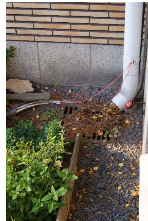
Kuva 118 – Syöksytorven alapäässä on sadevesikaivo (asennus vuosi?) ja ilmeisesti samalla on asennettu sokkelin vierustan sora-alue-rajaus. Alkuperäisessä asussaan – 1950-luvun rakentamistavan mukaisesti – nurmikko oli kasvanut sokkeliin asti ja leikattu sokkelinvierestä siististi.
