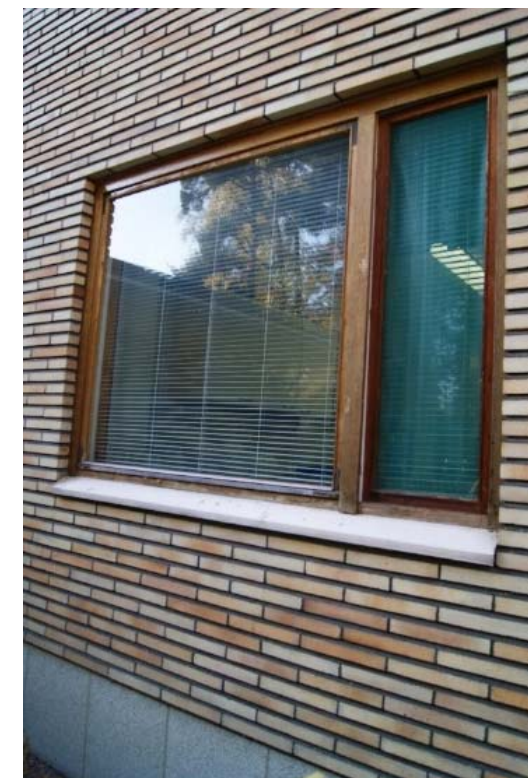
Kuva 95 – Ensimmäisen ja toisen kerroksen ikkunat on tehty suurelta osin siten että: ulkopoka ja karmien ulkoreuna ovat tammaa ja muu osa karmia polttomaalattu. Kuvan ikkunan ulkopoka ja karmien ulkoreuna on tammaa, sisäpoka on valikoitua mäntyä, karmi peittomaalattu.
