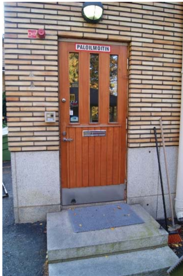
Kuva 103 – Keittiön huollon/porrashuoneen ulko-ovi – ovi ei ole alkuperäinen (alkuperäisen suunnitelmapiirros oikealla), uuden oven asennus/valmistusvuotta ei ole tiedossa. Oven edustan porrastasot on tehty luonnonkivistä. Piirros UPM-Kymmene Oyj, keskusarkisto, Valkeakoski.
