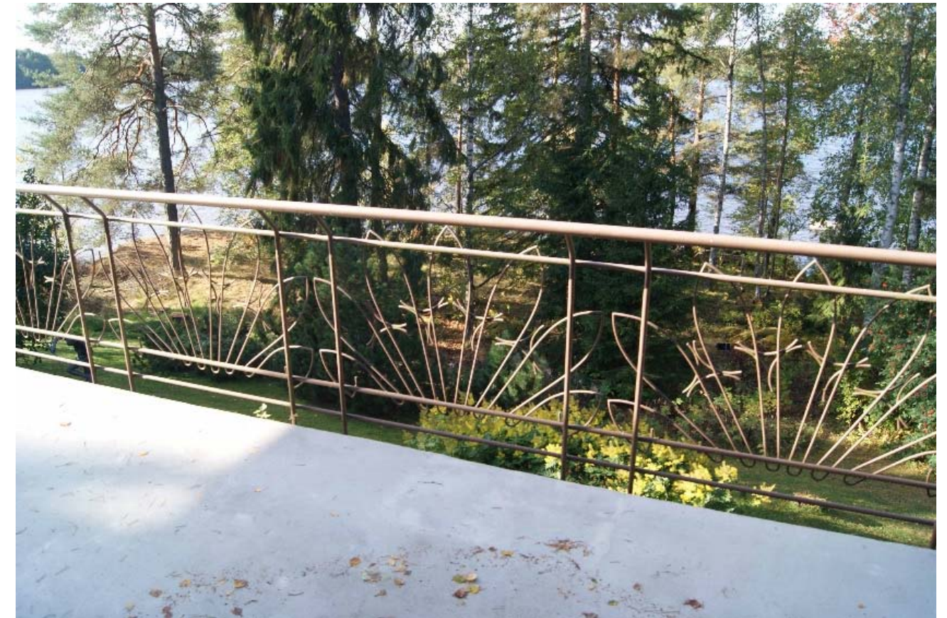
Kuva 121 – Parvekkeen teräsraakenteinen kaide.
