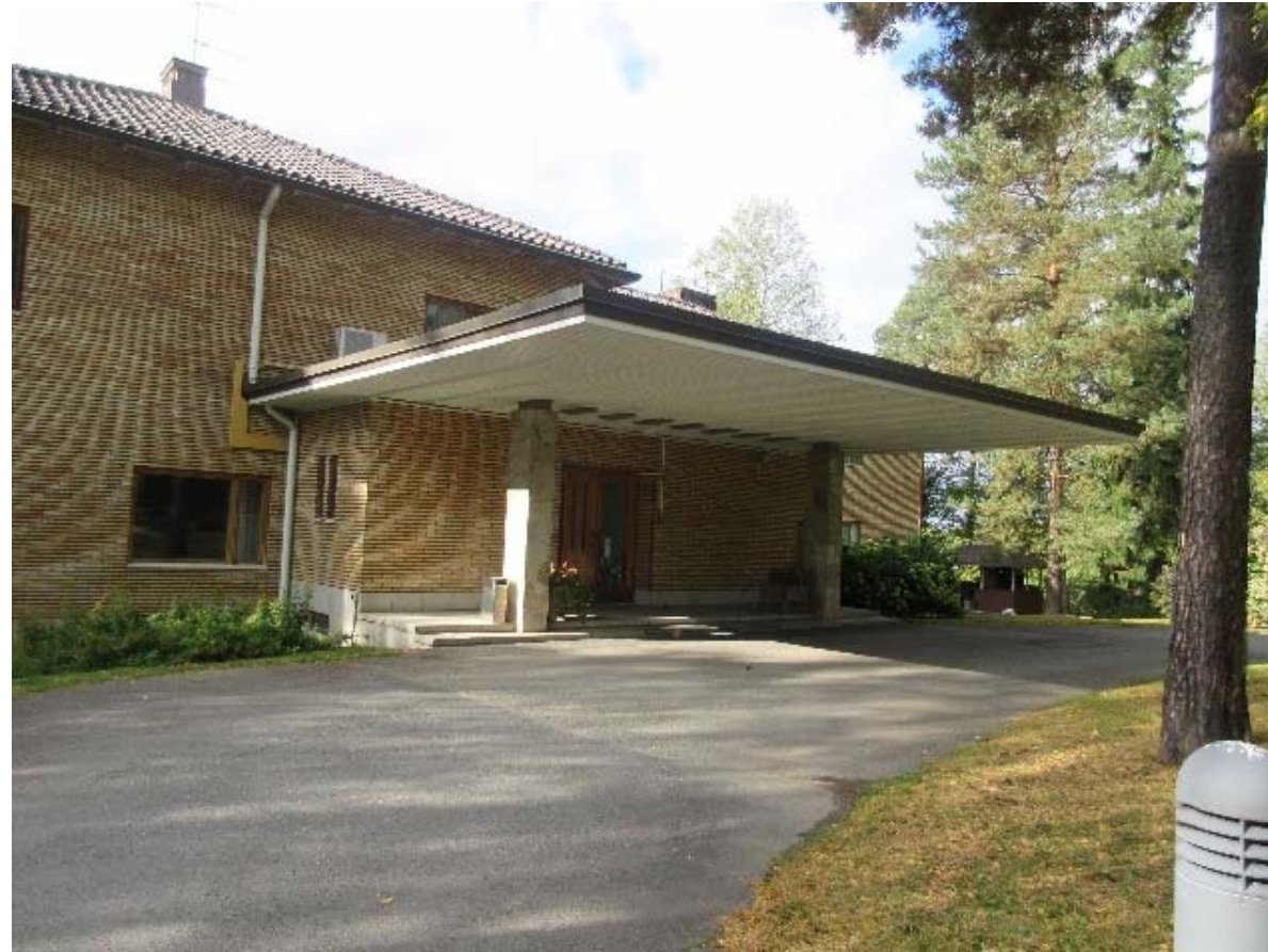
Kuva 127 – Pääsääntulokatos – asfaltoitu edustatila, ajoväylä.
