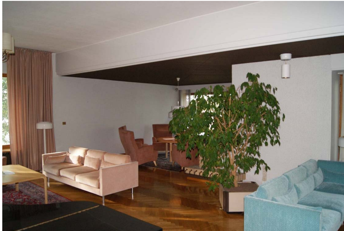
Kuva 231 – Tilan Kenraali alaslaskettukatto on maalattu ruskeaksi. Valaisin muutoksia on tehty ajansaatossa, korkean tilan valaisimet ovat säilyneet. Kuva on vuodelta 2014 (ennen ja nyt – kuvapari, kuvarajaus on erilainen).
