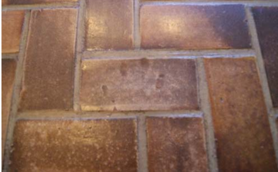
Kuva 153 – Sisääntuloaulan naulakoiden edessä olevaan klinkkeriin on laatan tekijän jättämät sormenjäljet, klinkkeriä ei ole poistettu asennuksen yhteydessä eikä Juuso Waldenin käskystä.
