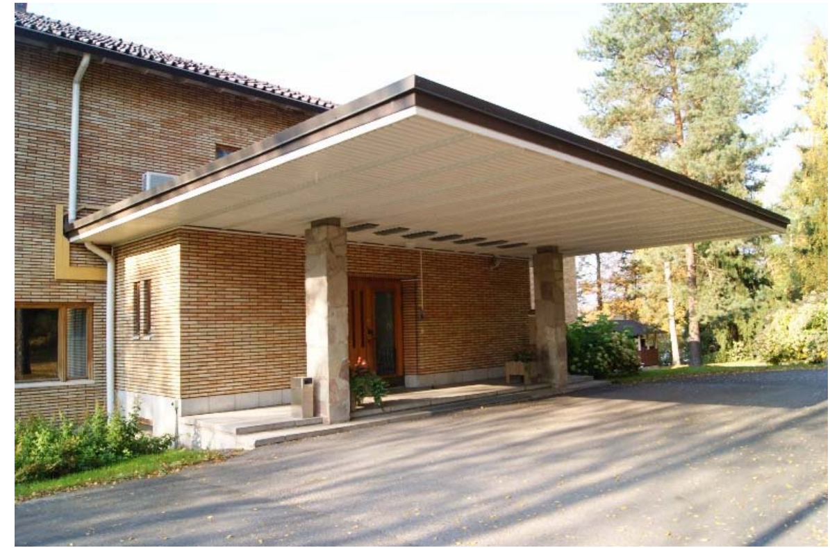
Kuva 15 – Päärakennuksen pääsisäänkäyntikatos. Taksit yms. liikenne pääsee suoraan ajamaan päärakennuksen katoksen alle.
