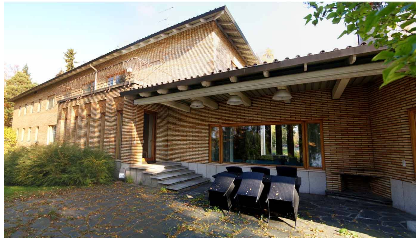
Kuva 128 – Oleskelukatos ja markiisikatoksella suojattava ulko-oleskelualue, jossa on liuskekivilaatoitus. Kuva on yhdistelmä useammasta kuvasta, joka aiheuttaa perspektiivivääristymän.
