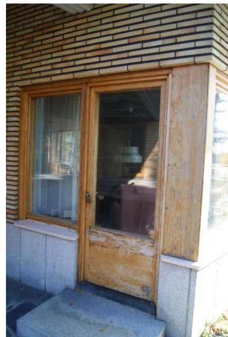
Kuva 100 – Tilan Kenraali ulko-ovi. Oven edustan porrastaso on tehty luonnonkivestä, kuten sokkelit.
