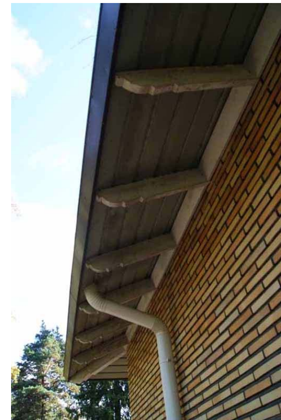
Kuva 114 – Räystäät ovat avoräystäitä, kattotuolien päät on muotoiltu koristeelliseksi.
