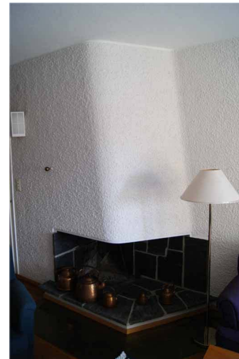
Kuva 186 – Toisessa kerroksessa yläaulan takka (T5).
