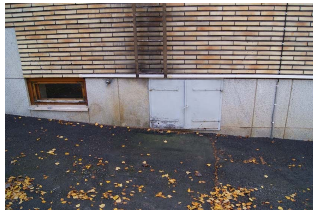
Kuva 104 – Teräsrakenteinen pariluukku, jonka takana on varastotilasyvennys – tila puutarhaletkulle ja kastelukannulle.
