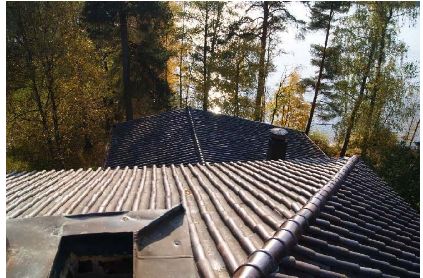
Kuva 125 – Tilan Kenraali vesikatto – kuvan alempi katto-osa.
