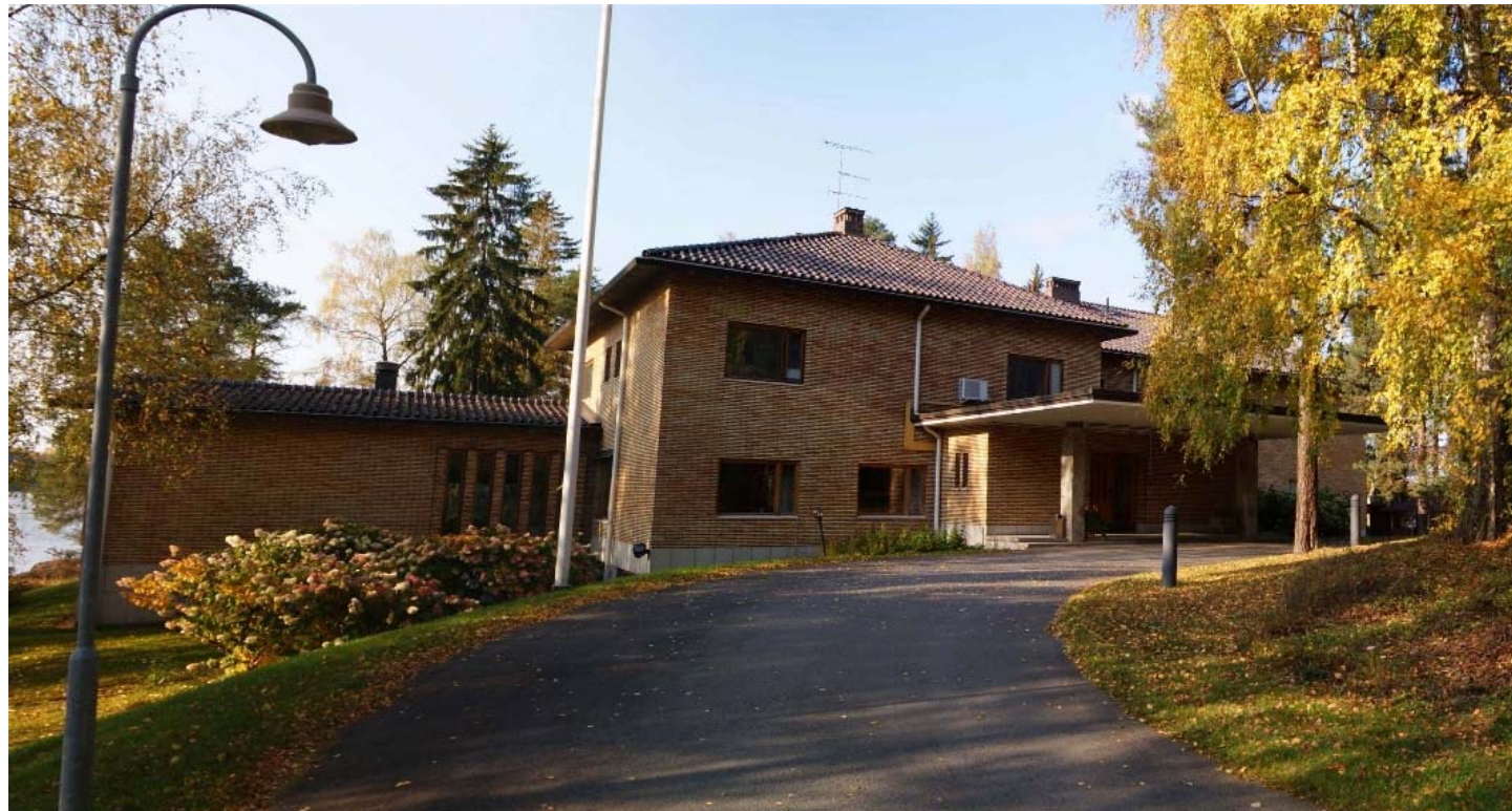
Kuva 60 – Antinkärki, sisääntulojulkisivu – kuvattuna läheltä autopaikoitusta.
