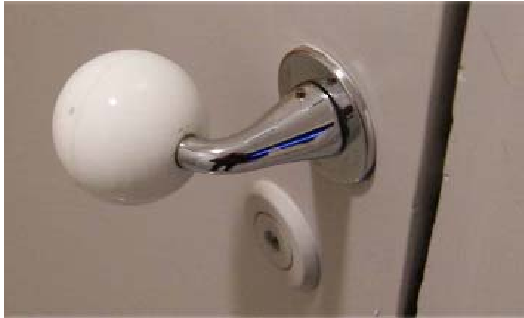
Kuva 169 – Vuoden 1971 muutoksessa osaan ovista (ainakin kellari- ja 1. kerroksessa) on asennettu taitelija Timo Sarpanevan (vuonna 1976 professori) suunnittelema Pallopainike, joka kuului Primo Oy, Malmi tuotemallistoon. Pallopainikkeen valmistus alkoi vuonna 1964. 1 (*Tieto saatu Tom Sarpanevalta, 2014) Pallopainikkeita on ullakolla varastoituna – painikkeita on ajan myötä ovien muutoksissa poistunut.
