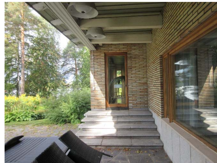
Kuva 102 Tilan Gallerian ulko-ovi. Portaat on tehty luonnonkivilaatoilla, kuten sokkelit.
