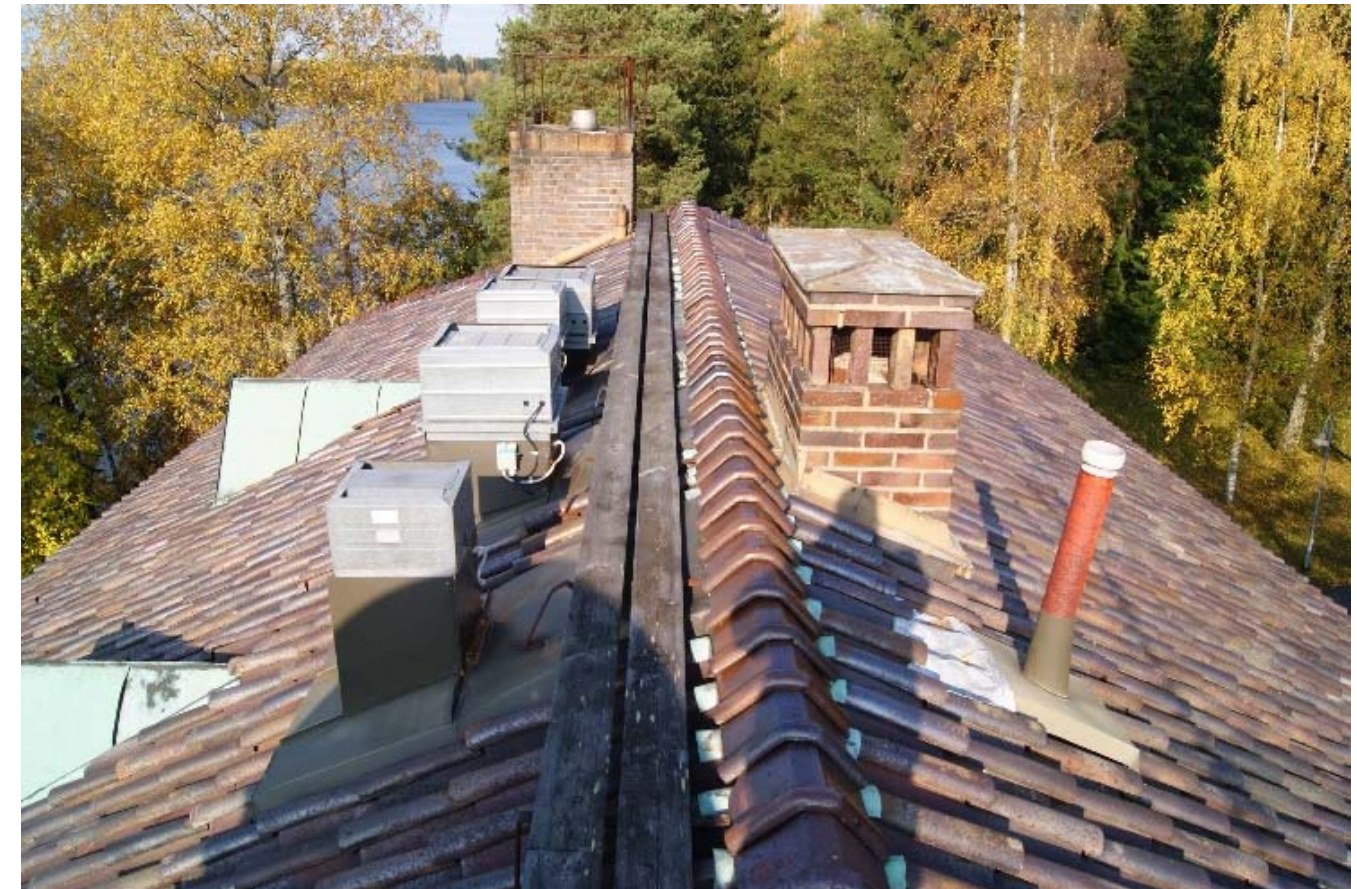
Kuva 126 – Vesikattonäkymä pohjoiseen päin.
