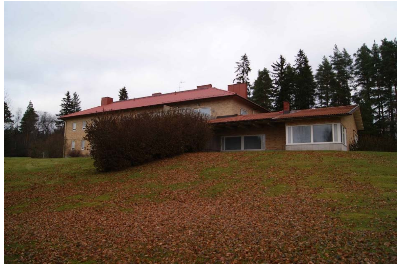
Kuva 58 – Myllykoskelle suunnitellun Waldenin virka-asunto, nykyinen pienkerrostalo – julkisivua länteen.
