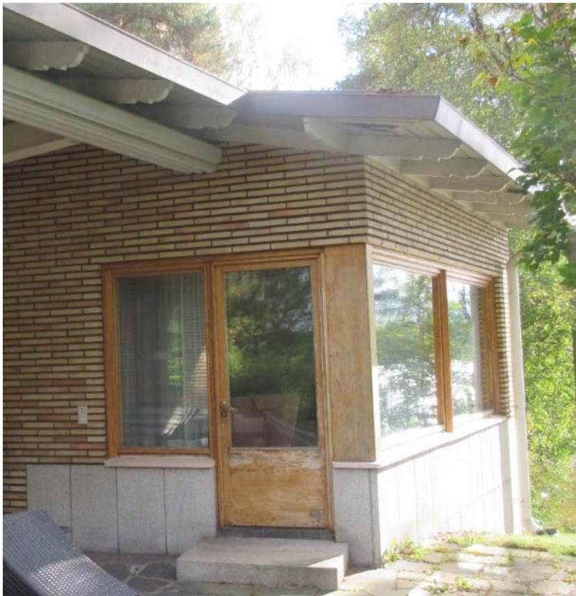
Kuva 96 – Ensimmäisen kerroksen edustustilojen ikkunat on tehty siten että: umpiosat, koristeosat, pokat ja karmit ovat tammesta – sisä- ja ulkopuolella.
