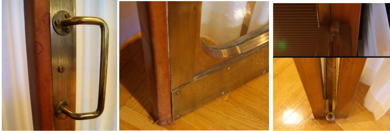
Kuva 143 – Pronssikehysoven vedin ja nahkapäällinen sekä kehyksen kulman pyöristysyksityiskohta. Ovet ovat ylä- ja alasaranoitu.
