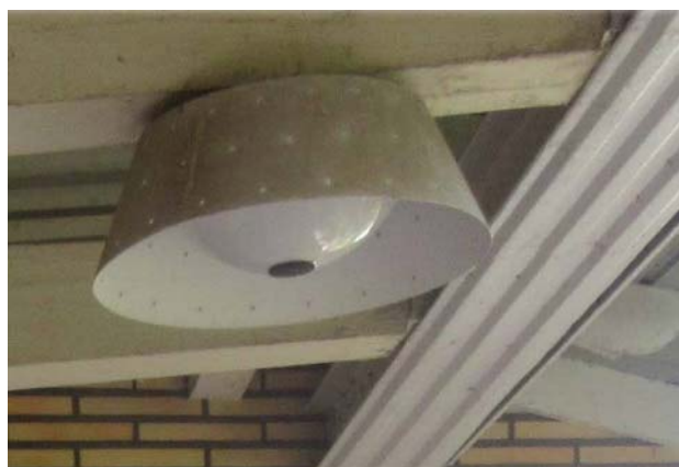
Kuva 133 – Alkuperäinen länsipuolen katoksen valaisin – suunnittelija Paavo Tynell (?), varjostin on Tynellille tyypillinen rei'itetty varjostinosa.
