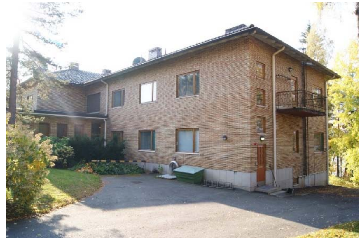
Kuva 110 – Klinkkeritiilin muurattua julkisivua – sokkelissa luonnonkivilaatat.
