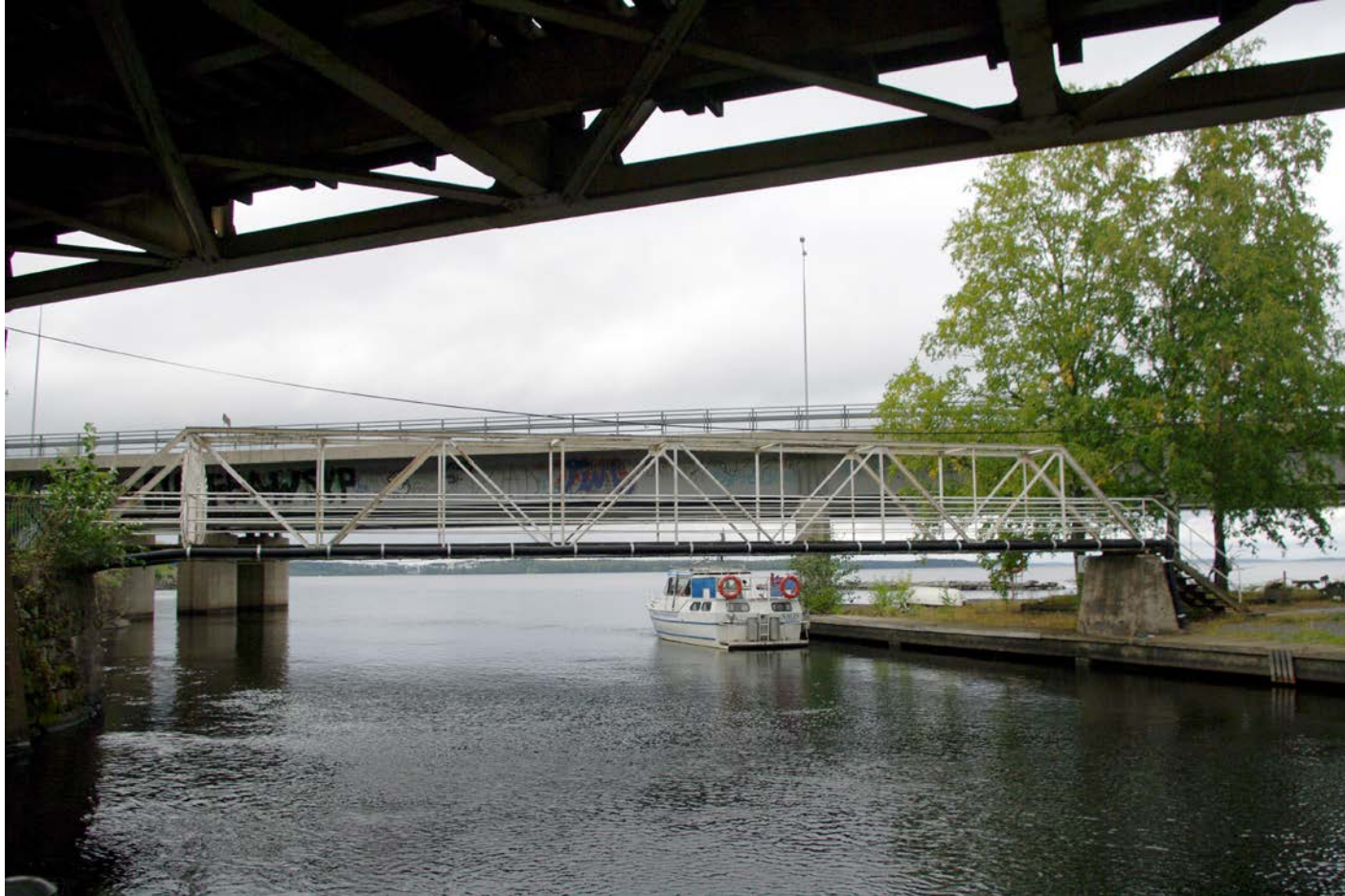
Pajasaaren silta nykytilassaan. Kuvattu 5.9.2019. Kuva otettu Mältirannan puolelta kohti Näsijärveä.
