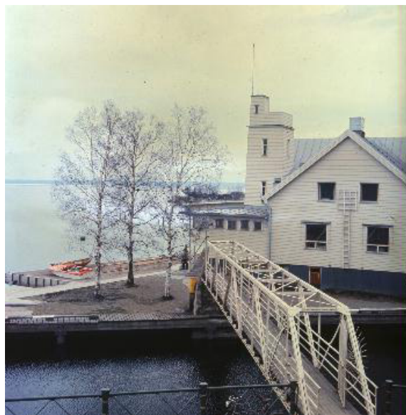
Teräsrakenteinen silta muutoksien jälkeen 1970-1980-luvulla. Eino Laaksonen. Tampereen museot.
