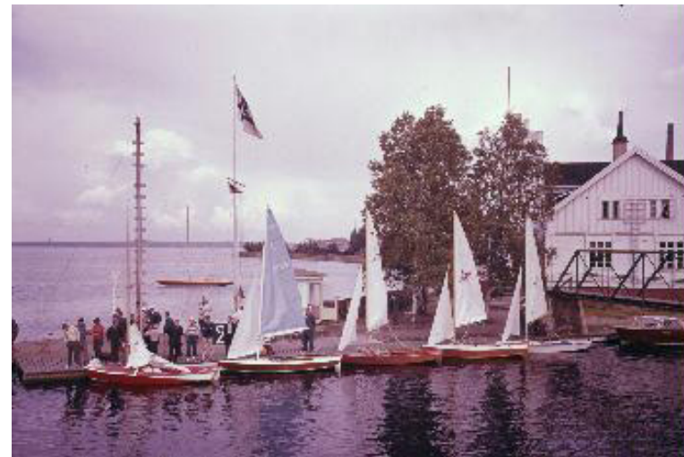
Teräsrakenteinen silta 1960-luvulla. E.M.Staf. Tampereen museot.
