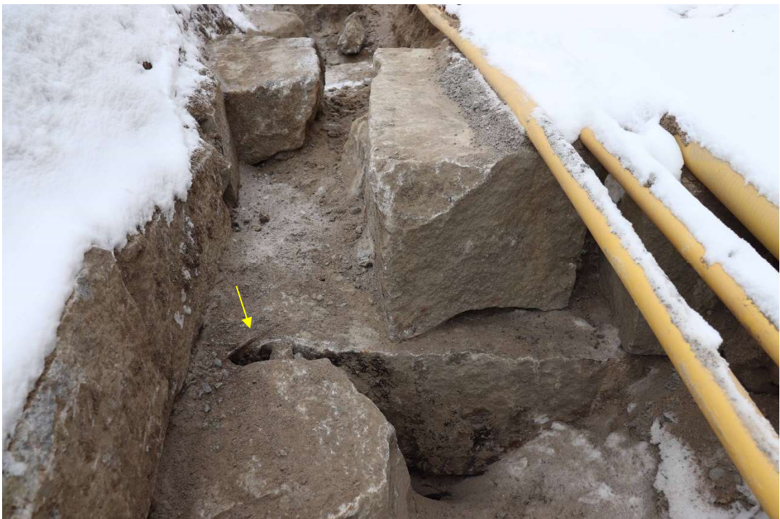
Kuva 37. Rakenne C3 kuvattuna pohjoisesta. Rakennetta ja kosken tukimuuria yhdistävä rauta-vaarna on merkitty kuvaan nuolella. (Kuva: Tampere Frenckell 2019:18)
