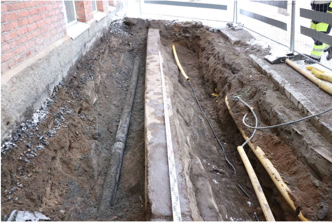
Kuva 19. Rakenne B1 kuvattuna kaakosta. (Kuva: Tampere Frenckell 2019:9)
