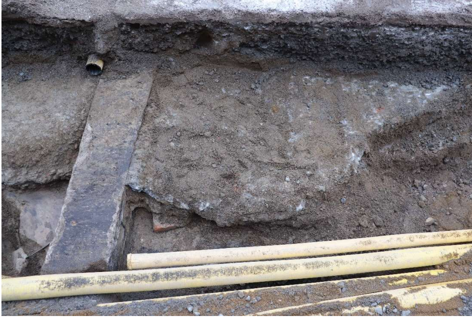
Kuva 42. Rakenteen D1 eteläosa kuvattuna lännestä. (Kuva: Tampere Frenckell 2019:22)
