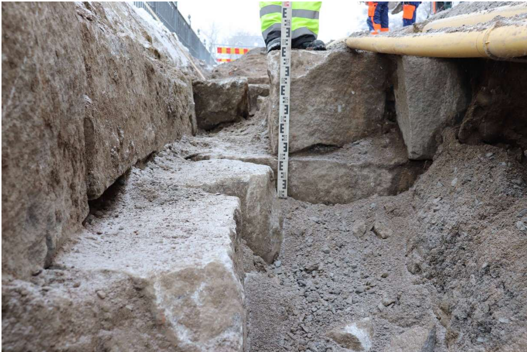
Kuva 36. Rakenne C3 kuvattuna pohjoisesta. (Kuva: Tampere Frenckell 2019:17)
