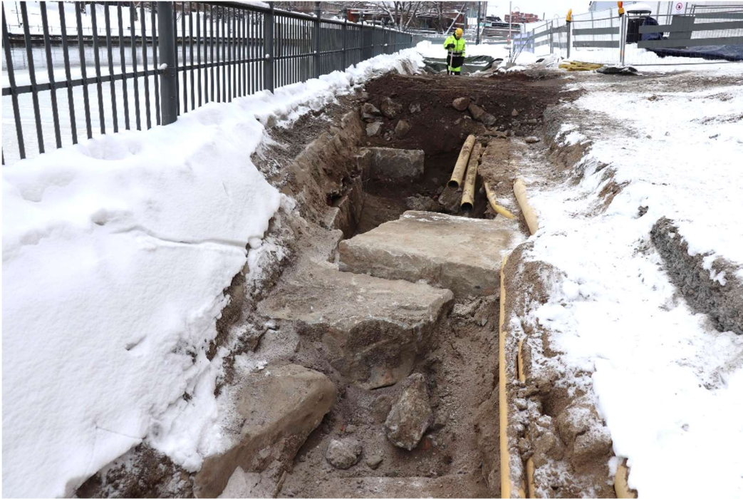
Kuva 34. Rakenne C2 kuvattuna pohjoisesta. Kuvassa taustalla rakenne C1. (Kuva: Tampere Frenckell 2019:15)
