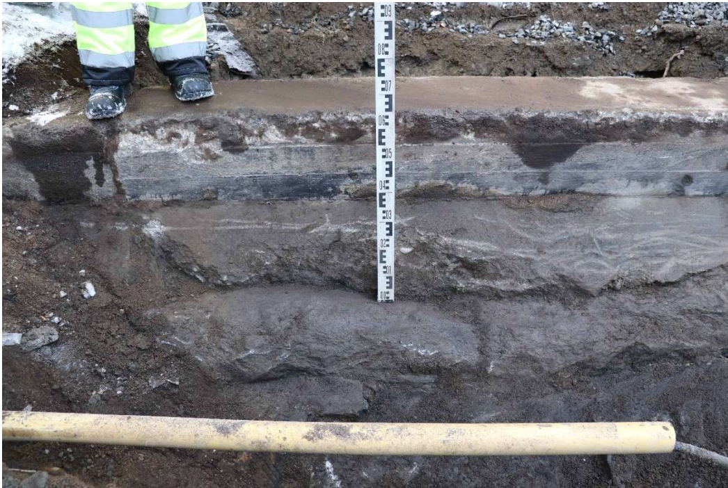
Kuva 21. Rakenne B1:n itäseinämä. Latta lepää betonisen osan alla olevan ensimmäisen kiviker- ran päällä. Kuvattu koillisesta. (Kuva: Tampere Frenckell 2019:11)
