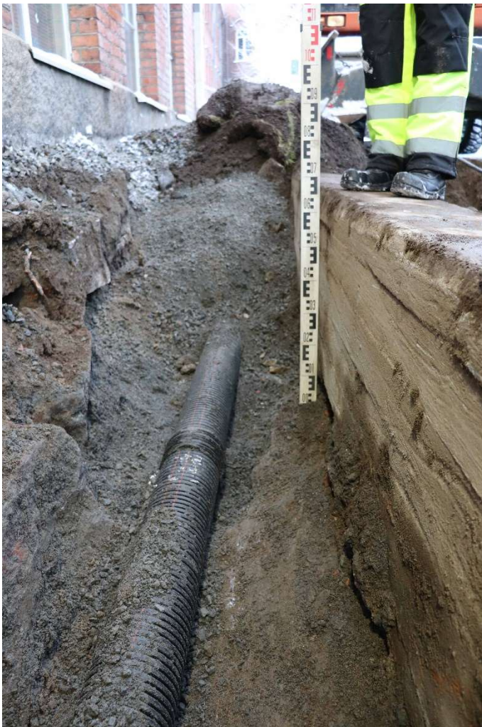
Kuva 22. Rakenne B1:n länsiseinä kuvattuna etelälounas. (Kuva: Tampere Frenckell 2019:12)
