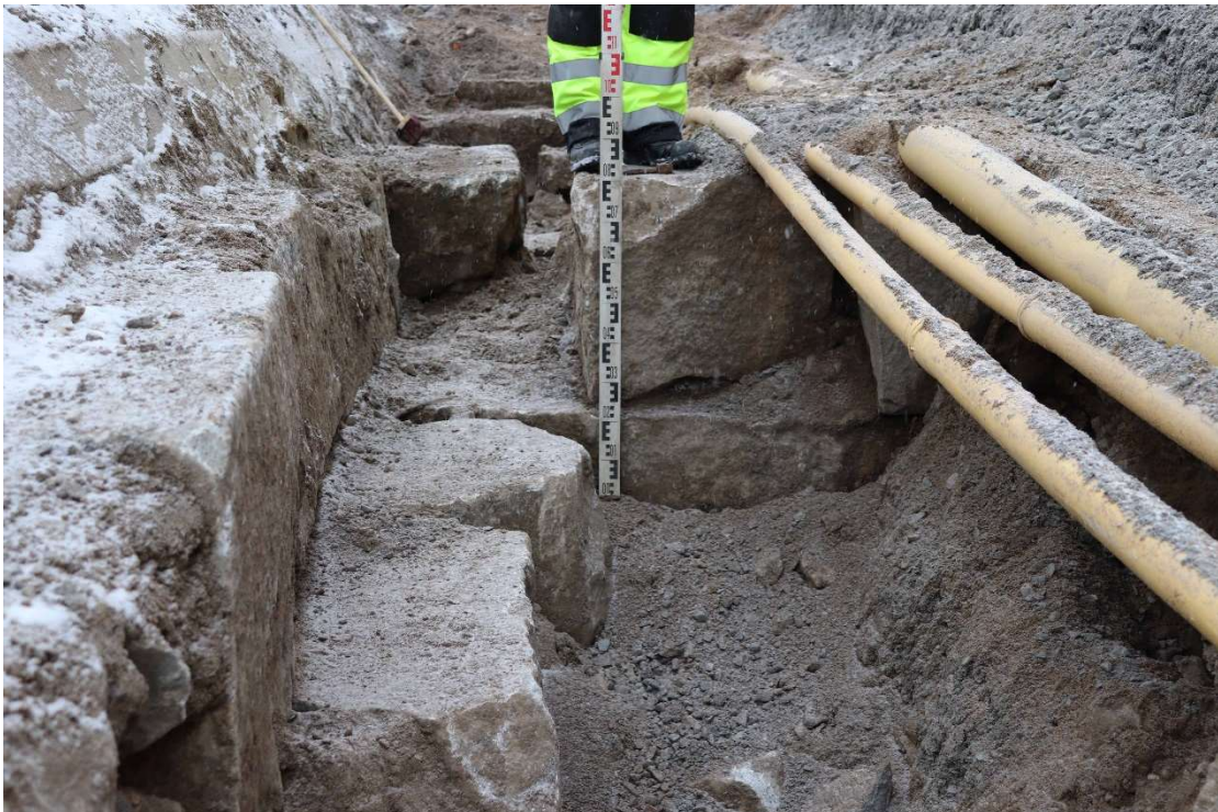
Kuva 35. Rakenne C3 kuvattuna pohjoisesta. (Kuva: Tampere Frenckell 2019:16)
