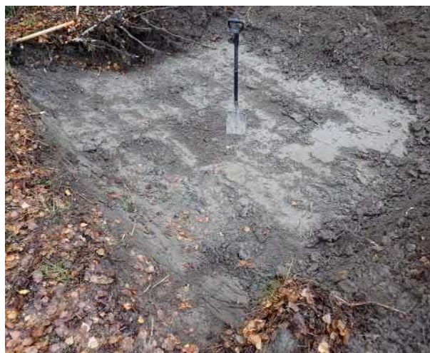
Knaapintie 3:n muuntamokaivanto pohjaan kaivettuna. Peltokerroksen alla erottuu puhdas harmaa savi. Koillisesta.
