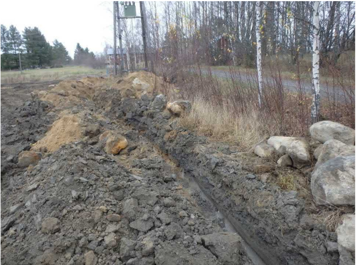
Kaivannon keskiosaa, jossa pohjamaa muuttui hiekkamoreenista vaaleaan saveen. Etelästä.
