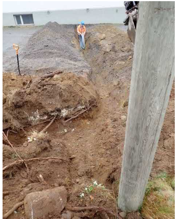
Koulurakennuksen seinään pihan poikki johtanut linjaosuus avattuna. Lännestä.
