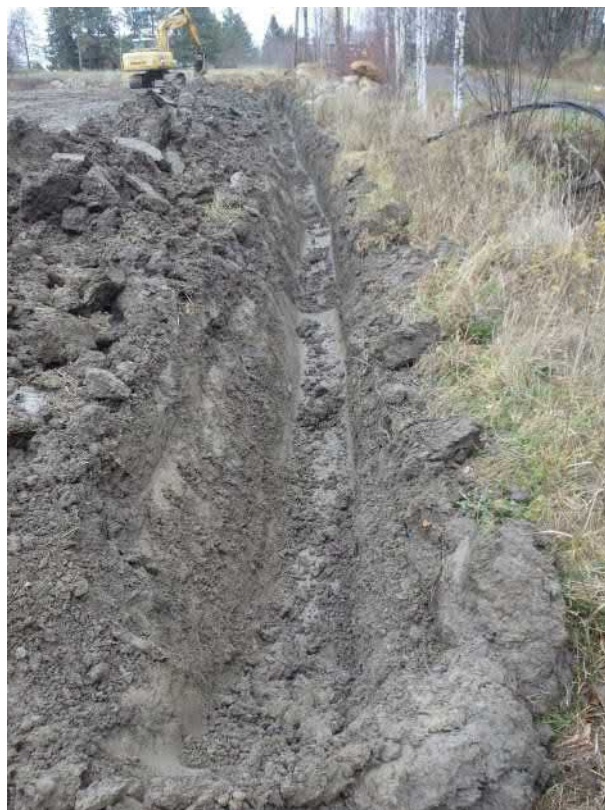
Valvotun kaivannon eteläpää. Etelästä.
