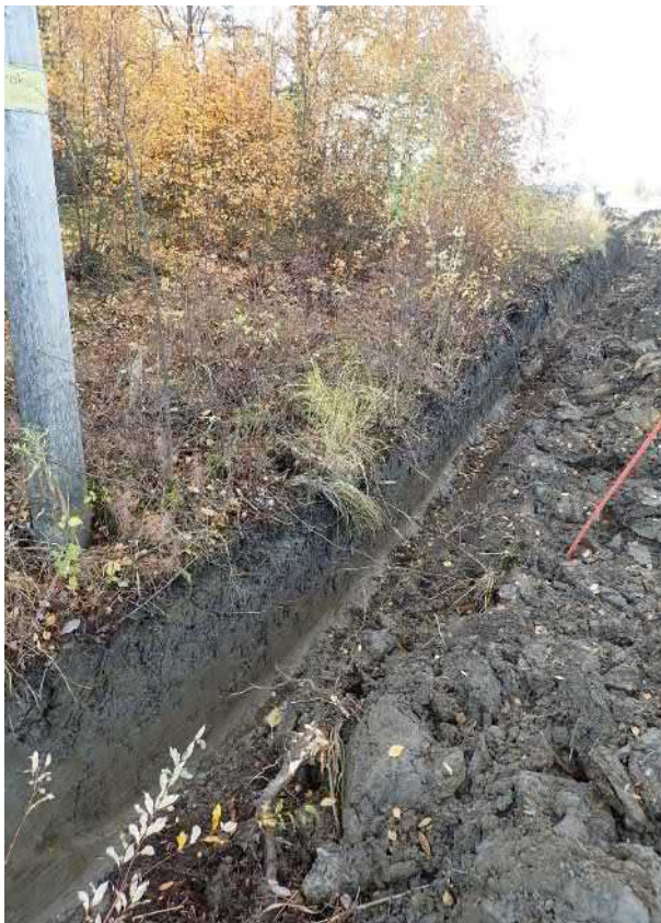
Kaapelikaivantoa Papumäen metsämaaston kohdalla. Koillisesta.
