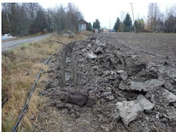
Kaapelikaivannon kulku sen pohjoispäästä katsottuna. Pohjoisesta.
