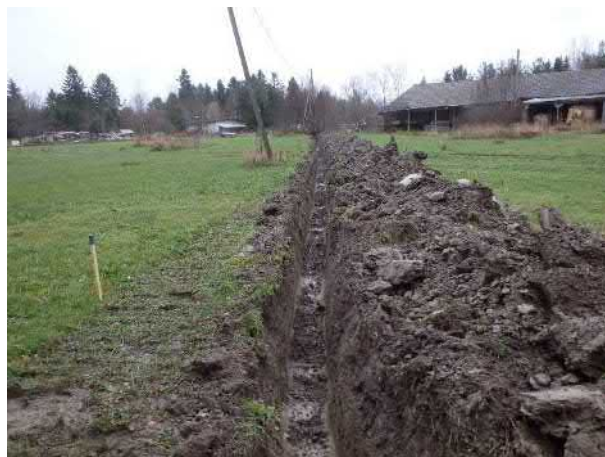
Nokkakyläntien itäpuolista kaivantoa, kaivannon mutkasta (luoteesta).
