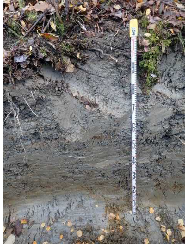
Kaapelikaivannon leikkausta Papumäen metsämaaston kohdalla. Puhdas savi alkaa heti pintaturpeen alta.
