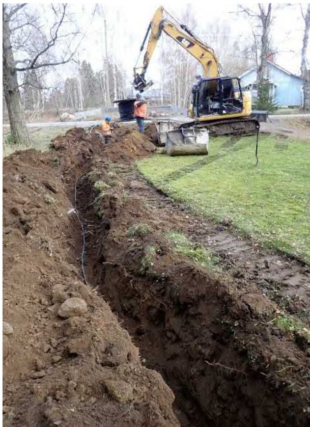
Kaukolantien länsipuolen pihapiireistä kohti koillista suuntautunutta osuutta. Kaivinkoneen takana Kaukolantietä. Länsilounaasta.
