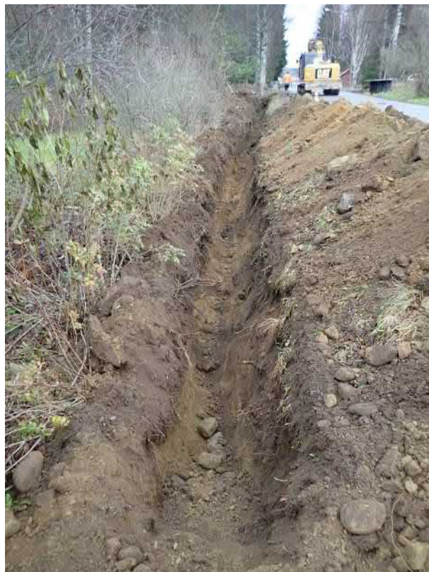
Kaapelikaivantoa Kaukolantien varressa, pohjoisemman alituskaivannon eteläpuolella. Etelästä.
