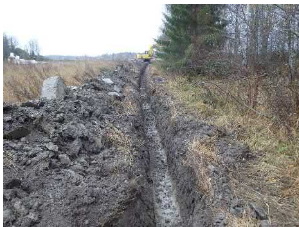
Nokkakyläntien itäpuolista kaivantoa, kaivannon mutkasta (idästä).
