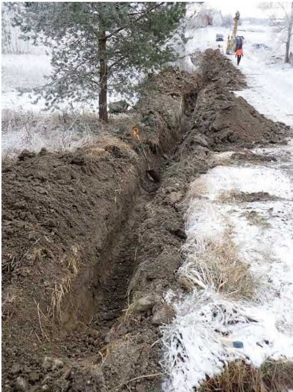
Valvotun linjan eteläosa. Pohjoisluoteesta.
