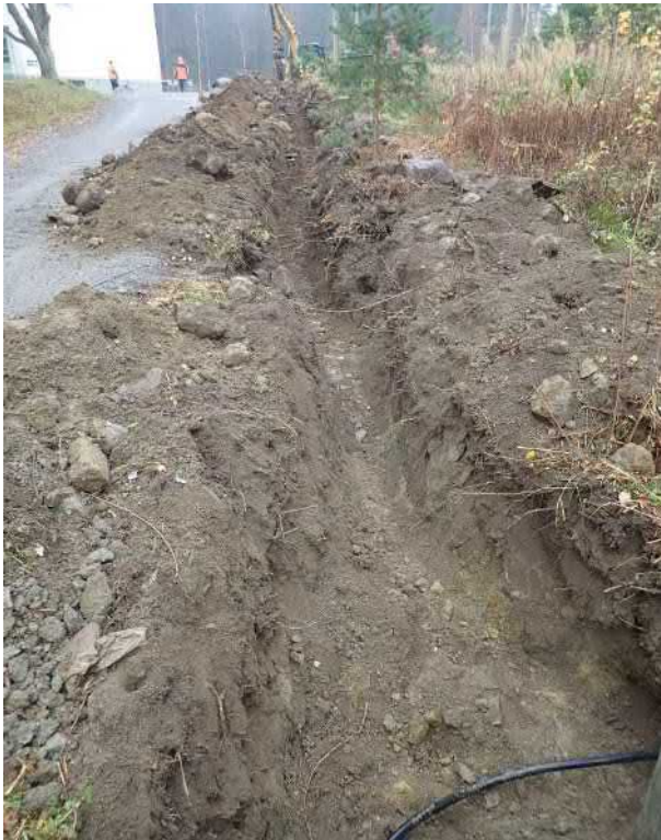
Kaivantoa rinteessä pellon eteläpuolella. Koillisesta.
