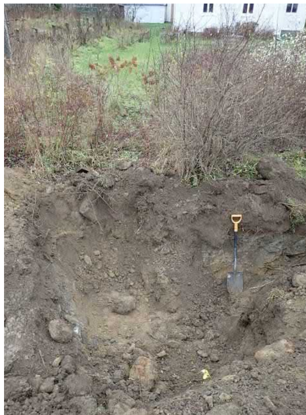
Jakokaapin kohdalle tehty kaivanto. Idästä.
