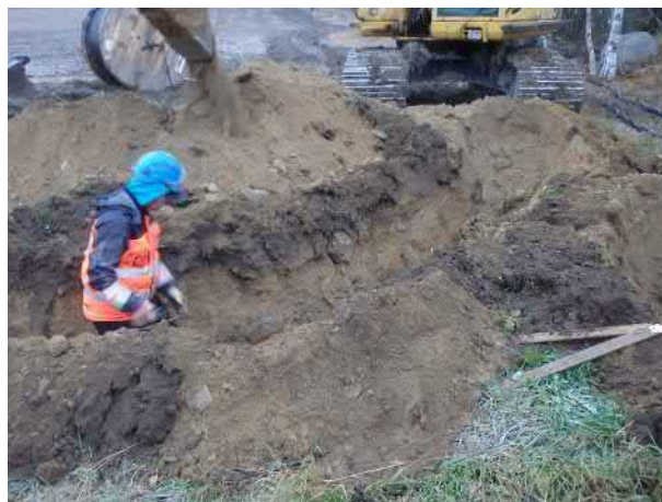
Kaapelikaivantoa kaivetaan Pukintien ja Nokkakyläntien risteyksessä. Etelästä.
