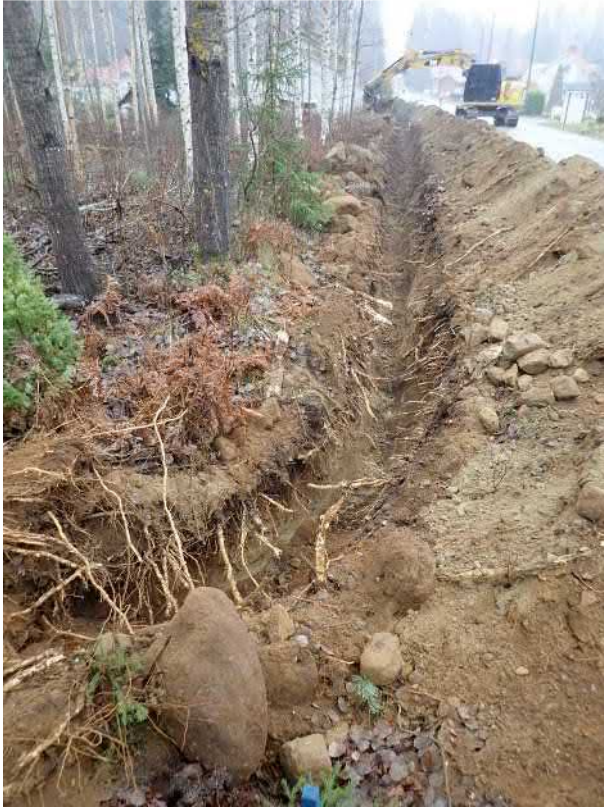
Kaukolantien kaivannon eteläisin pää. Etelästä.
