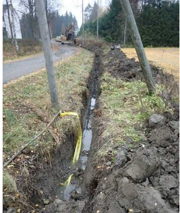
Kaapelikaivantoa koulun pohjoispuolella, pellon reunassa. Koillisesta.
