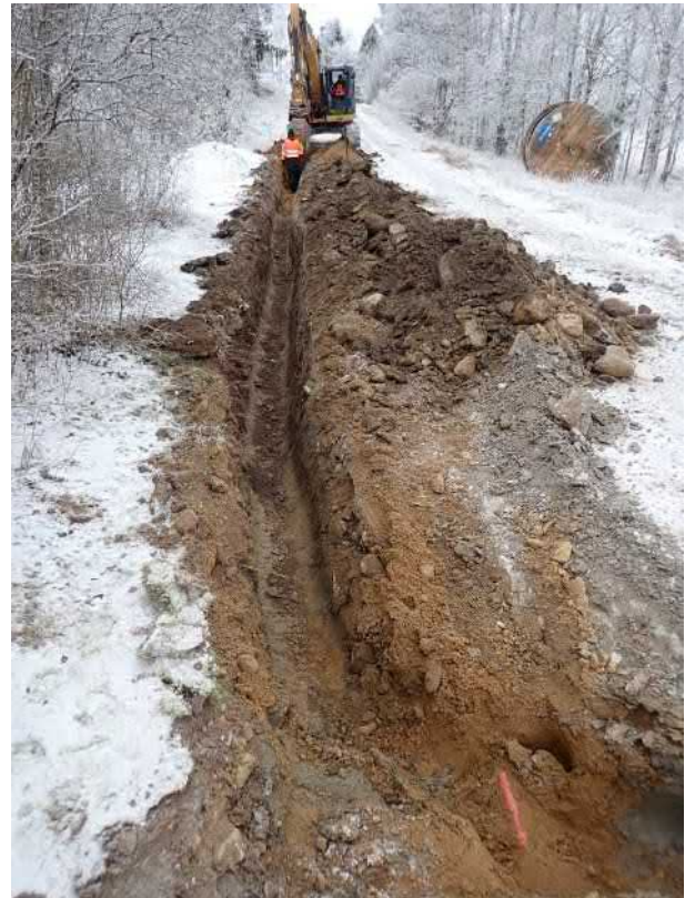
Valvotun linjan pohjoisosa. Eteläkaakosta.
