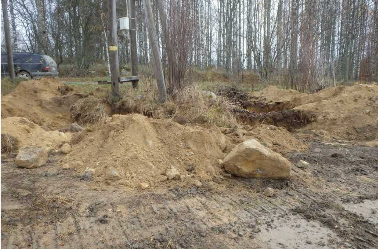
Pylväsmuuntajan ympärille kaivettuja kaivantoja. Lännestä.
