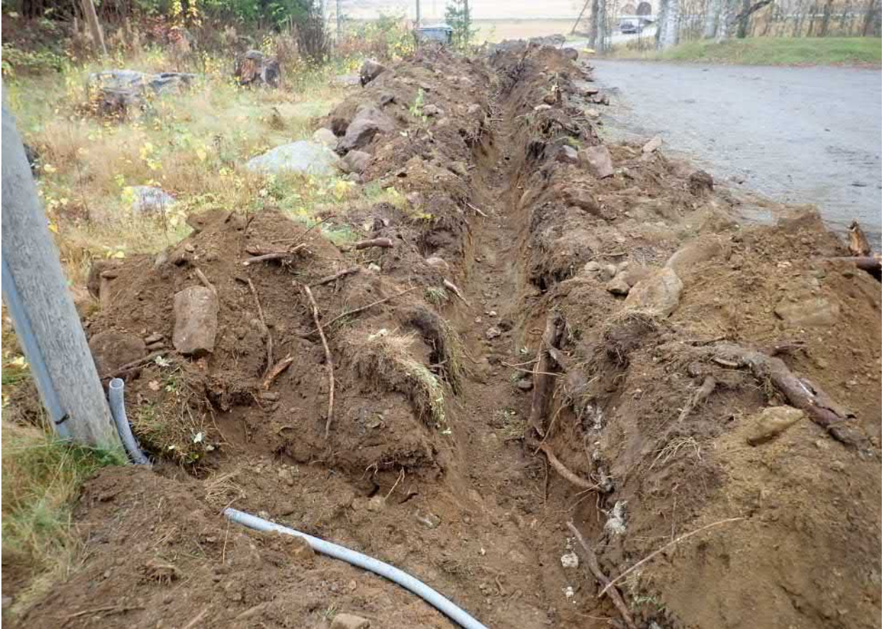
Koulun pihan reunan kaapeliosuus. Vasemmalla näkyvä joutomaa on vanhaa ilmajohtokäytävää. Siinä sijaitsevat alueelta vuonna 2002 kartoitetut kolme röykkiötä. Etelästä.
