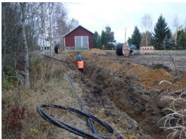
Kaapelikaivantoa kohdalla, jossa pintamaa muutuu saveksi. Pohjoisesta.
