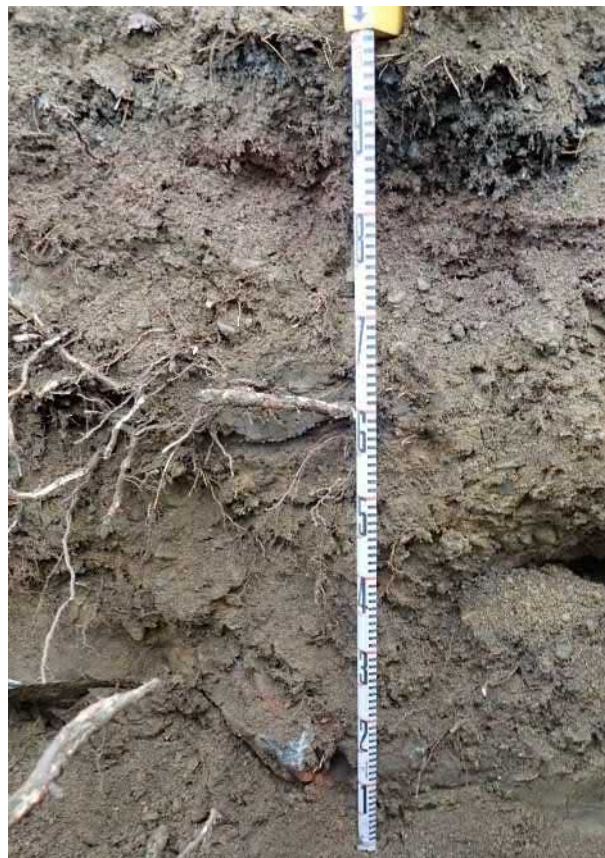
Kaukolantie 163:n risteyksen kohdalta noin metrin syvyydestä todettu tiili (mitan numeron 2 vasemmalla puolella) kaapelikaivannon leikkauksessa.
