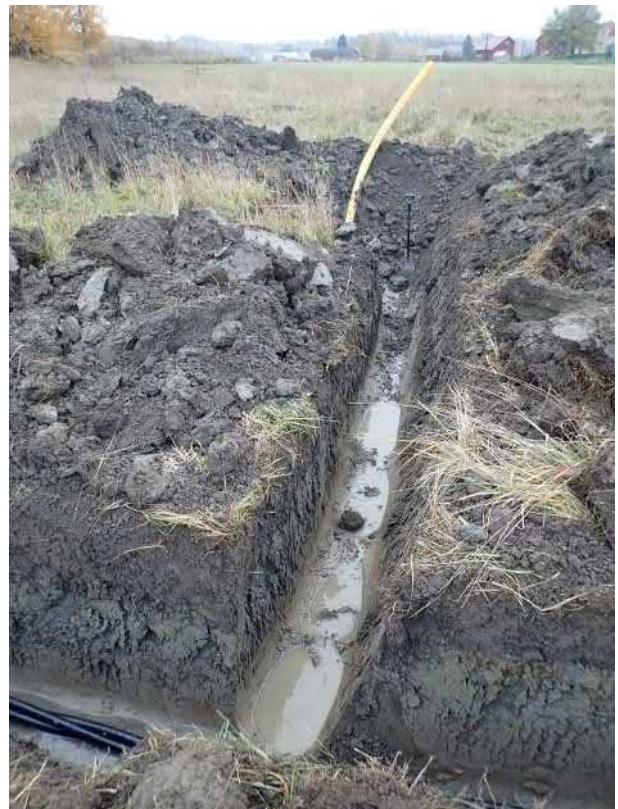
Pohjoinen–etelä-suuntainen kaapeliojan osuus ja sen päässä kohdassa N 6806244 E 280864 ollut laajennus (keltaisen putken kohdalla). Pohjoisesta.
