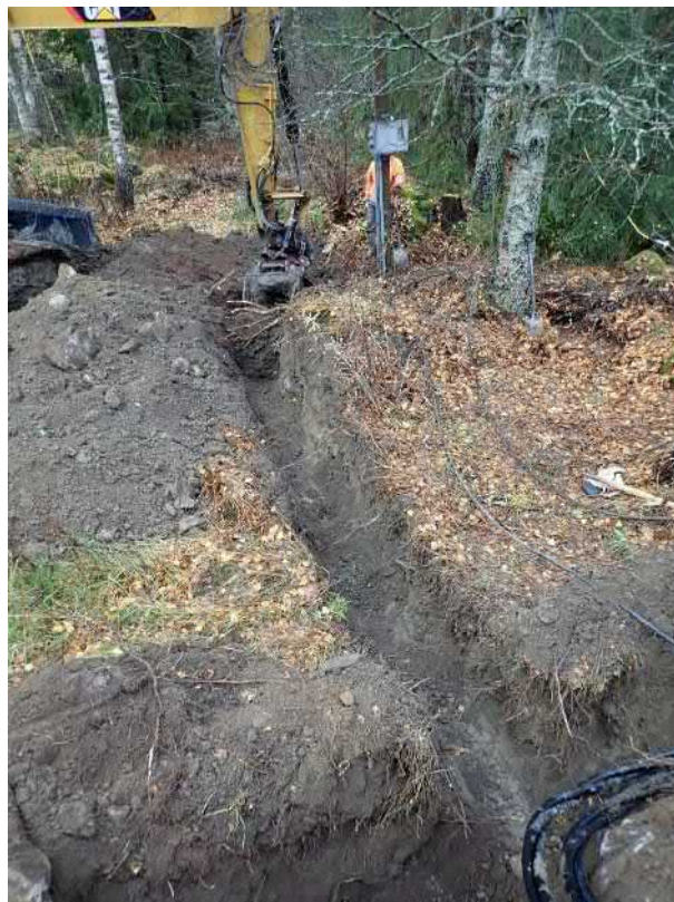
L-kirjaimen muotoinen kaivanto mittauskeskukselle kohtaan N 6807338 E 277829. Idästä.
