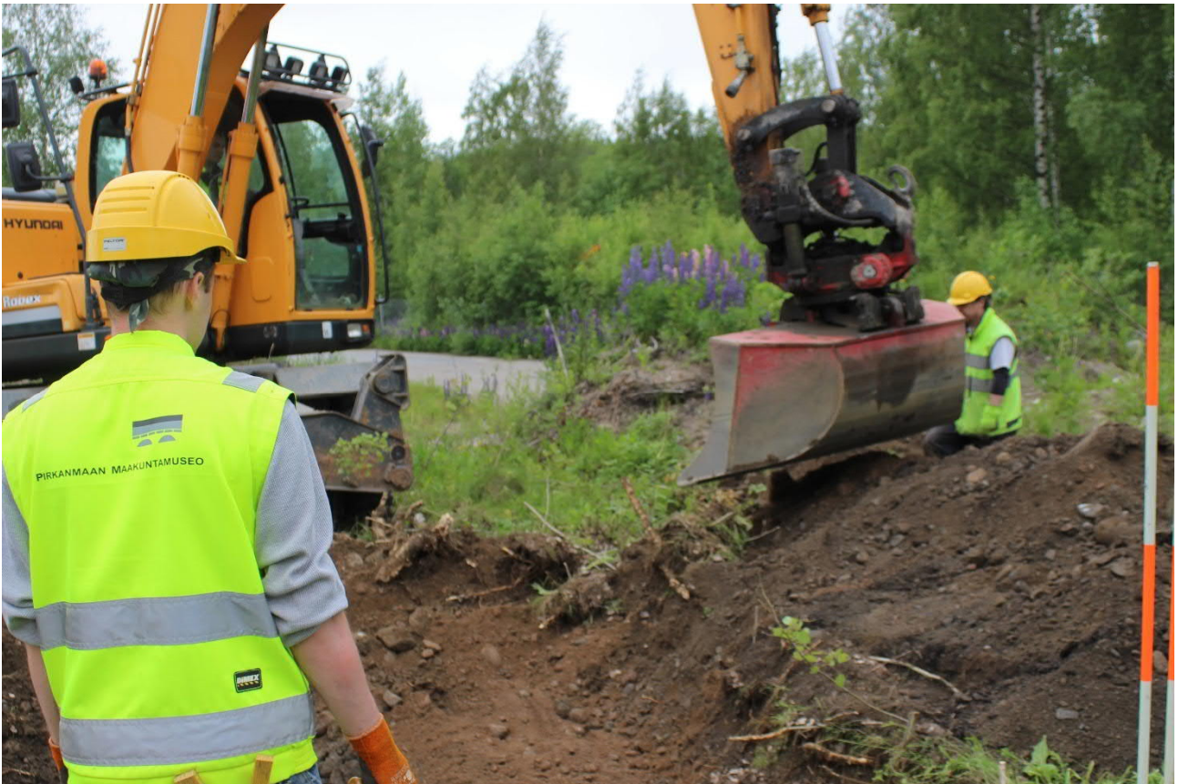
Kuva 8. Koneellista kaivuuta Alueella 2. Kuva: Ninni Närväinen KYY 351:91.
