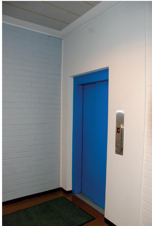
Käytävätiloja ja uusittuja väliovia.
