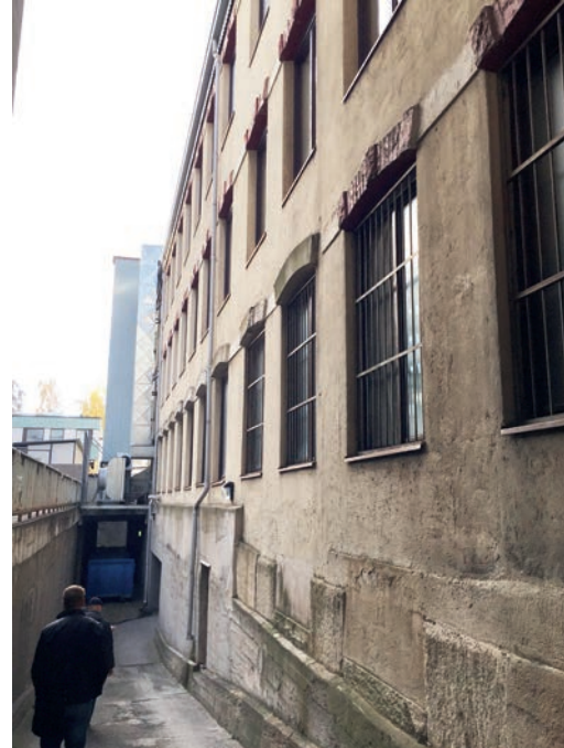
Huoltoramppi, taustalla näkyy jätekuilu.
