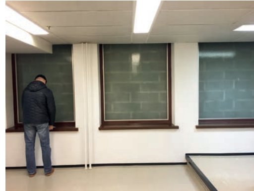
2. kerroksen käytävän sisäpihalle aukeavat ulkoikkunat on muurattu umpeen.
