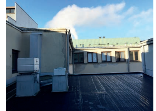
Vanhimman rakennusosan huopakaton päälle on tehty iv-konehuone ja muita iv-asennuksia.
