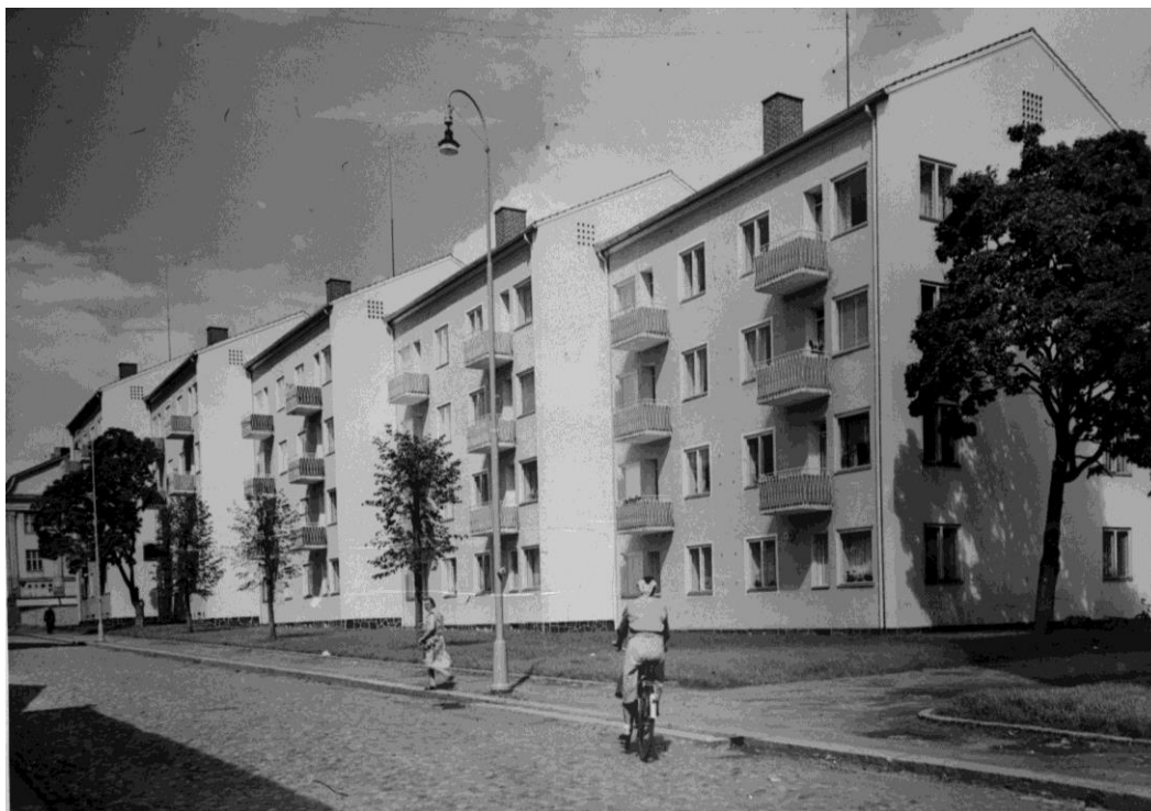
Kuva 14. Ensimmäisen rakennusvaiheen uutta modernia arkkitehtuuria, maalausta vaille valmiina. Veikko Kanninen. Vapriikin valokuva-arkisto D/341 alb8:225.
