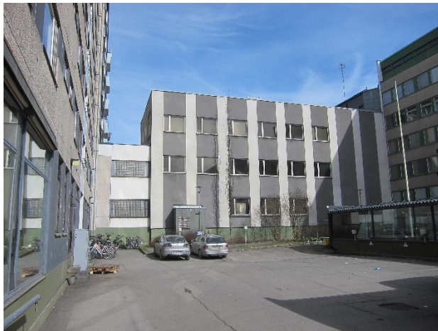
Kuva 5. Eteläjulkisivu Puutarhakadulle, kevät 2018
