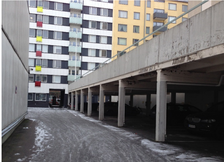
Kuva 12. Sisäpihan pysäköintikatos ja konttorirakennus kuvattuna idästä
