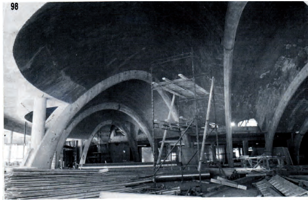
Työmaan aikana otettuja rakennekuvia lainausosaston betonikaarista. Kuvat Metson arkisto.
