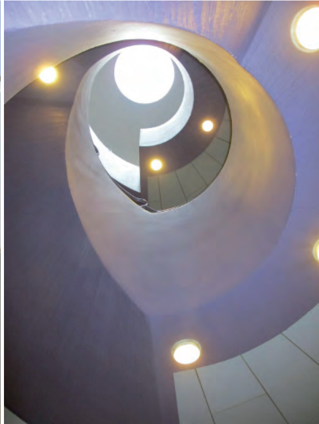
Lainausosaston porras on lilan värinen. Porrasyöksyjen alapinnassa on akustoivat levyt. Portaan katossa on kattoikkuna. Lattian pintamateriaali on vinyylilaatta.
