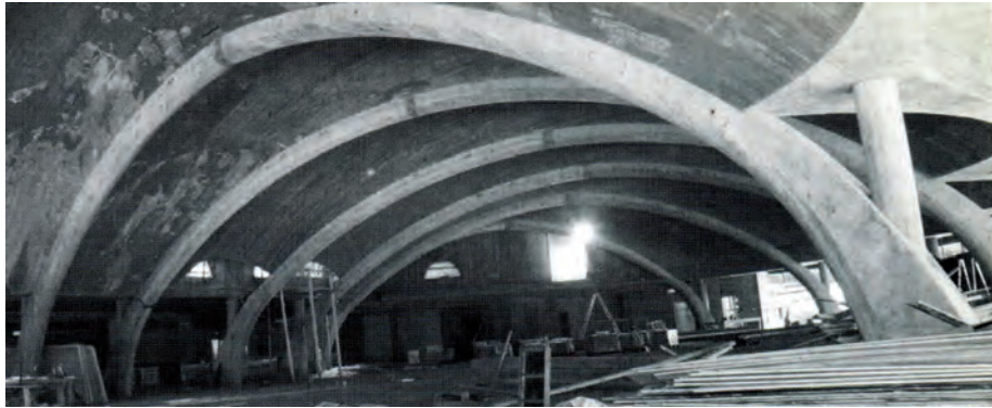
Työmaan aikana otettuja rakennekuvia lainausosaston betonikaarista. Kuvat Metson arkisto.
