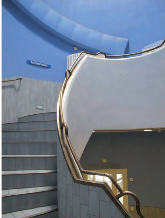
Pääaulasta lähtevä sininen pääporras johtaa parvikerroksen kahvilatasolle ja 4. kerroksen iv-konehuoneeseen. Lattian pintamateriaali on keraaminen laatta, käsijohde on messinkiputkea.
