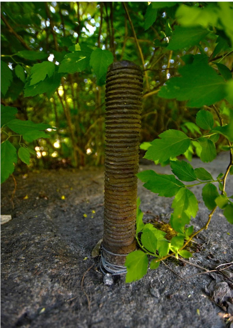
Kuva 23: Hammastettu rautapultti tukkitien betonianturassa (ennestään tunnettu kohde Pispalan tukkitie 1). Kuva: Ulla Moilanen, KYY 291:14.
