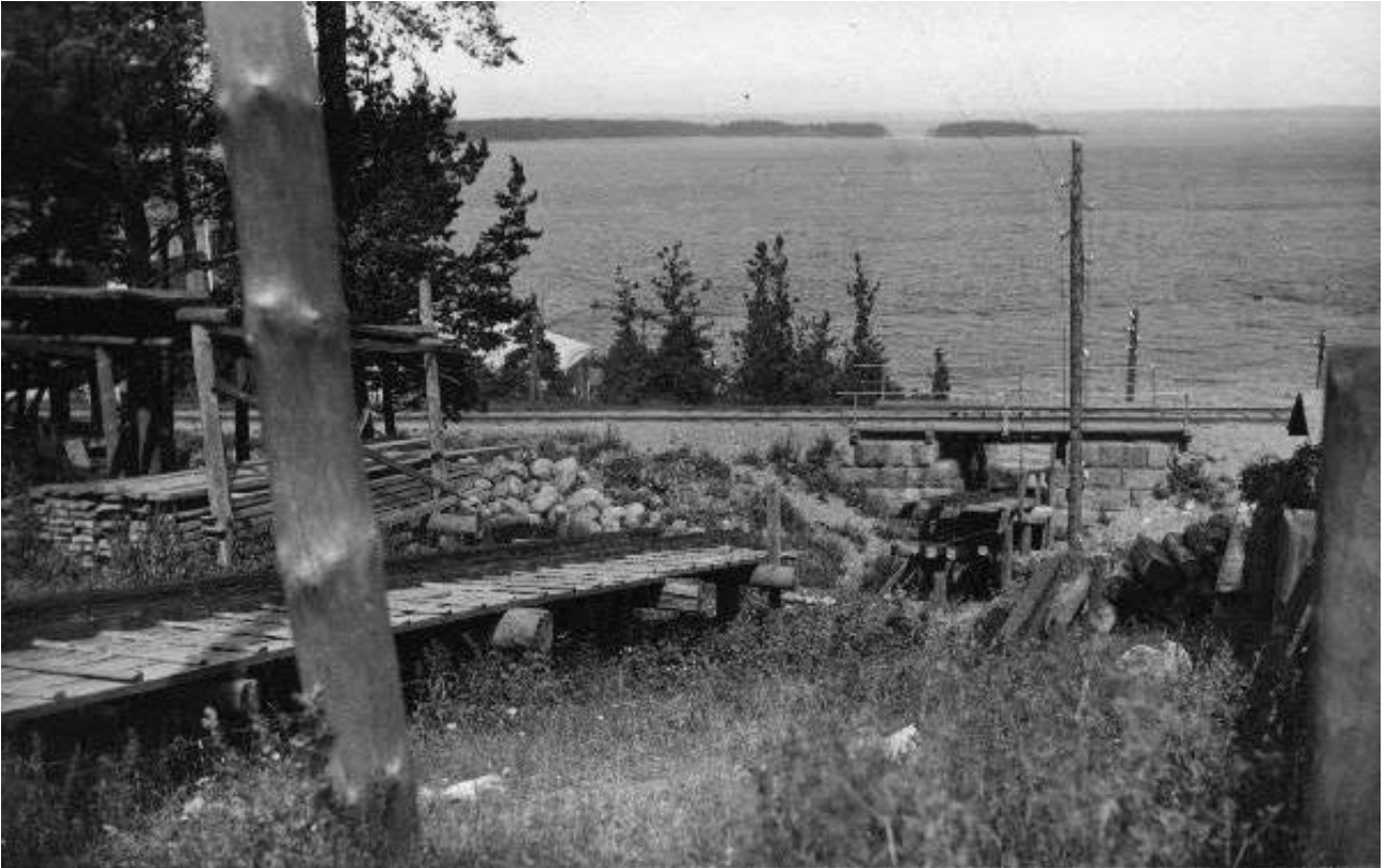
Kuva 1: Punaisen tukkitien Näsijärven puoleinen osa. Kuvassa erottuu kiskotie sekä kivirakenteinen Porin radan alittava tunneli. Kuva: Vapriikin kuva-arkisto.
