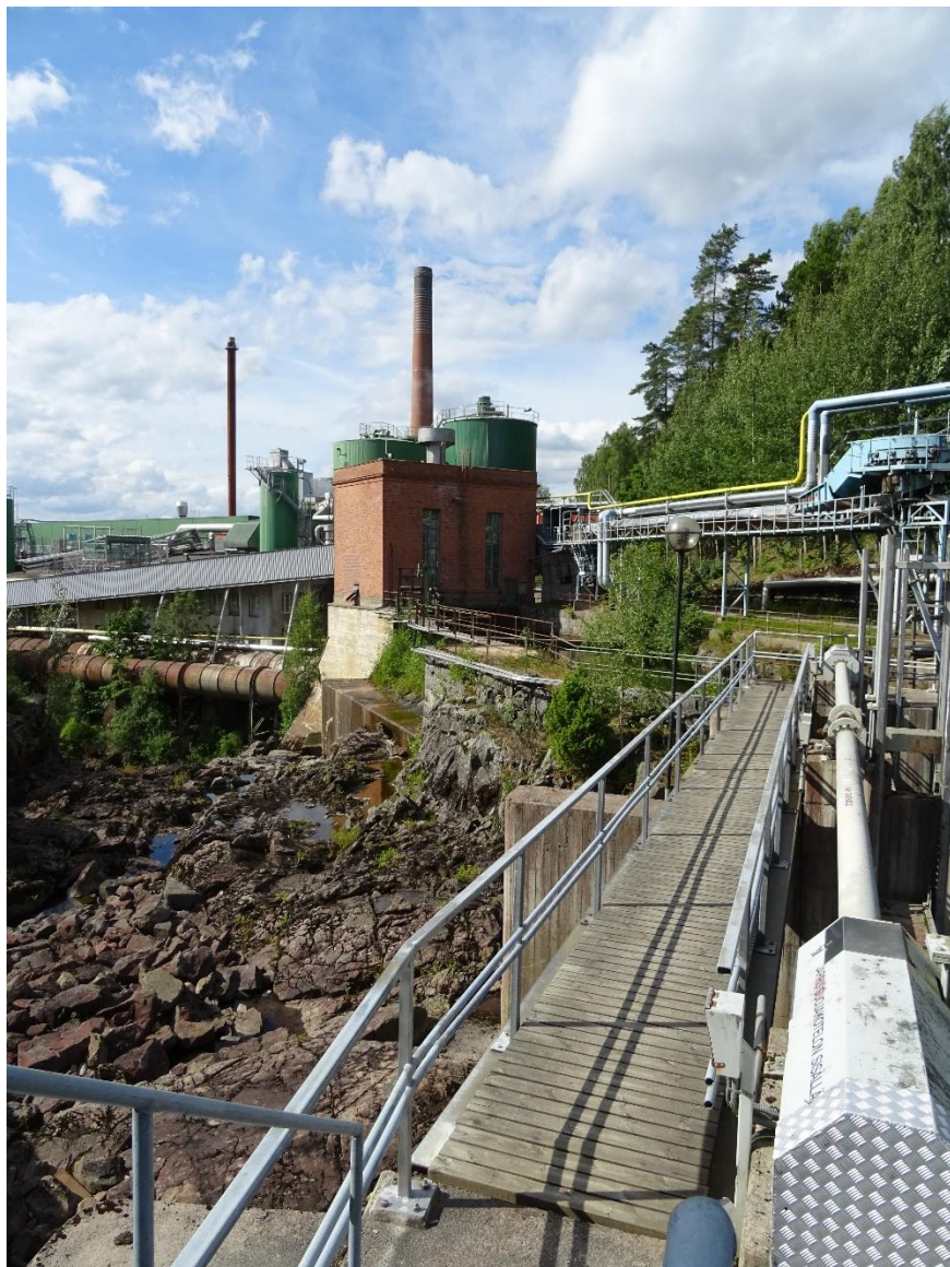
Tehtaan koilliskulman rakennuksia, pato ja sähkölaitos. Oikealla hiomo, taustalla 1920-luvulla rakennetun turvetorнин telttakattoinen huippu ja tehtaan piippu
