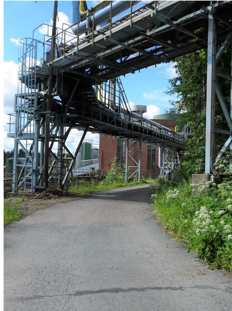
Kuvat: Vasemmalla ylhäällä päärakennus, alla ulkorakennus. Oikealla Koivurannan ohi kulkeva puunkuljetusrata tehdasalueen puolelta
