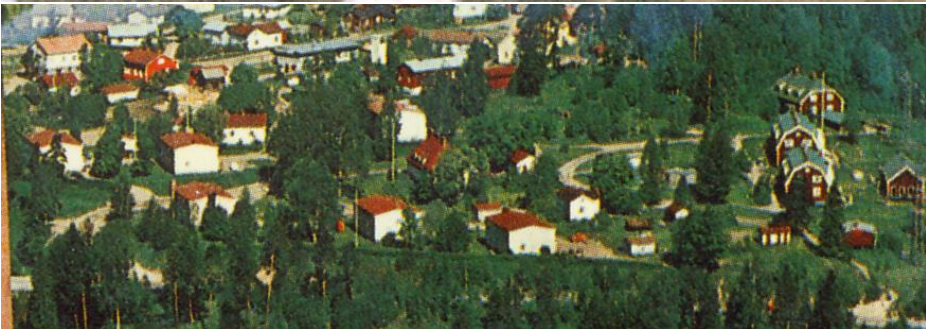
Yllä Ole Selvaagin suunnittelema koetalo Ekeberg vuodelta 1948. Rakennuksia kutsuttiin Selvaagintaloksi myös Norjassa (Selvaag-huset). Alla näkymä Selvaaginmälle, kun talot ovat juuri valmistuneet. Oikealla kuvassa näkyvät Petsamon talot purettiin 1980-luvulla. Alue on jäänyt rakentamattomaksi puistoksi. (Kuvat Kyröskosken perinneyhdistyksen arkisto)
