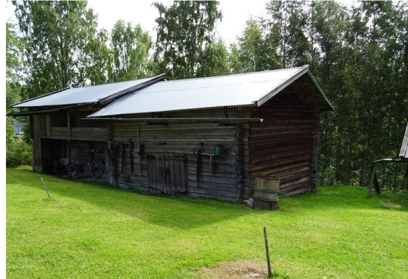
Vasemmalla päärakennus (r1), oikealla luhti ja varasto (r2)
