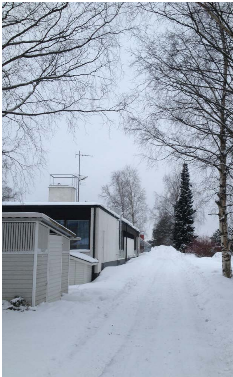
Huoltoväylän vasemmalla puolella näkyvät uusi jätekatos ja kellarin hätäpoistumisreitti.
