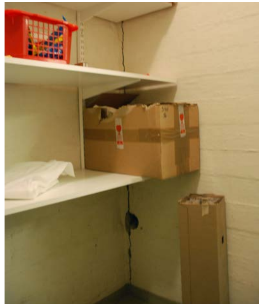
Yllä: Seurakuntasali nykytilassaan. Alla: Halkeama kellarin seinässä.
