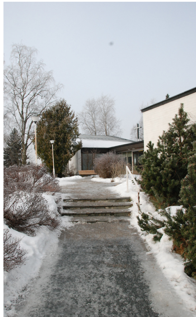
Sisääntuloväylä pääoville. Alkuperäiset portaat ja myöhemmin rakennettu kaide.
