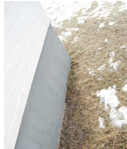
Yllä: Eteishallin paljeovi. Alla: Sokkelin vierustalta puuttuu sorastus.
