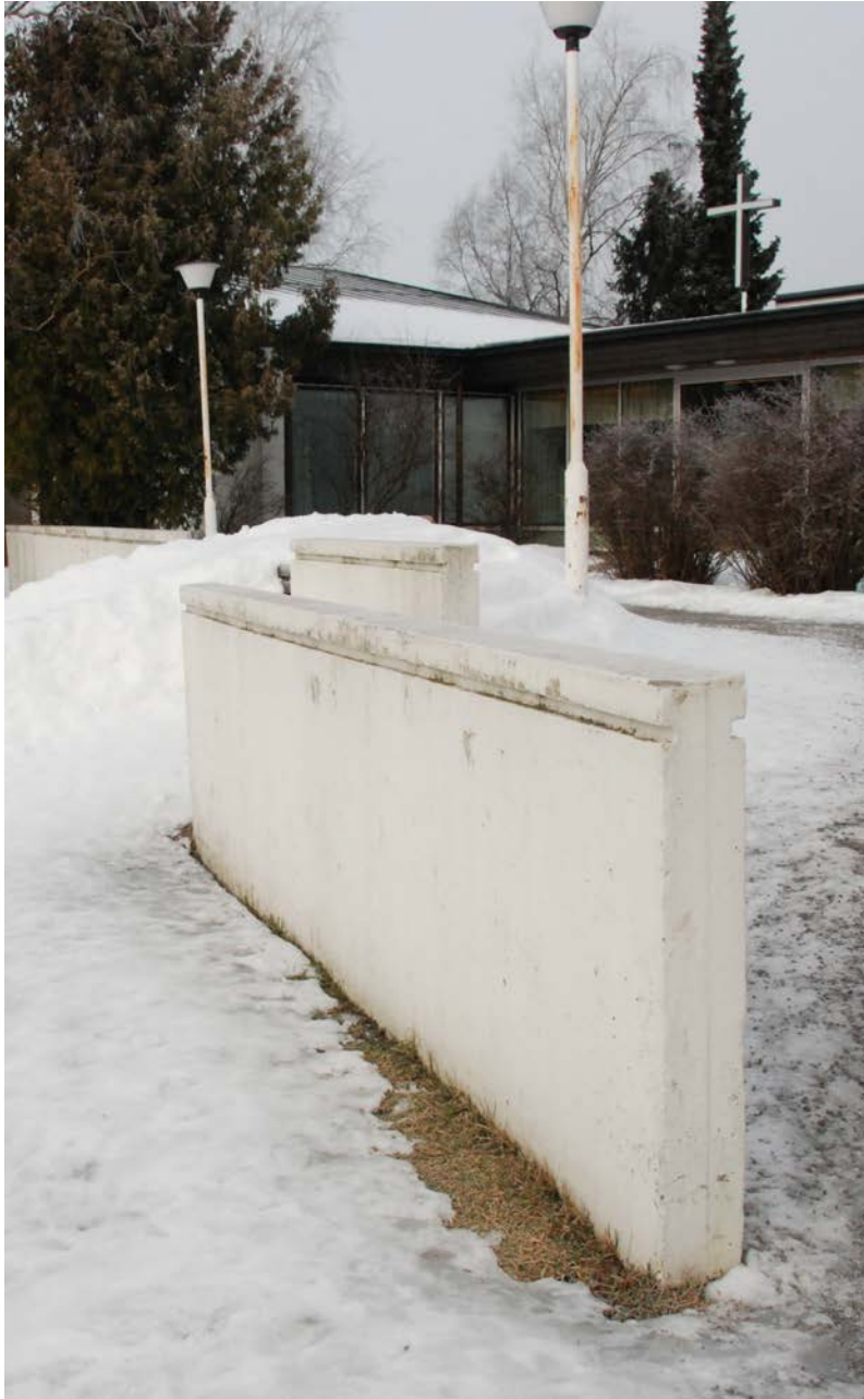
Alkuperäiset betoniaidat ovat yhä tallella - tosin puuosat on purettu pois.
