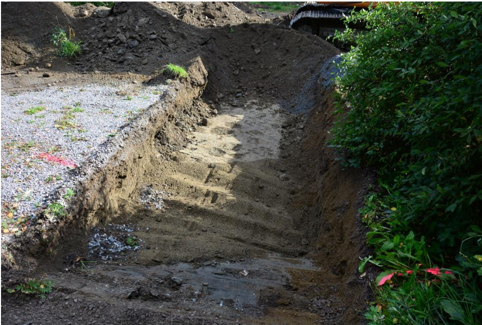
KYY300:40 Tampere, Pappinen 2018. Koeoja 4 länneestä. Etualan värierio on moderni kaapelikaivanto. Kuva: Ulla Moilanen
