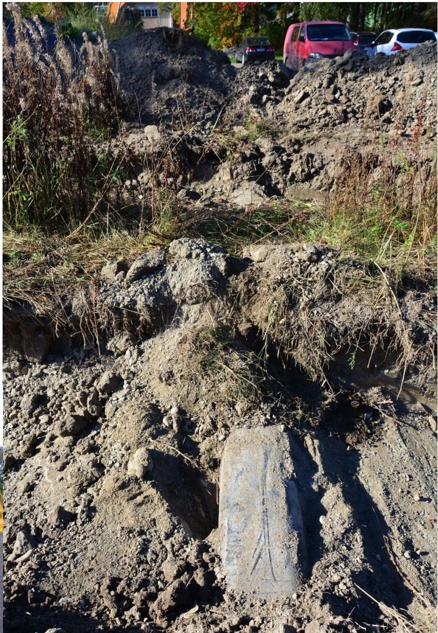
Kuva 11. Koeojien poikki kulkeva lämpöputki. Etualalla koeoja nro 1, taustalla koeoja 2. Kuva: Ulla Moilanen (KYY300: 29).
