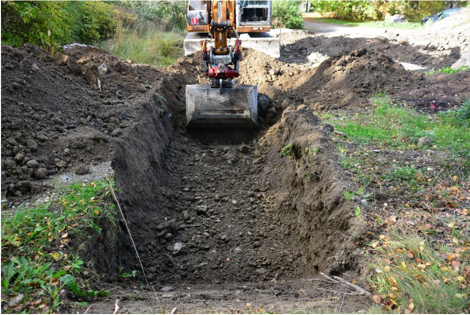
Kuva 15. Koeojaa 5 kaivetaan. Kuva: Ulla Moilanen (KYY300:43).
