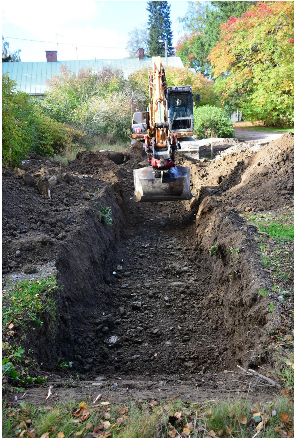
KYY300:44 Tampere, Pappinen 2018. Koejaa 5 kaivetaan. Kuva: Ulla Moilanen
