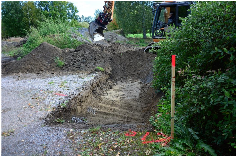
KYY300:41 Tampere, Pappinen 2018. Koeoja 4, jossa etualalla moderni kaapelikaivanto. Kuva: Ulla Moilanen
