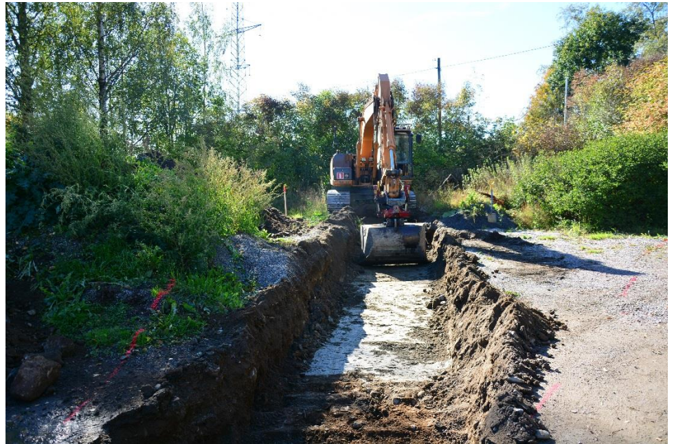
KYY300:22 Tampere, Pappinen 2018. Koeojaa 3 kaivetaan. Kuva pohjoisesta. Kuva: Ulla Moilanen
