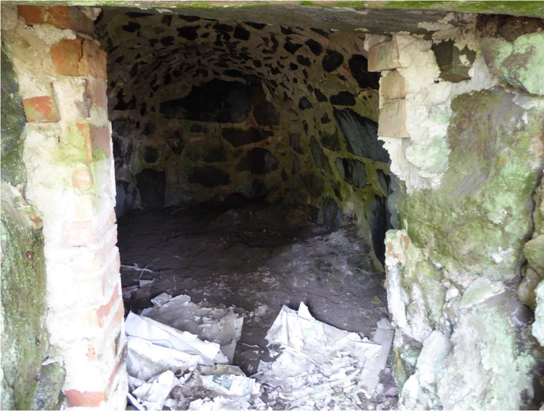
Kuva 12. Maakellarin oviaukon ja sisätilojen rakenteita. KYY290:19 Kuva: Ninni Närväinen
