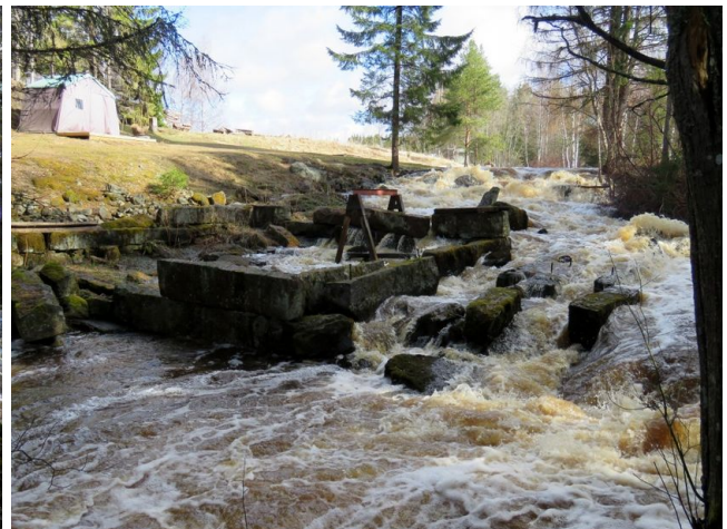
Sahan ja myllyn perustuksen jäänteet itäkoilliseen.
