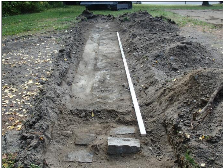
Koeajan nro 11 lohkokivirakenne ja betoniperustus. Taustalla Pispalan valtatie.
